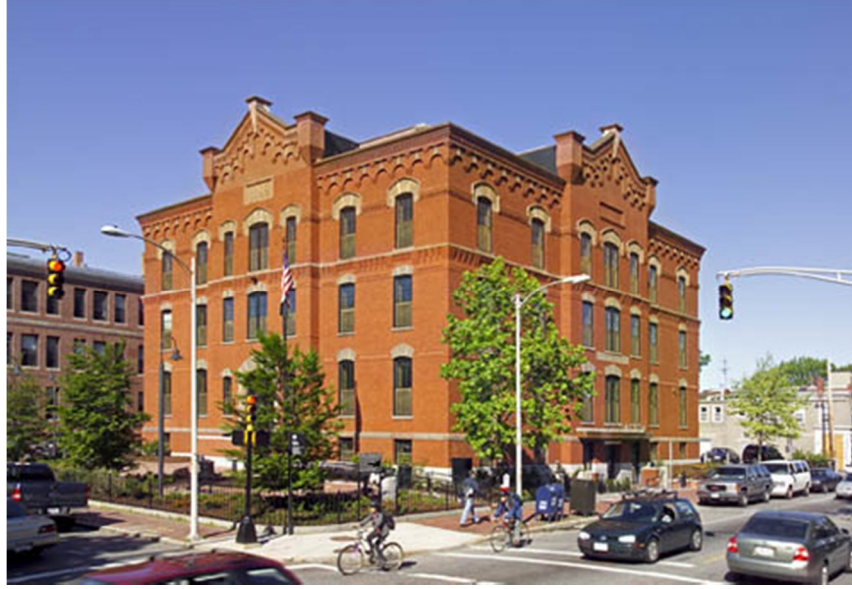
Şekil 4.1: Cambridge City Hall Annex binası
