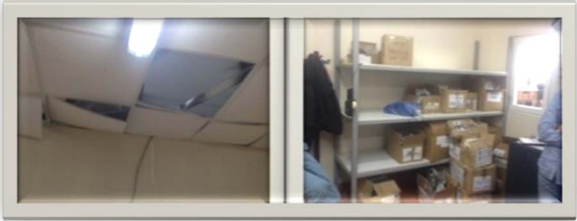
Resim 4. Temizleme Öncesi Aksesuar Bölümü
