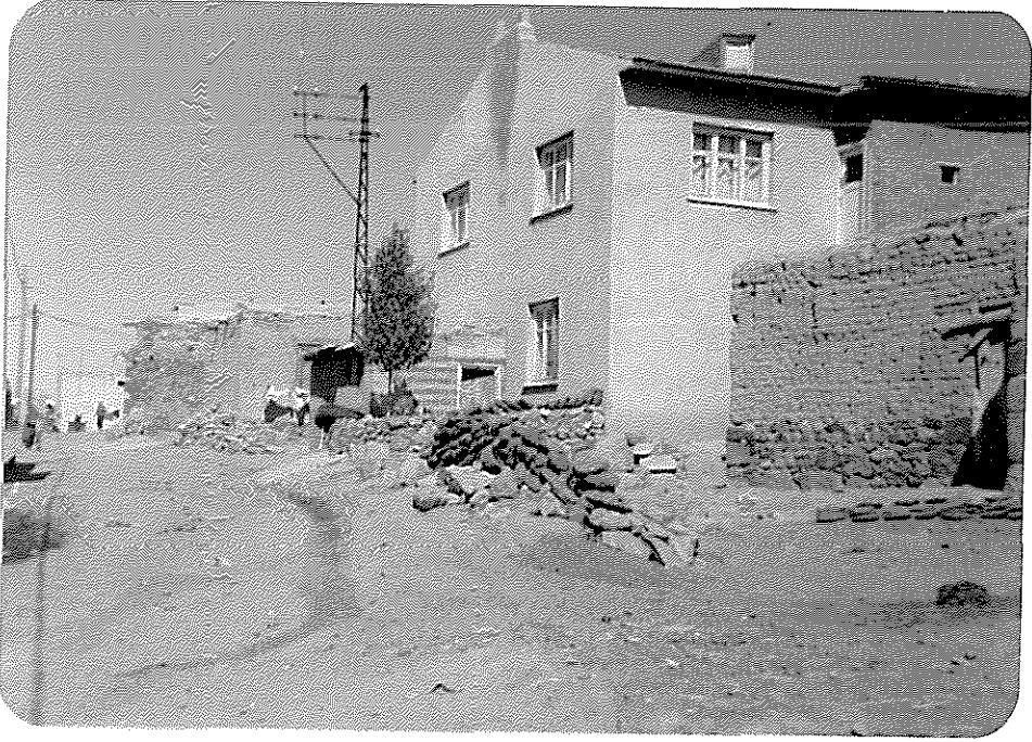
Foto 15 : İki Katlı Modern Konut, Sağ Tarafıta Kerpiçten İnşa edilmiş Eklentisi İle Birlikte Görülmekte
