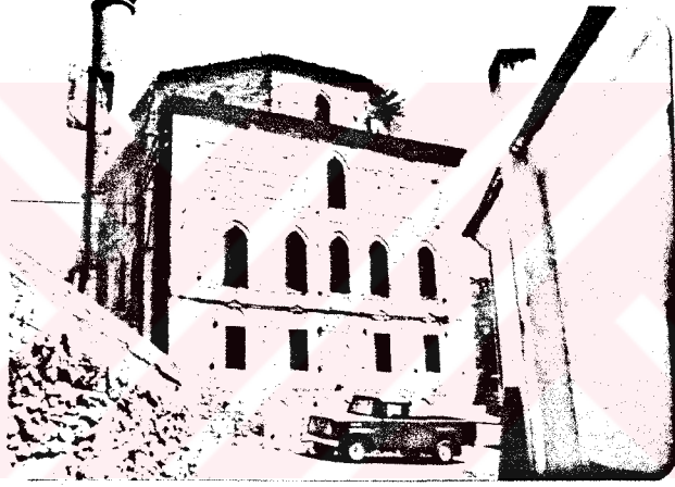
Resim 185: Kazdağlıoğlu Camii güney cephesi
