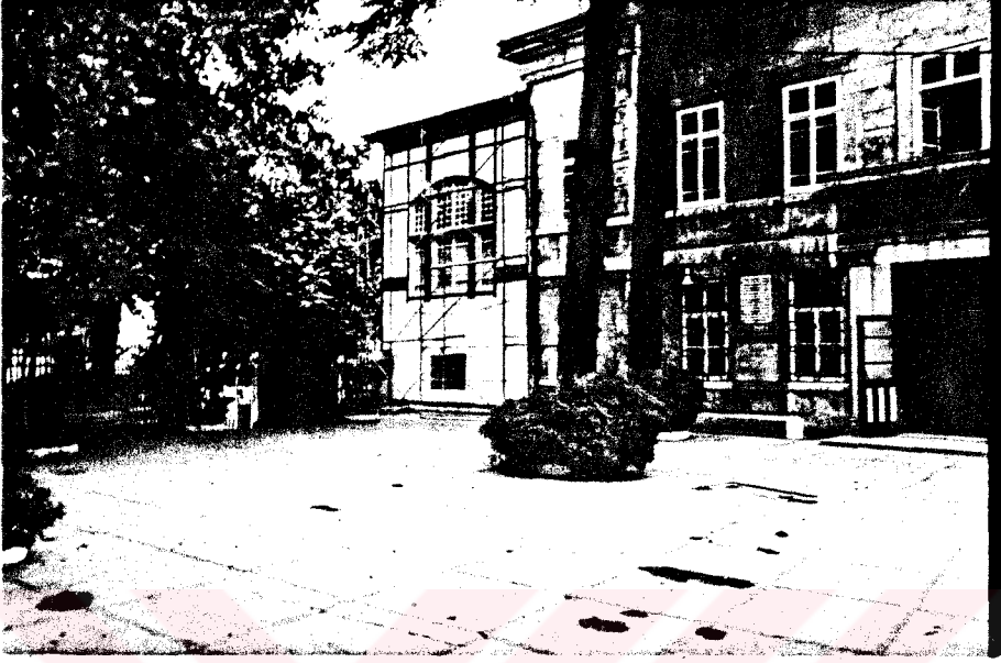
Resim 209: Emirgan Camii Hünkar kasrı kuzey cephesi
