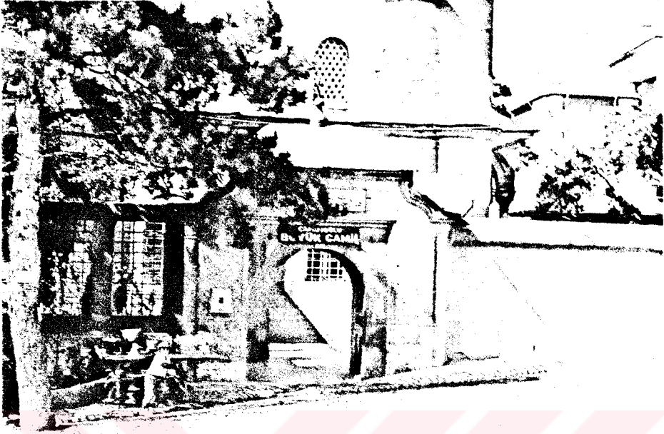
Resim 112: Çapanoğlu Ulu Camii doğu avlu kapısı
