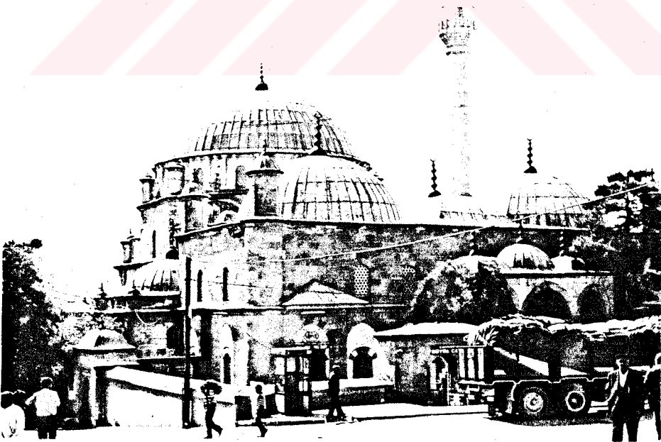
Resim 123: Çapanoğlu Ulu Camii kuzey cephesi
