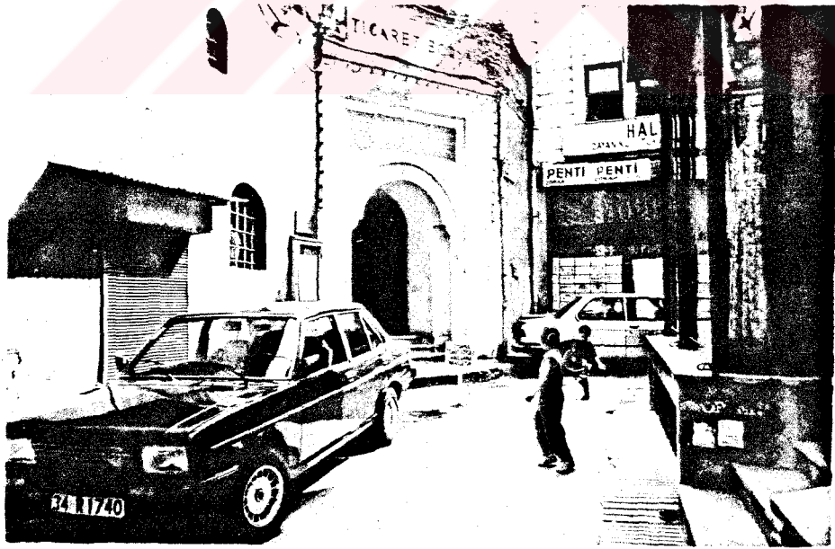
Resim 16: I. Abdülhamid Medresesi giriş cephesi
