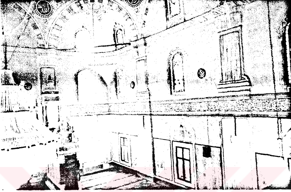
Resim 142: Çapanoğlu Ulu Camii birinci bölüm iç görünüş
