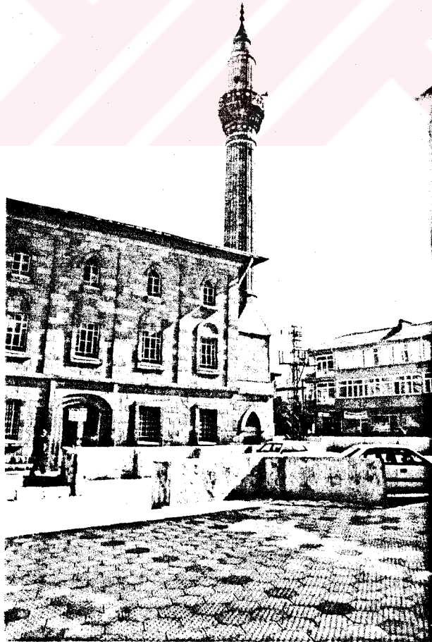
Resim 304: Hacı Abdi Camii kuzey cephe
