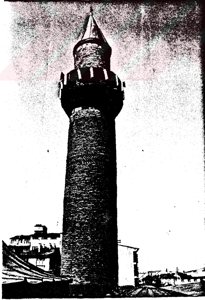
Resim 258: Cennetzade Camii minaresi
