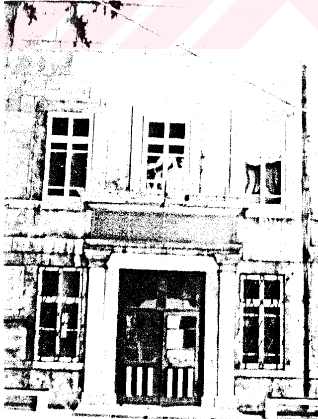
Resim 200: Emirgan Camii kuzey cephesi ve giriş kapısı
