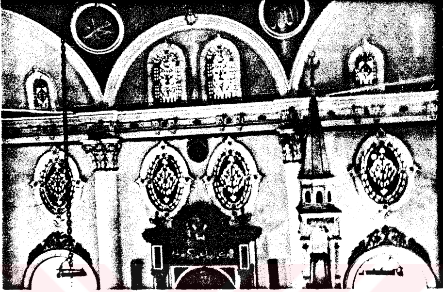
Resim 287: Başdurak Camii iç görünüş
