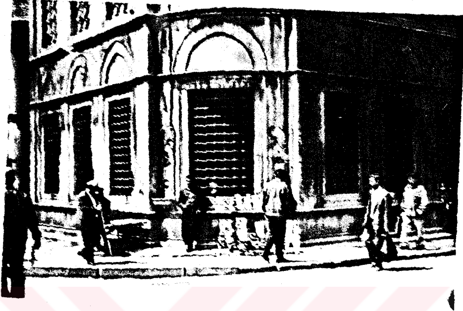
Resim 13: I. Abdülhamid Türbesi kuzey cephesindeki çeşmeler
