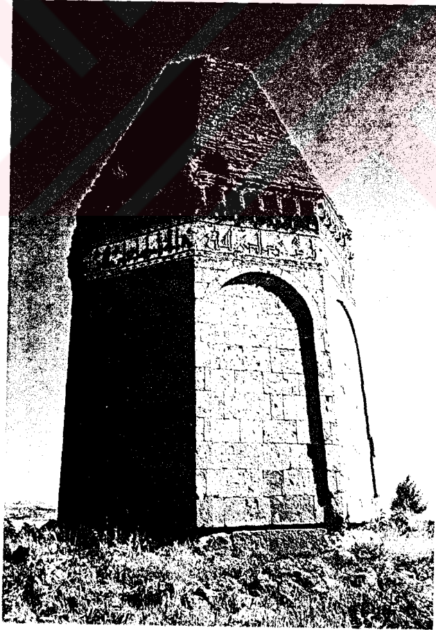
Resim 197 Aksaray Bekar Sultan Türbesi'nin cephe kemerleri
