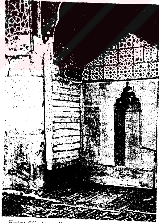
Foto: 56- Siva Raspaı Altından Çıkarılan Orijinal Taş Mihrap XVI. yy. Osmanlı Çinileri ve Bağdadî Kaplamalar.
