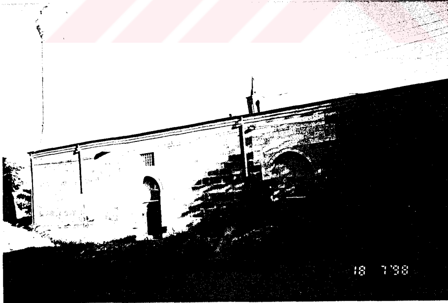
Resim 86 Kayseri Klk Camii Kuzey cephesi
