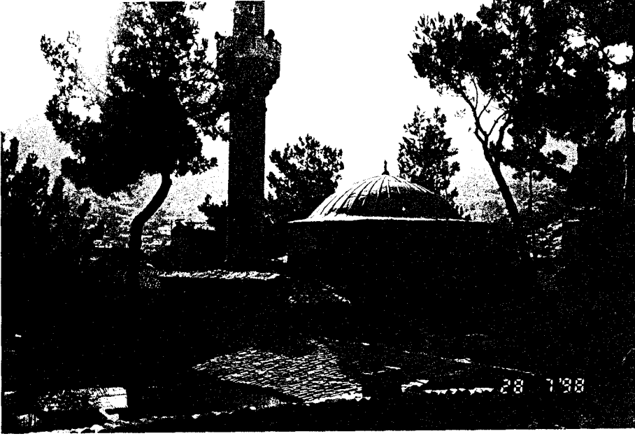
Resim 47 Küçük Ağa Camii üst örtüsü
