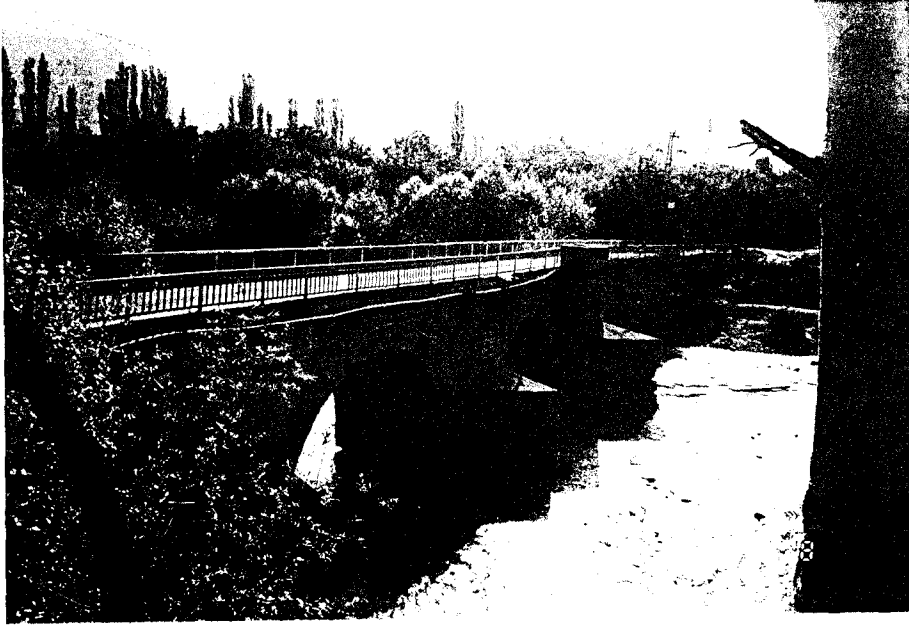
Resim 265 Amasya Çağlayan Köprüsü
