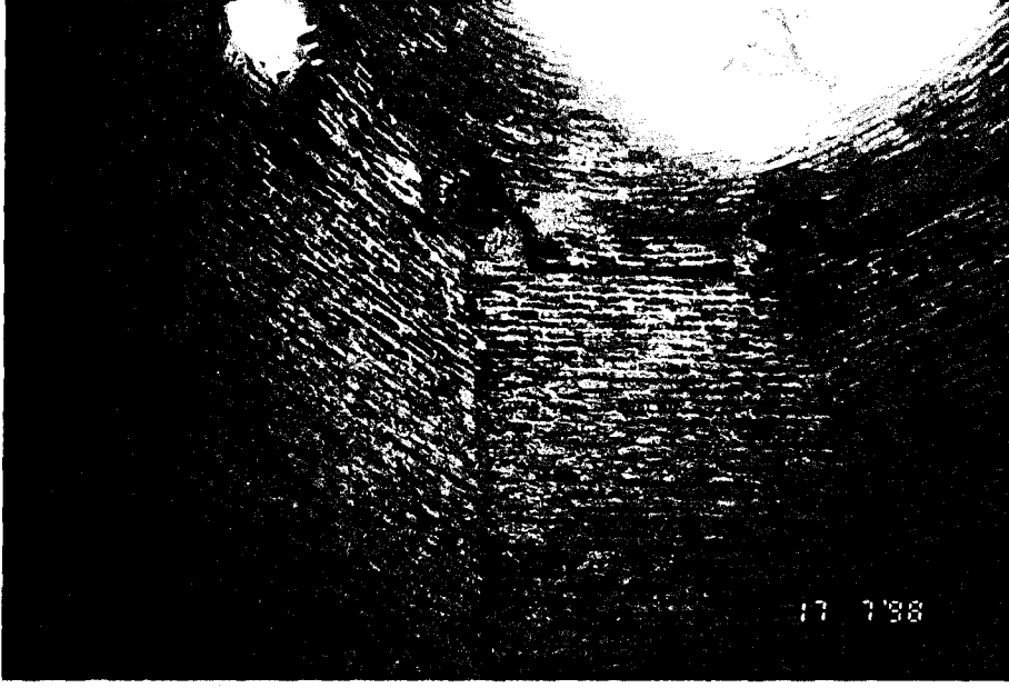
Resim 219 Kırkkızlar Türbesi'nin kubbeye geçiş elemanları
