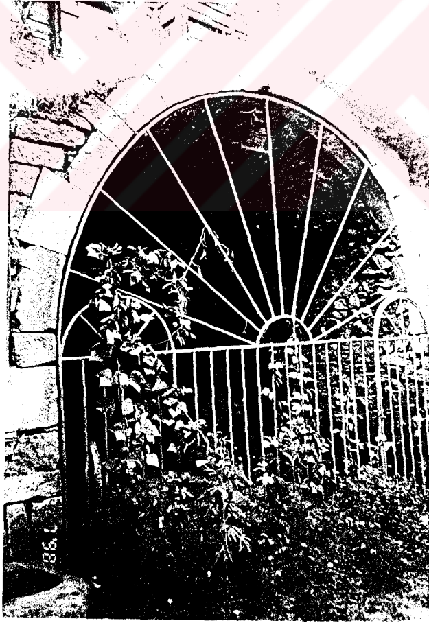
Resim 173 Hacı Çıkırık Türbesi'nin ön cephesi
