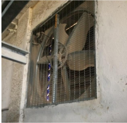
Şekil 3.3. Kümes içi negatif basınç etkili fan
