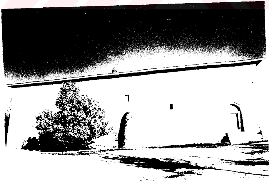
Resim 18. Hatun, İlk Camii genel görünüşü
