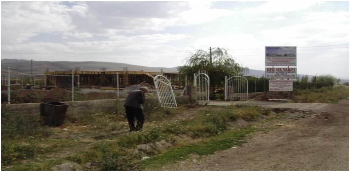
Fotoğraf 10. Alvarlı Efe Hazretleri Külliyesi inşaatı
