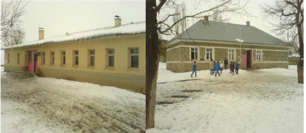
Fotoğraf 12 . Alvar İlköğretim Okulu ana bina ve ek bina
