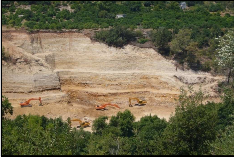
Fotoğraf 13. Sahada yapımına başlanan hidroelektrik santrallerinin inşa alanından bir görünüm.
