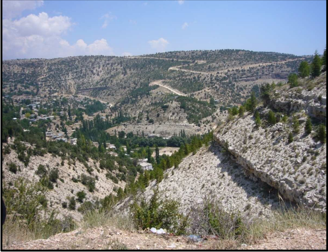
Fotoğraf 2. İnceleme alanının kuzeyinde yer alan dağlık sahadan bir görünüm.
