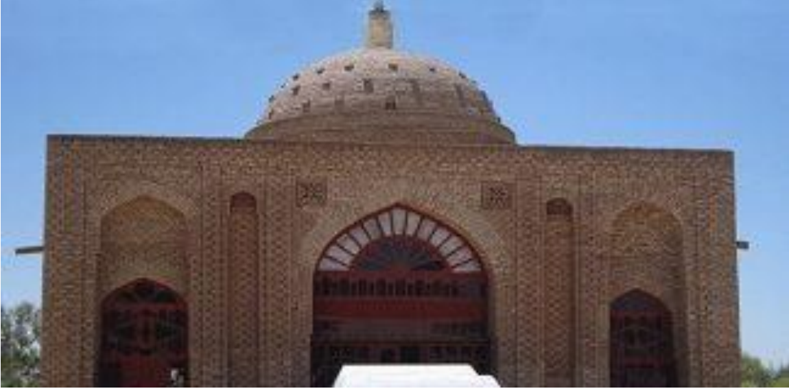
Resim-66.Talhatan Baba Camii Cephesinde Sivri Kemer yanlarındaki Rozetler 199
