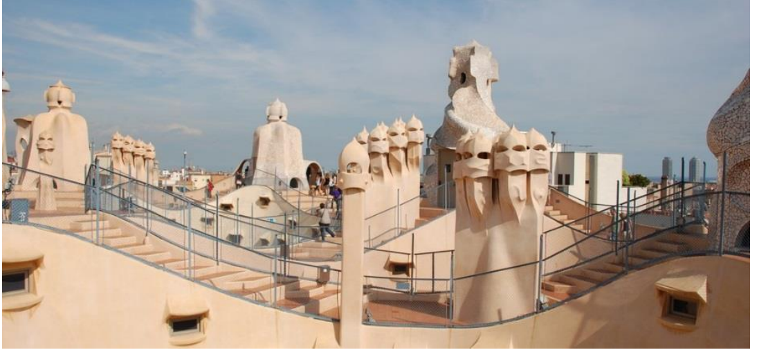
Görüntü 63. “Casa Mila” Apartmanı Çatısı.
