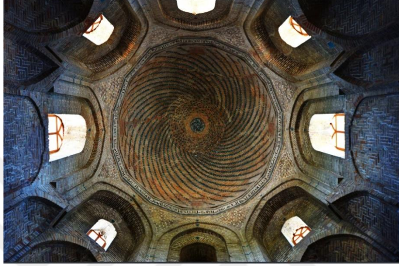
Resim 2.27. Ulu Camii kubbesindeki çarkıfelek motifi/Malatya.
