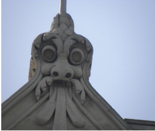
Katalog 4.16. İsa Bey Hacinski'nin Binası, Cepheden Ayrıntı
