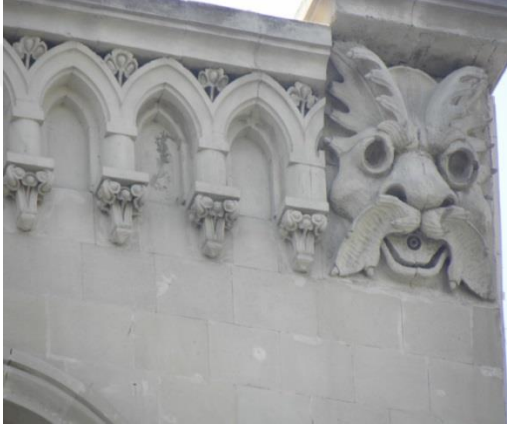
Katalog 4.17. İsa Bey Hacinski'nin Binası, Cepheden Ayrıntı
