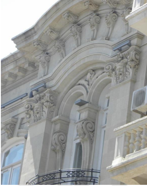
Katalog 4.29. Fransız Elçiliği Binası, Cepheden Ayrıntı
