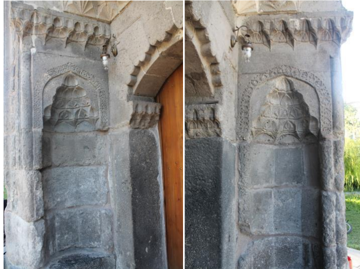
Foto. 110-111. Kayseri Kölük (Gülük) Camii Kuzeydoğu Köşe Taçkapısı Mihrabiye Nişler (M. Arslan'dan)
