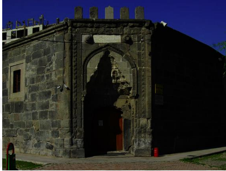
Foto. 109. Kayseri Kölük (Gülük) Camii Kuzeydoğu Köşe Taçkapısı
