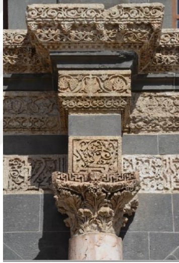
Foto. 27. Diyarbakır/ Ulu Camii Avlu Batı Revak Ayrıntısı
