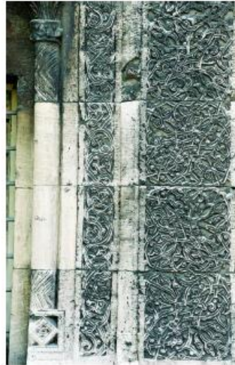
Foto. 541. Sivas / Buruciye Medresesi Yan Cephe Pencere Etrafındaki Bordürler
