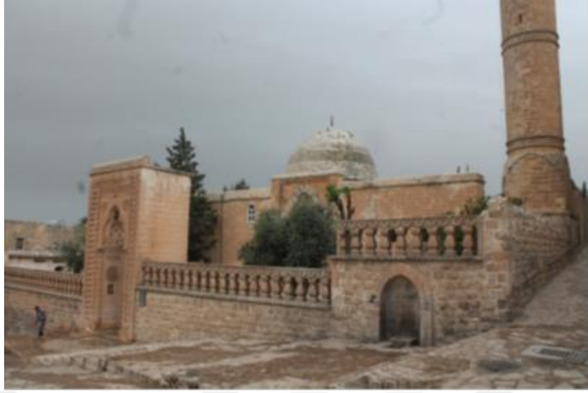
Foto. 155. Mardin Abdullâtif (Lâtifiye) Camii Avlu Doğu Cephesi (A.Saylan'dan)
