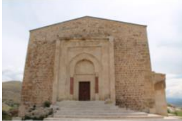
Foto. 209. Sivas Divriği İ Kale (Şahinşah) Camii Kuzey Cephesi Genel Görünüm (Nusret Algan, Anadolu Seluklu Dönemi Mimarisi Taş üzey Süslemelerinin İncelenmesi ve Seramik Yorumları , Dokuz Eylül Üniversitesi Güzel Sanatlar Enstitüsü Seramik Anasanat Dalı Sanatta Yeterlilik Tezi, İzmir,2008)
