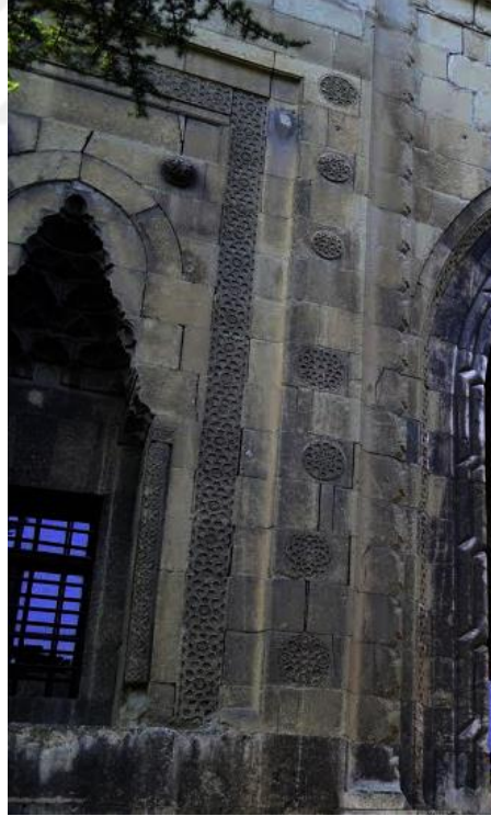
Foto. 14. Amasya Gökmedrese Camii Cephe Duvarındaki Bezemeler
