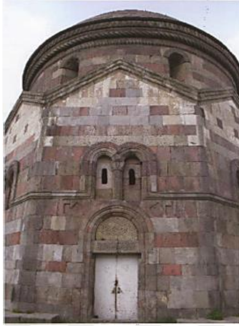
Foto 420. Emir Saltuk Kumbeti Genel Görünüm
