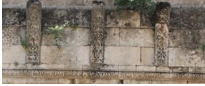
Foto. 41. Diyarbakır Silvan Ulu Camii Kuzeybatı Cephesindeki Kemer Konsolları (A.Saylan'dan)
