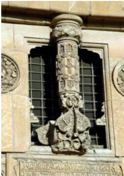
Foto. 246. Sivas Divriği/ Şifahane Taçkapıdaki Pencere ( http://gezgindergi.com/divrigi-ulu-camii-ve-darussifasi , E.T.27.03.2018)
