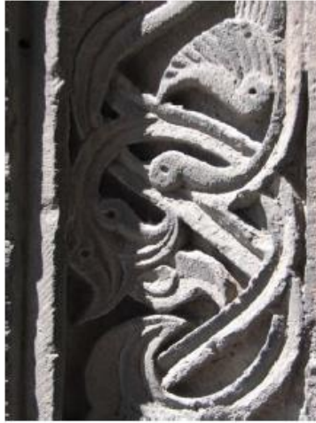
Foto. 530. Taçkapı, Kayseri Sahibiye Medresesi, Ayrıntı
