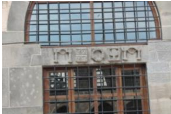
Foto. 31. Diyarbakır Ulu Camii Kuzey Cephesinde Devşirme Malzeme
