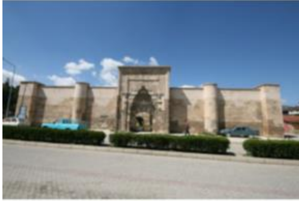
Foto. 257. Afyonkarahisar Sultandağı Sahip Ata Kervansarayı Restorasyon Sonrası (M.Uysal'dan)
