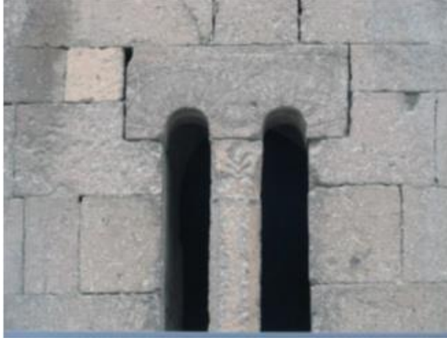
Foto 433. Anonim Kumbet II, Güneybatı Cephe Pencere (Ş.Dursun'dan)
