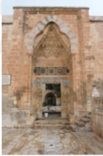
Foto. 156. Mardin Abdullâtif (Lâtifiye) Camii Avlu Taçkapısı (Doğu Cephe) (A.Saylan'dan)
