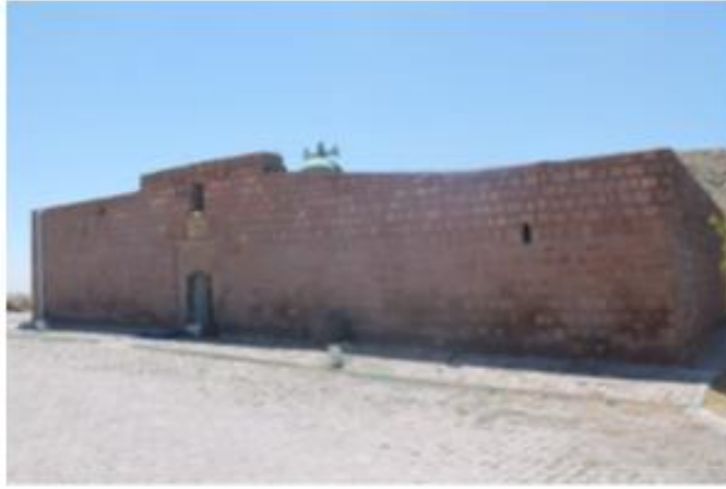
Foto. 291. Kayseri İncesu Şeyh Turhasan Zaviyesi Doğu Cephesi (M.Arslan'dan)
