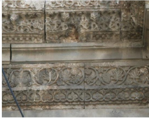
Foto. 590. Diyarbakır Ulu Camii Doğu Revak Bitkisel Bezemeleri
