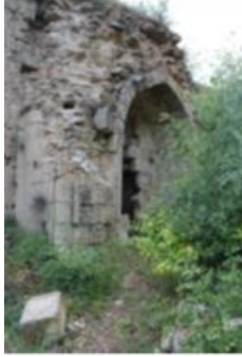
Foto. 142. Malatya Arapgir Ulu Camii Kuzey Cephe Taçkapısı (M. Arslan'dan)
