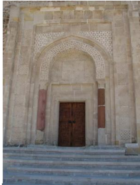
Foto. 210. Sivas Divriği İ Kale (Şahinşah) Camii Takapısı (N.Algan'dan)
