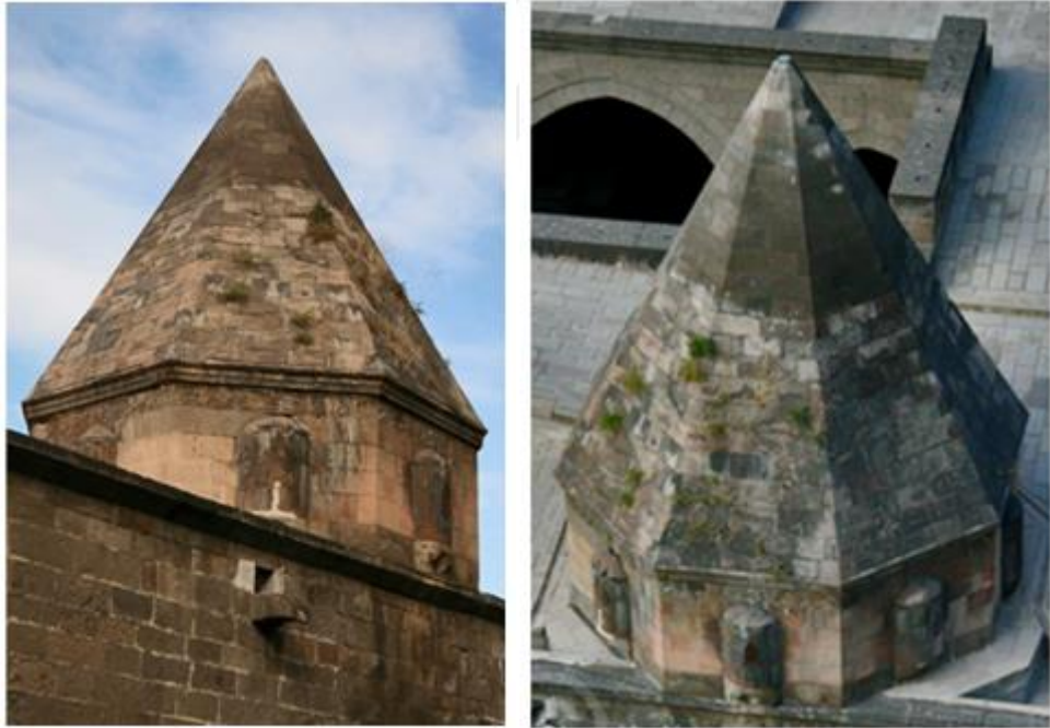
Foto 478-479. Gevher Nesibe Hatun Türbesi Yan ve Üst Görünümü ( https://www.google.com.tr/search?q=Gevher+Nesibe+Hatun+Medresesi&source=lnms&tbn=i sch&sa=X&ved=0ahUKEwjDn8mQ5MDaAhXOx6YKHffVAvUQ_AUICygC&biw=1920&bih=974#imgc=GIHOysD7GwsMuM:;E.T.17.02.2018 )
