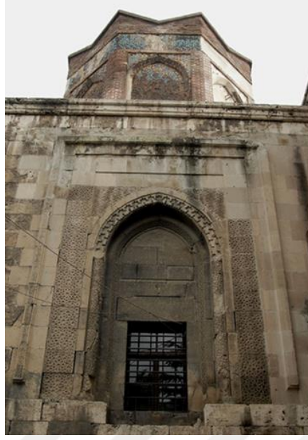
Foto 407. Amasya, Gök Medrese Camii Türbesi Taçkapısı (M. Cambaz'dan)
