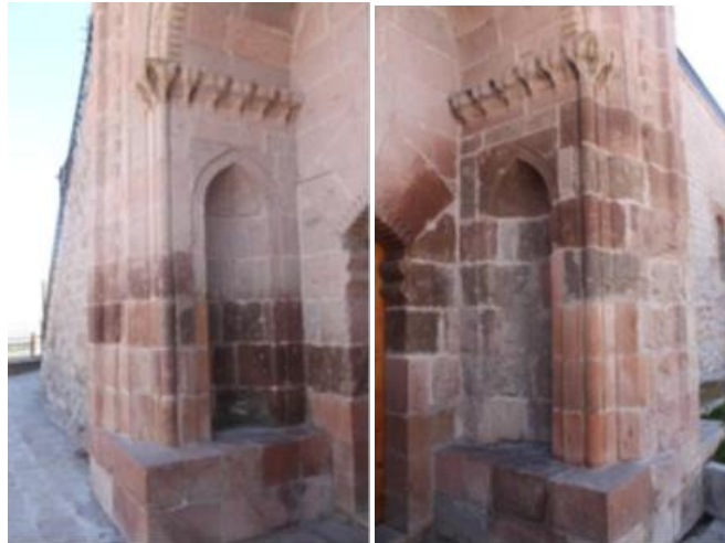
Foto. 65-66. Kayseri Develi Ulu (Sivasti Hatun) Camii Taçkapı Mihrabiye Nişleri (M.Arslan'dan)
