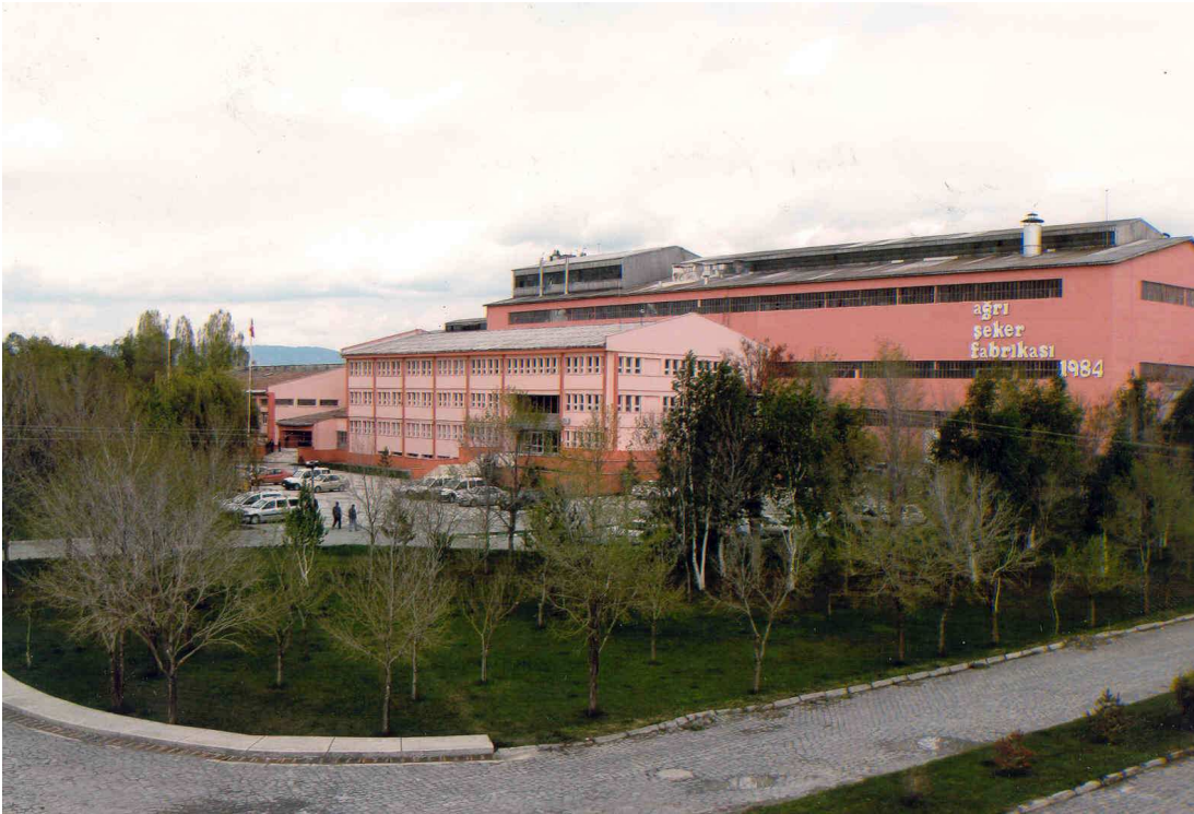
Fotoğraf:4.1. Ağrı Şeker Fabrikası ana binası.
