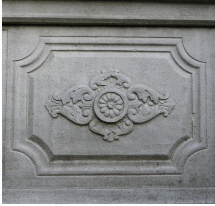
Resim 310: 89 Nolu Mezarın Bahçe Duvarından Detay
