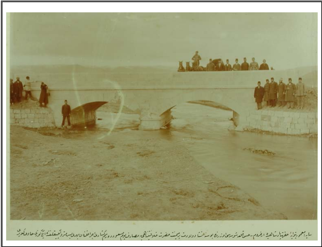
Resim-7.(a-b). Erzurum-Hasankale Yolu üzerinde 1903 yılında açılışı yapılan iki adet köprü (BOA. YEE. 414)
