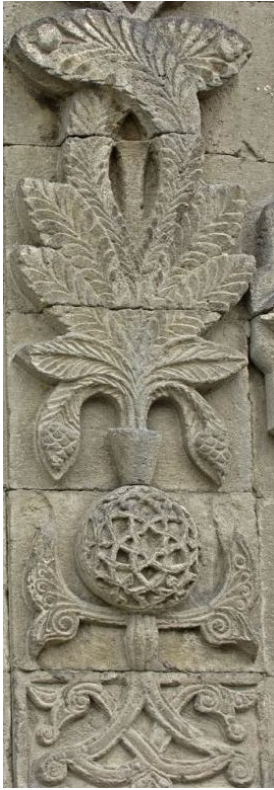
Resim: 17. Çifte Minareli Medrese Taçkapı Hayat Ağacı
