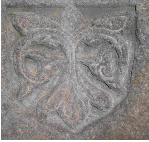
Resim: 22. Çifte Minareli Medrese Taçkapı Bordürü Altındaki Bezeme
