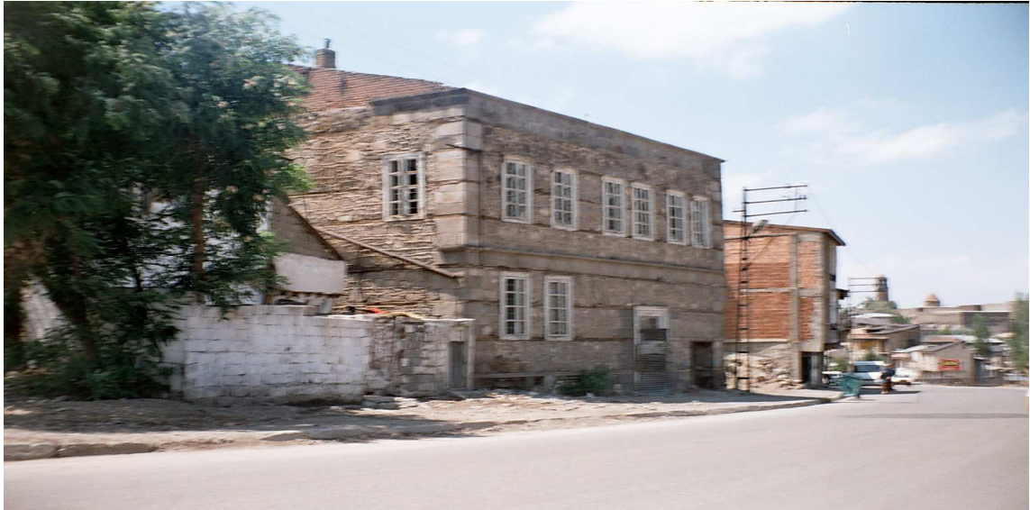
Fotoğraf 2.17. Narmanlı Mahallesindeki Yıkılan Taş Yapı
