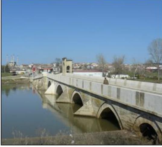
Fotoğraf 2.46. Ekmekçizade Köprüsü.
