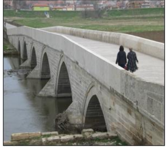
Fotoğraf 2.45. II. Bayezit Köprüsü.
