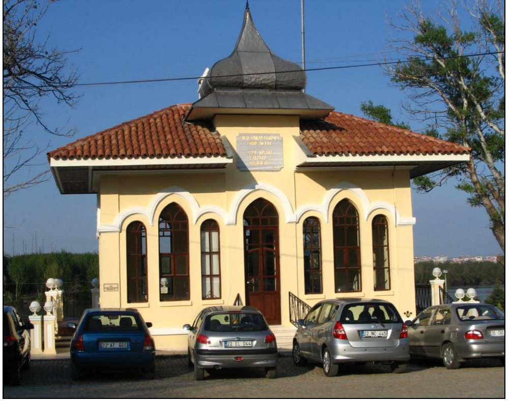
Fotoğraf 2.63. Karaağaç Gümrük Karakol Binası.
