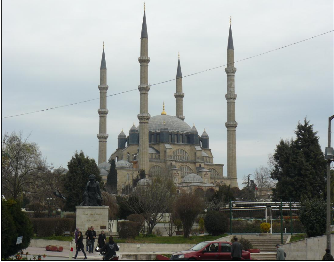
Fotoğraf 2.69. Selimiye Camii Dışarıdan Bir Görünüm.
