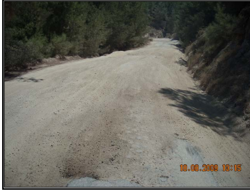
Fotoğraf 4.32. Labranda Antik Kenti ile Geyik Baraj Gölü Arasındaki Yol, Ağır Tonajlı Taşıtlardan Dolayı Bozulmaktadır.
