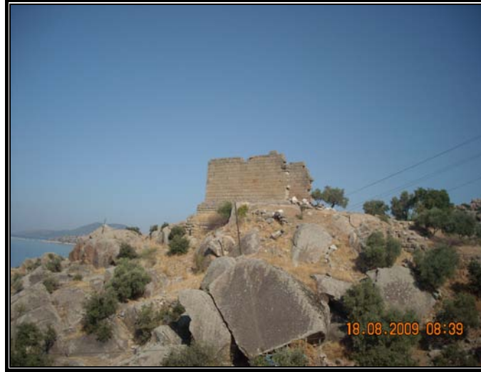
Fotoğraf 2.81. Herakleia Antik Kenti'ndeki En Önemli Yapılardan Athena Tapınağı'nın Kalıntılarından Bir Kısmı Günümüzde Hala Ayaktadır.
