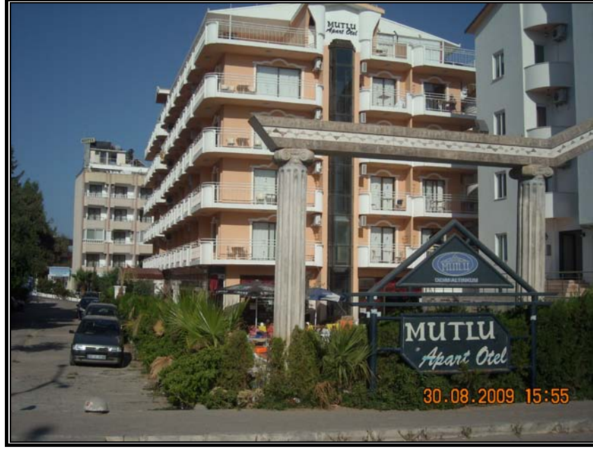
Fotoğraf 3.14. Mutlu Apart Otel'den Bir Görünüm (Didim).
