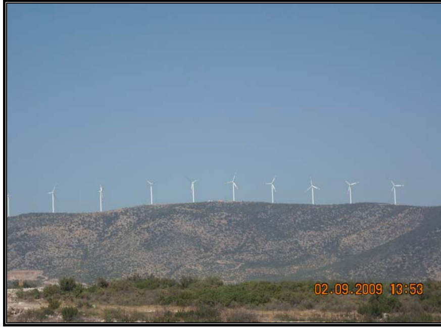
Fotoğraf 1.82. Didim'deki Akbük Rüzgâr Enerji Santrali'ne Ait Rüzgâr Panellerinden Bir Görünüm.
