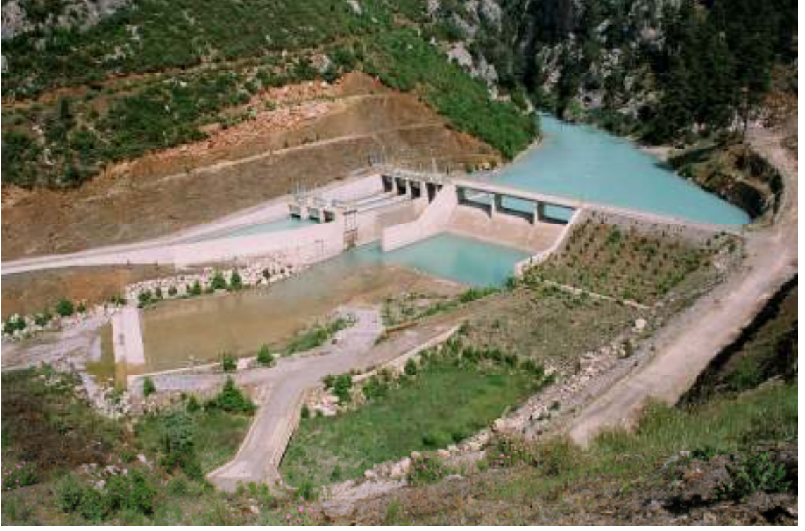
Fotoğraf 11: Pamuk HES Baraj Görünümü
