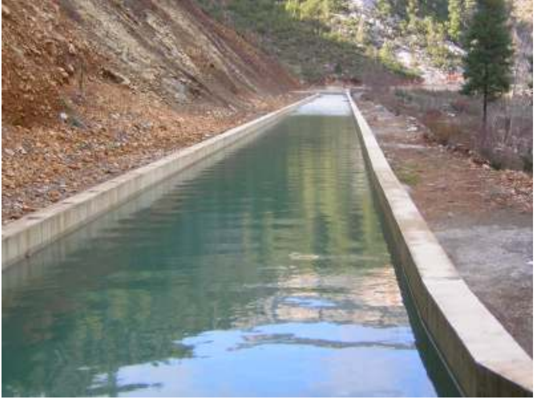
Fotoğraf 8: HES Barajına Ait Sulama Kanalı
