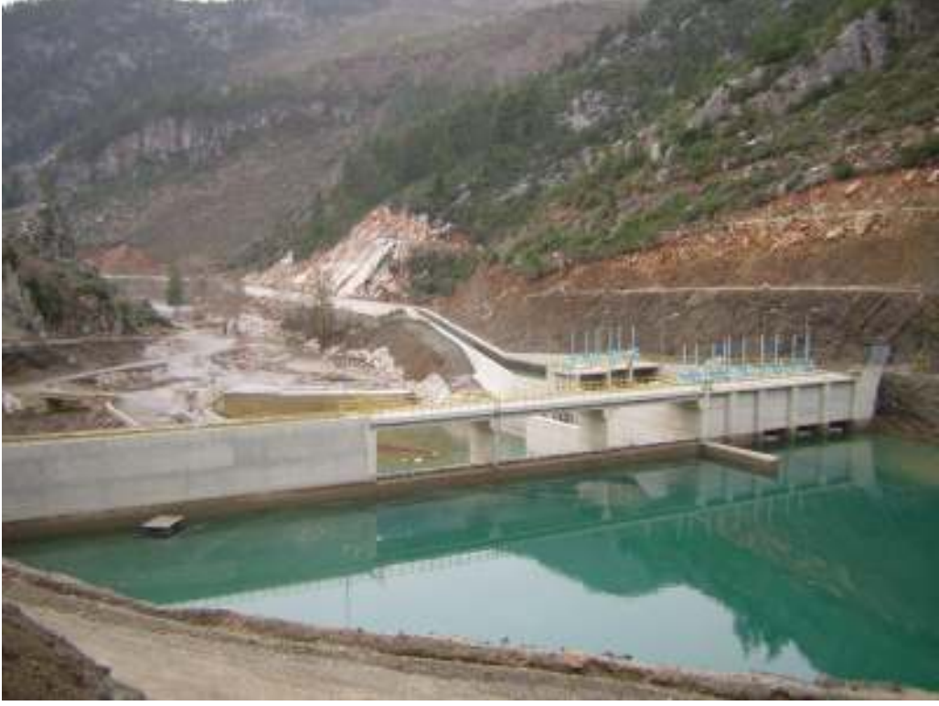
Fotoğraf 9: Pamuk HES Baraj Görünümü
