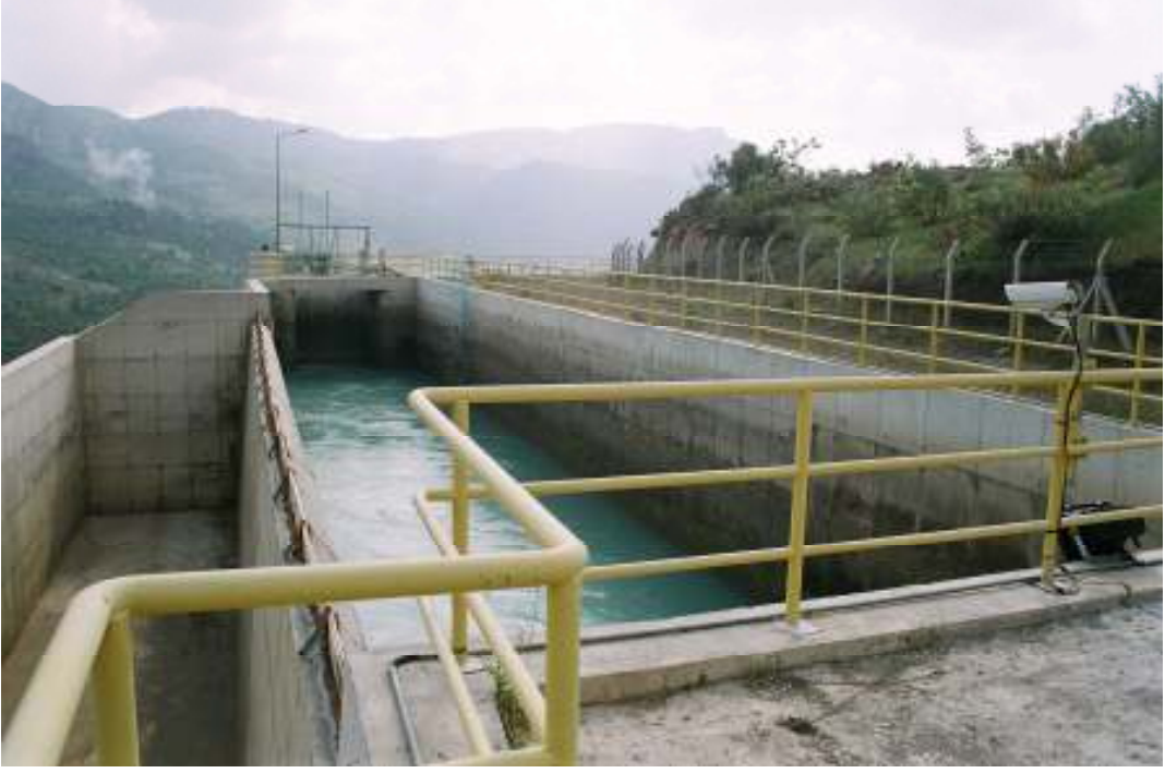
Fotoğraf 7: Hidroelektrik Santralinden Görünüş
