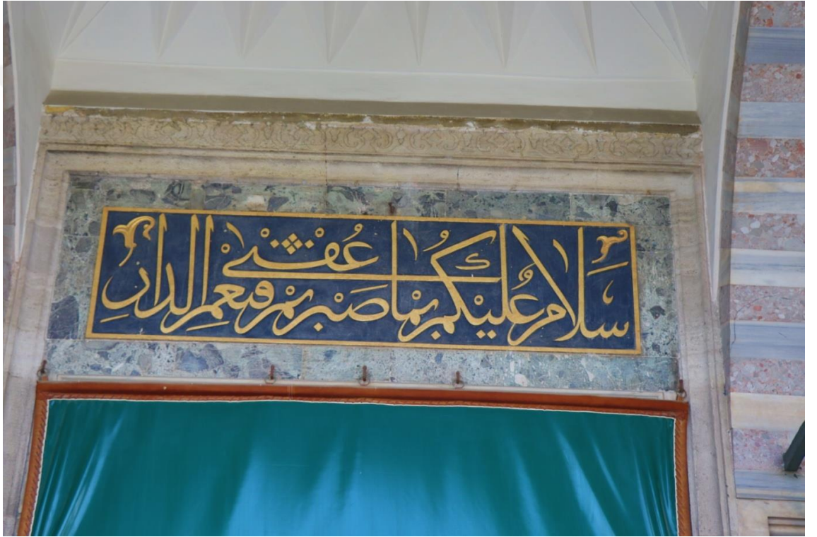
Resim 4.303. Cami Sol Giriş Kapısı Üst Alınlık
