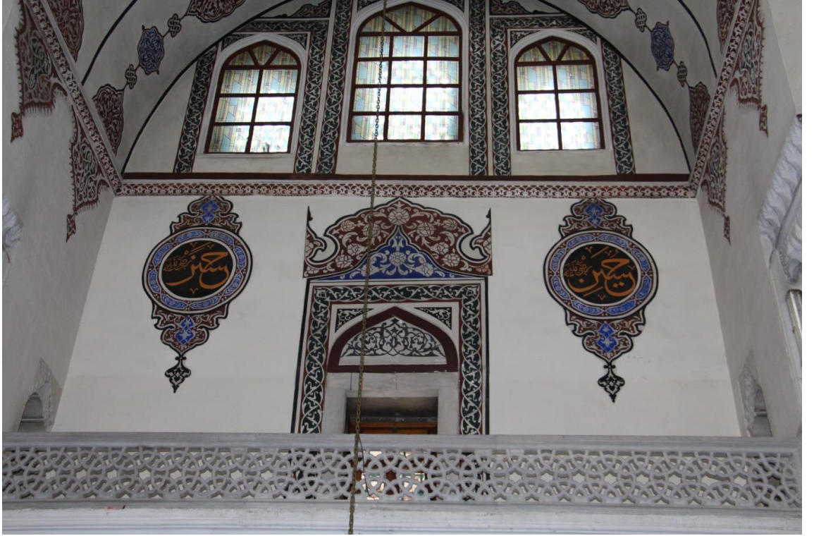
Resim 4.111. Cümle Kapısı Üstündeki Mahfil Duvar Üstü
