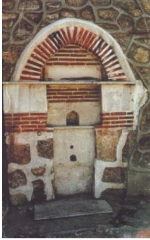
Resim 124. Üftade Camii Çeşmesi Genel Görünümü
