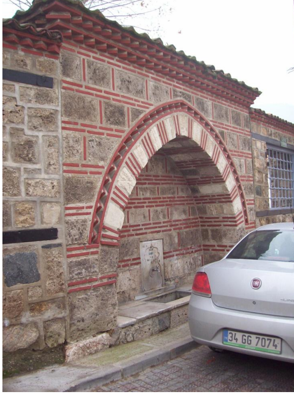
Resim 5. Alaaddin Camii Çeşme Cephesi
