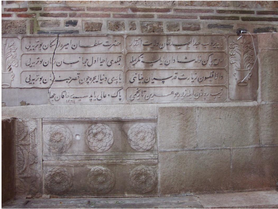
Resim 64. Darüssaade Ağası Çeşmesi Arka Cephedeki Süslemeler
