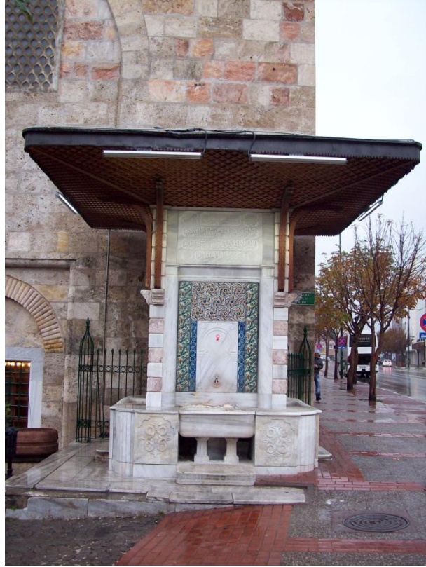
Resim 115. Çinili (Münir Paşa) Çeşme Batı Cephesi
