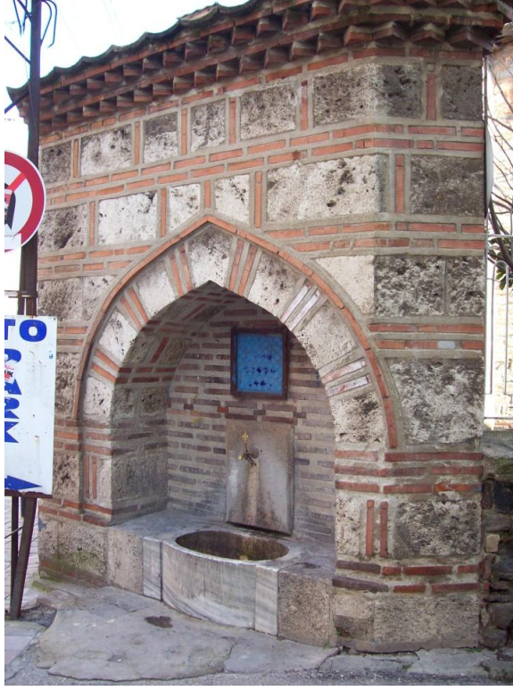
Resim 13. Selçuk Hatun Camii Çeşmesi Güney Cephesi
