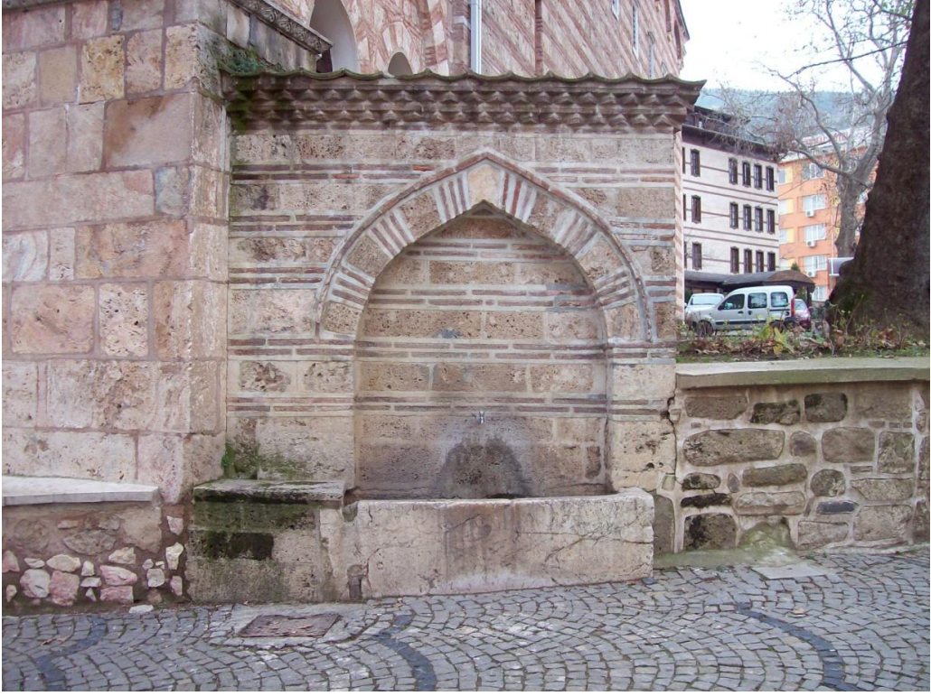
Resim 7. Hüdavendigâr Camii Çeşmesi Cephesi
