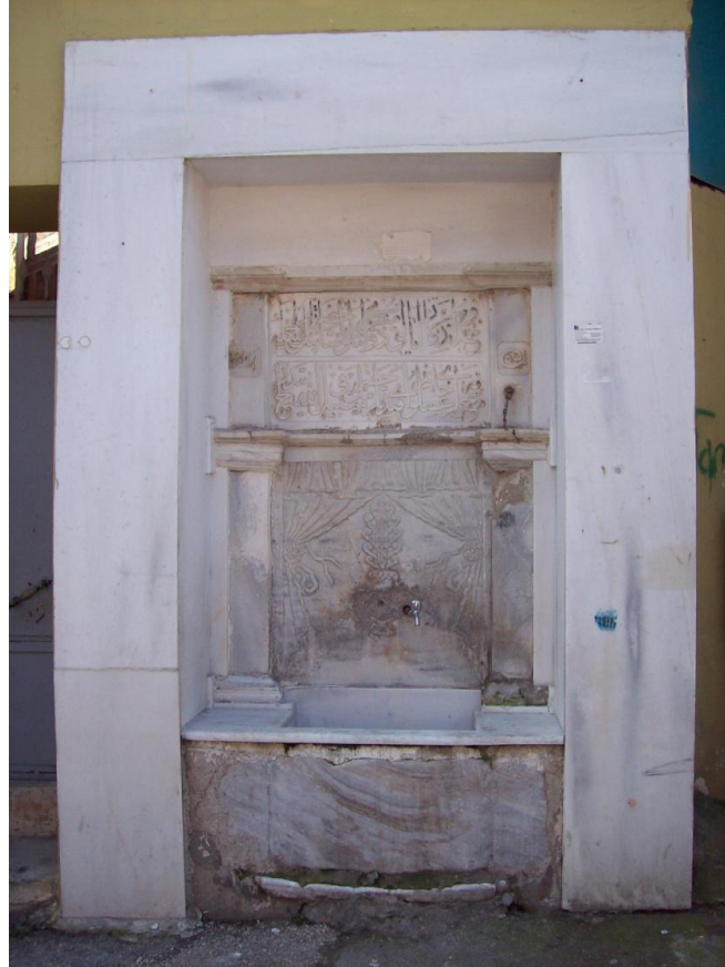
Resim 88. Hocaalizade Çeşmesi Cephesi
