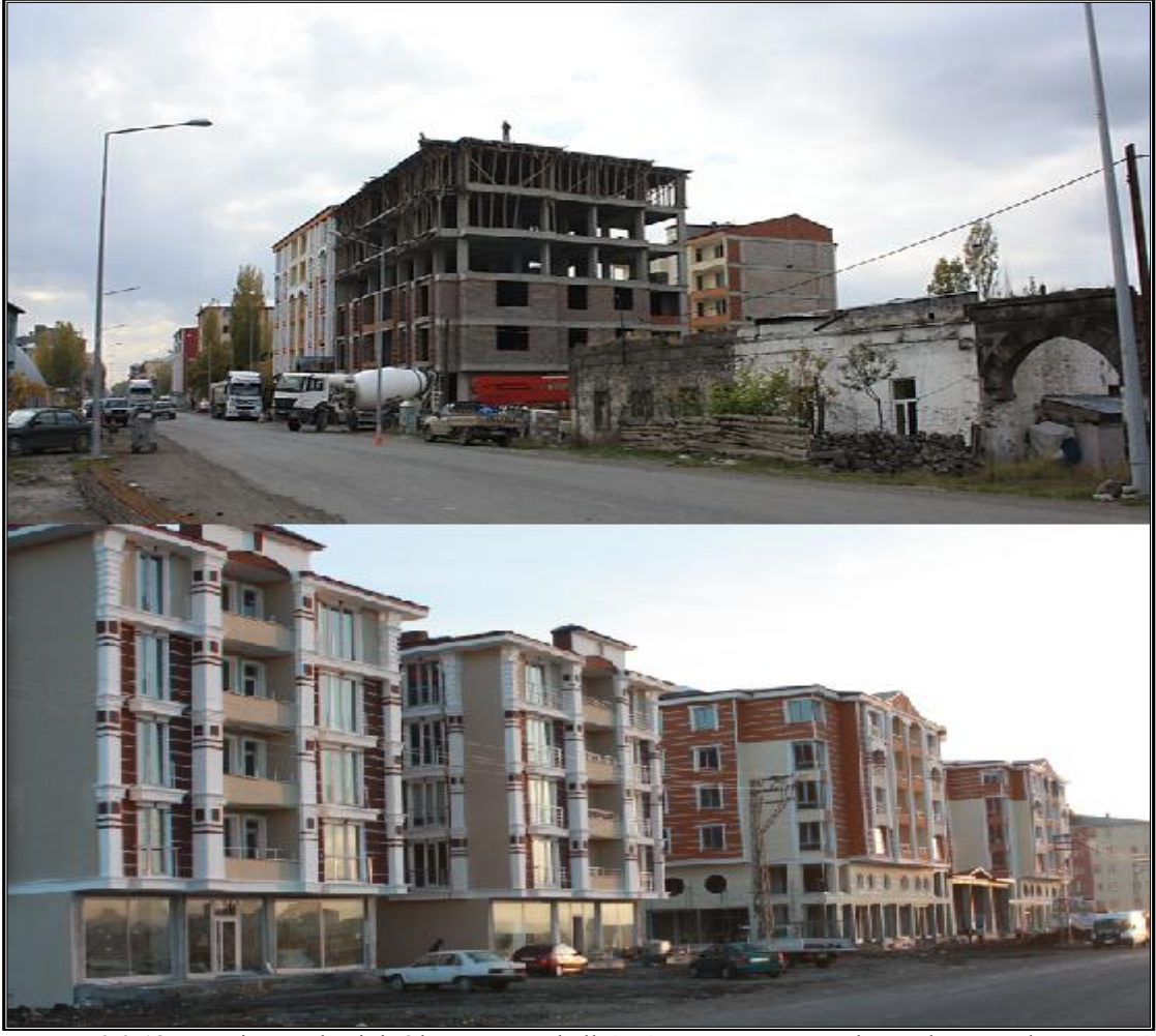
Fotoğraf 2.18. Kentin Merkezini Oluşturan Mahallelerde, Betonarme Malzemedan Yapılan Konutlar, Yoğunluk Göstermektedir.
