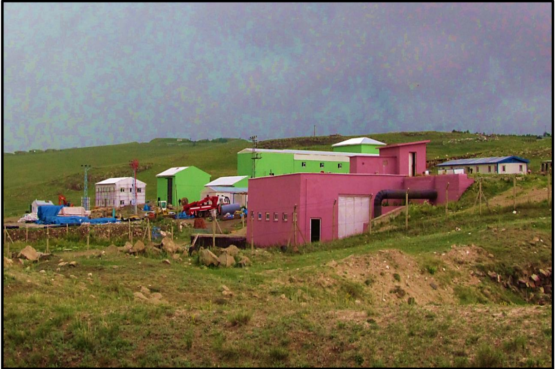
Fotoğraf 4.6. Kentin Kuzeyinde Yamaçlar Üzerinde Bulunan, Su Arıtma Tesisleri.
