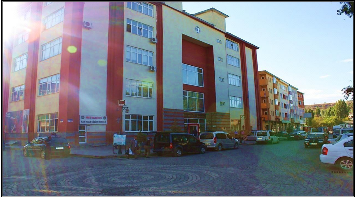
Fotoğraf 2.28. Gölyeri Mevkiinde Bulunan Belediye Binası.
