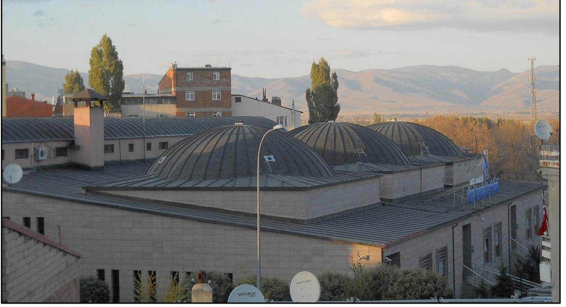
Fotoğraf 2.3. Aziziye (Ilıca) Termal Tesisleri. Modern Üçlü Kubbesi Özel, Erkekler ve Bayanlar Kabinlerinin Tavan Kısımlarını Oluşturmaktadır.
