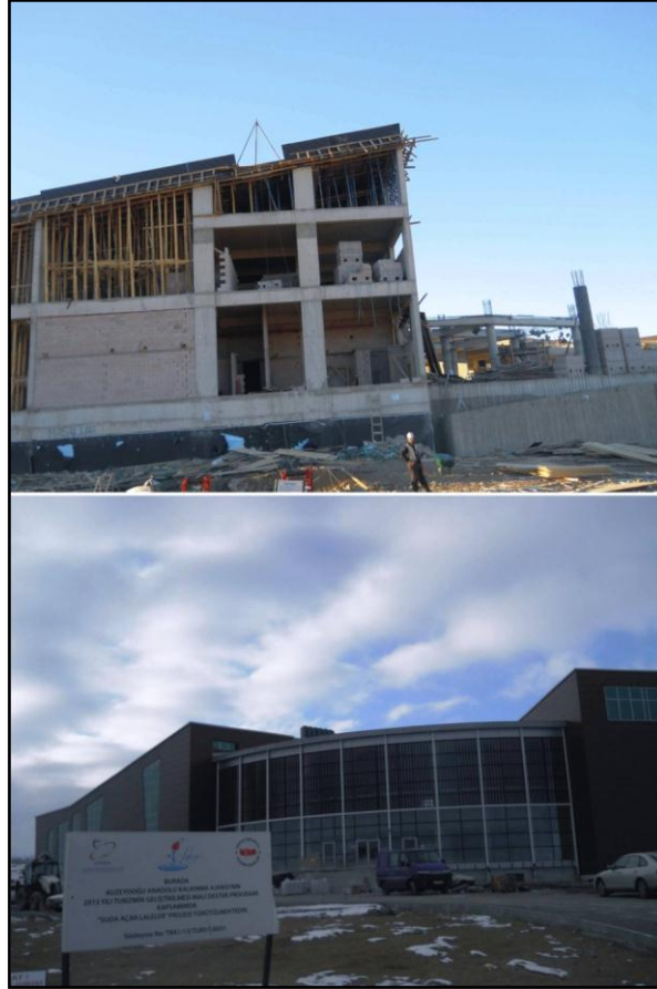
Fotoğraf 2.13. Hamamderesi-Küçüktüy Kaplıca Tesisleri İnşaatından Görünümler. Üstte, Tesislerin 2013 Yılı'nın Ekim Ayına Ait Olan Betonarme Karkas Hali, Altta ise 2014 Yılı'nın Aralık Ayında Çekilmiş Hali Görülmektedir.
