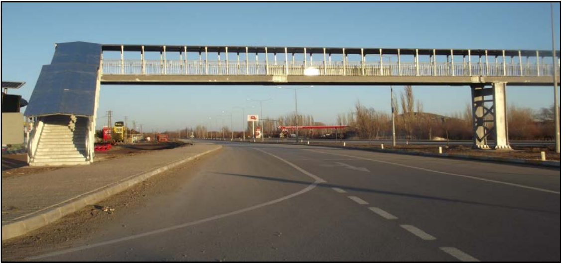
Fotoğraf 3.3 E-88 Karayolunun Hafik İlçe Merkezi Bölümünden Görünüm
