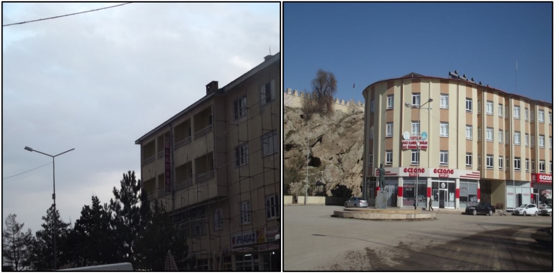
Fotoğraf 2.4 Hafik Belediyesi Eski (Solda) ve Yeni (Sağda) Hizmet Binaları
