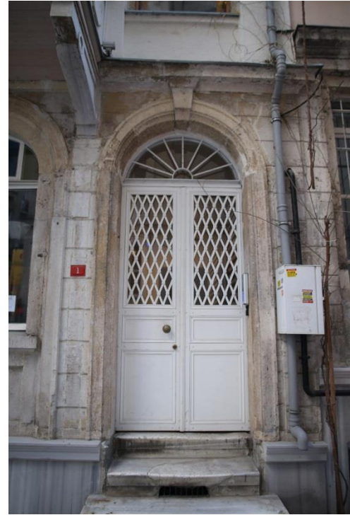
Karş. Foto. 4.4. İstanbul/Beyoğlu Kapı Örneği
