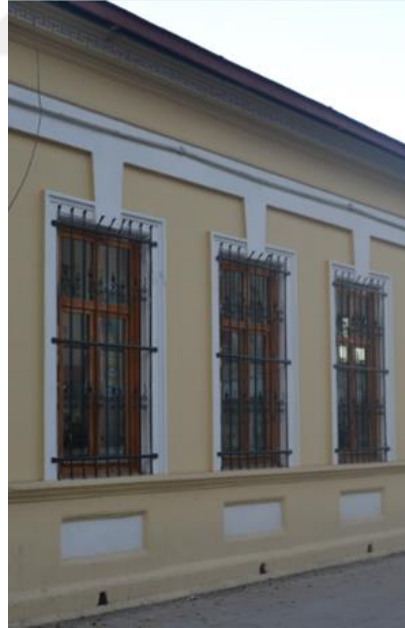
Fotoğraf 3.19. Batı Cephe Pencereleri
