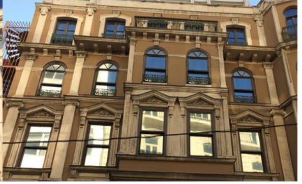
Karş. Foto. 4.35. İstanbul/Pera Plaster Örneği
