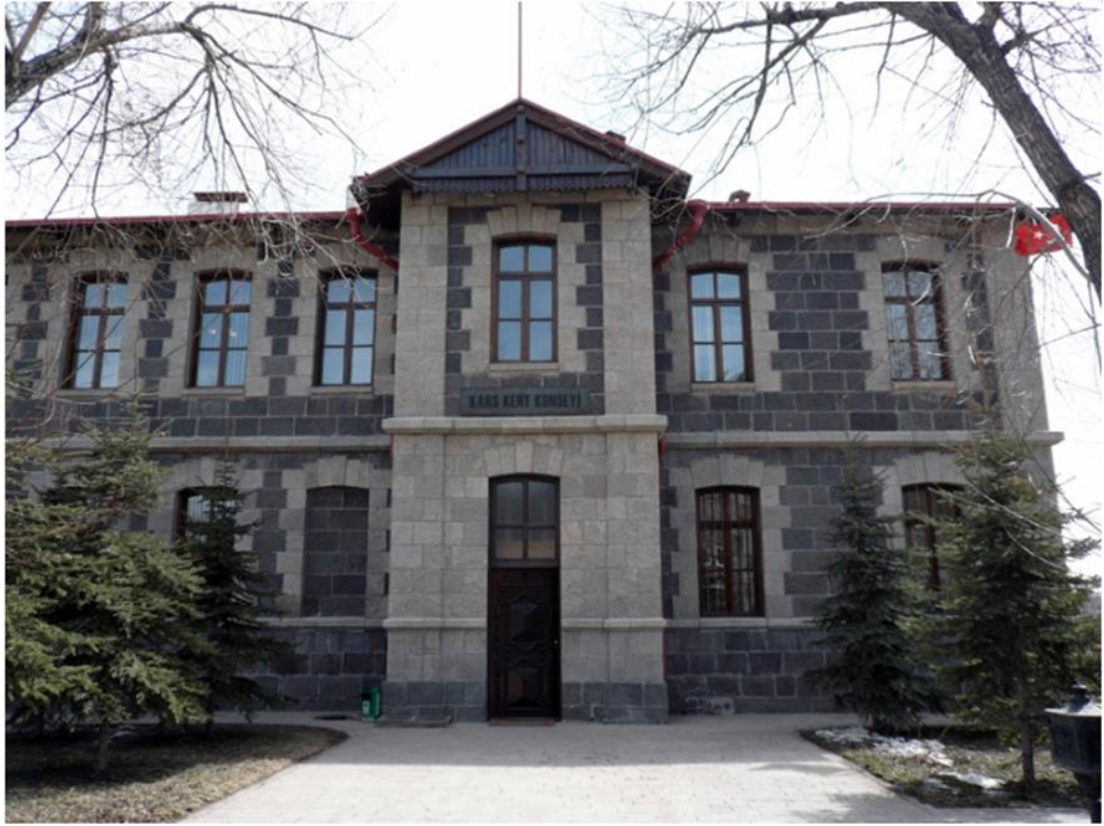
Fotoğraf 3.129. Kars Eski Rus Gümrük Binası ( İl Özel İdare Arşivi)
