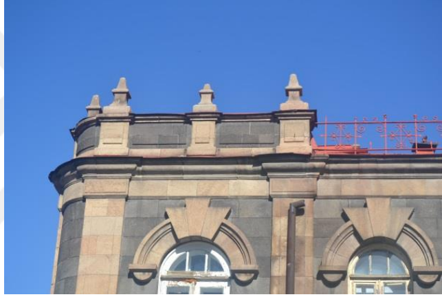
Fotoğraf 3.43. Çatı Kuleleri
