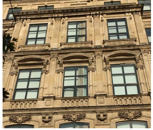
Karş. Foto. 4.33. İstanbul/Pera Plaster Örneği
