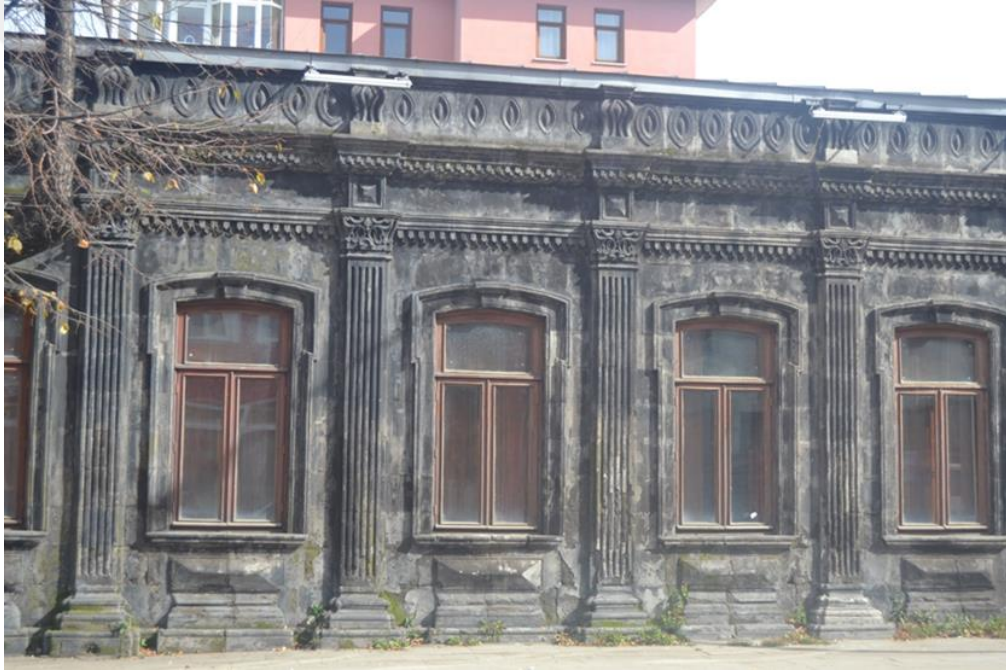
Fotoğraf 3.71. Batı Cephe Pencereleri
