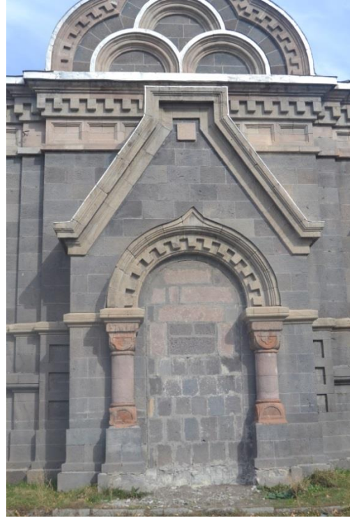
Fotoğraf 3.152. Güney Cephe Kapatılan Giriş
