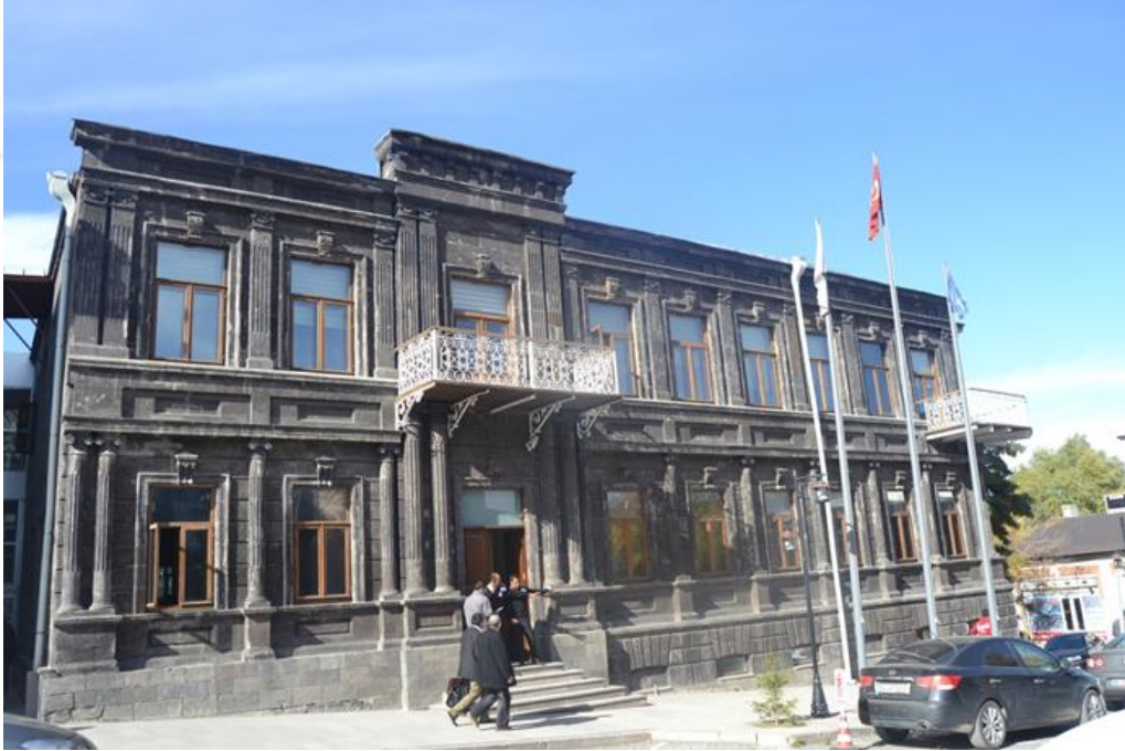
Fotoğraf 3.118. Kars Eski Belediye Binası
