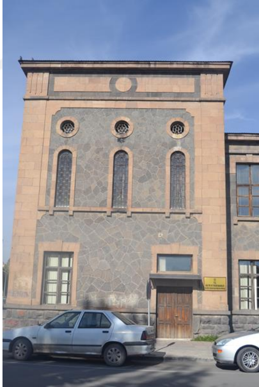
Fotoğraf 3.139. Güney Cephe Sol Bölüm
