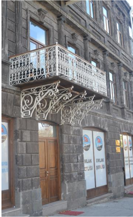
Fotograf 3.121. Doğu Cephe Balkon
