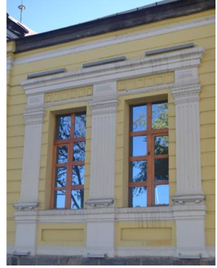
Fotoğraf 3.59. Doğu Cephe Pencereleer
