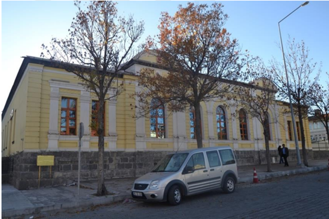
Fotoğraf 3.57. Kars Eski Vali Konağı Doğu Cephe
