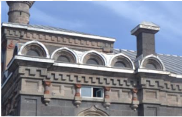
Fotoğraf 3.158. Güney Cephe Aydınlık Pencereleri
