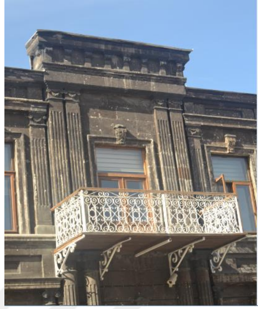
Fotograf 3.120. Güney Cephe Balkon
