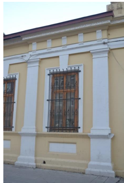
Fotoğraf 3.17. Batı Cephe Pencere
