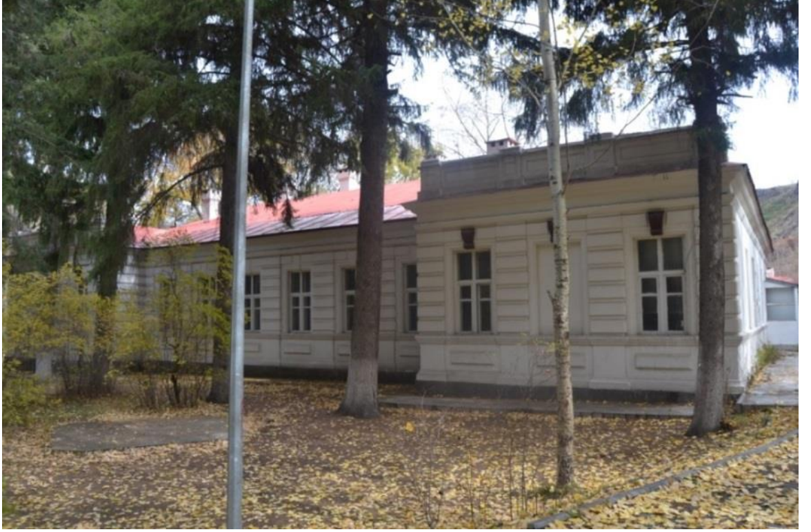
Fotoğraf 3.68. Batı Cephe Pencereler
