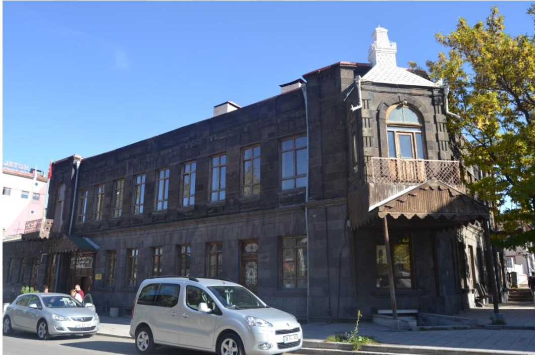
Fotoğraf 3.103. Kars Konservatuvar Binası
