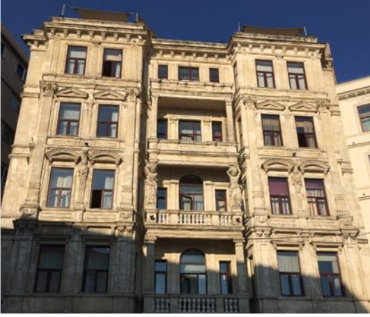
Karş. Foto. 4.34. İstanbul/Pera Plaster Örneği
