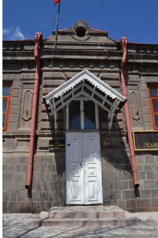
Fotoğraf 3.144. Güney Cephe Giriş Kapısı
