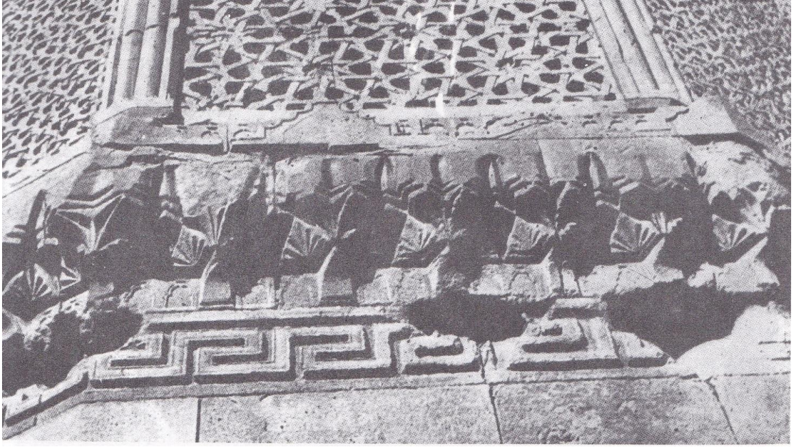
Resim: 29-Türbenin kaidesinden ana gövdeye geçişteki, mukarnasın görünümü. (O. Aslanapa)
