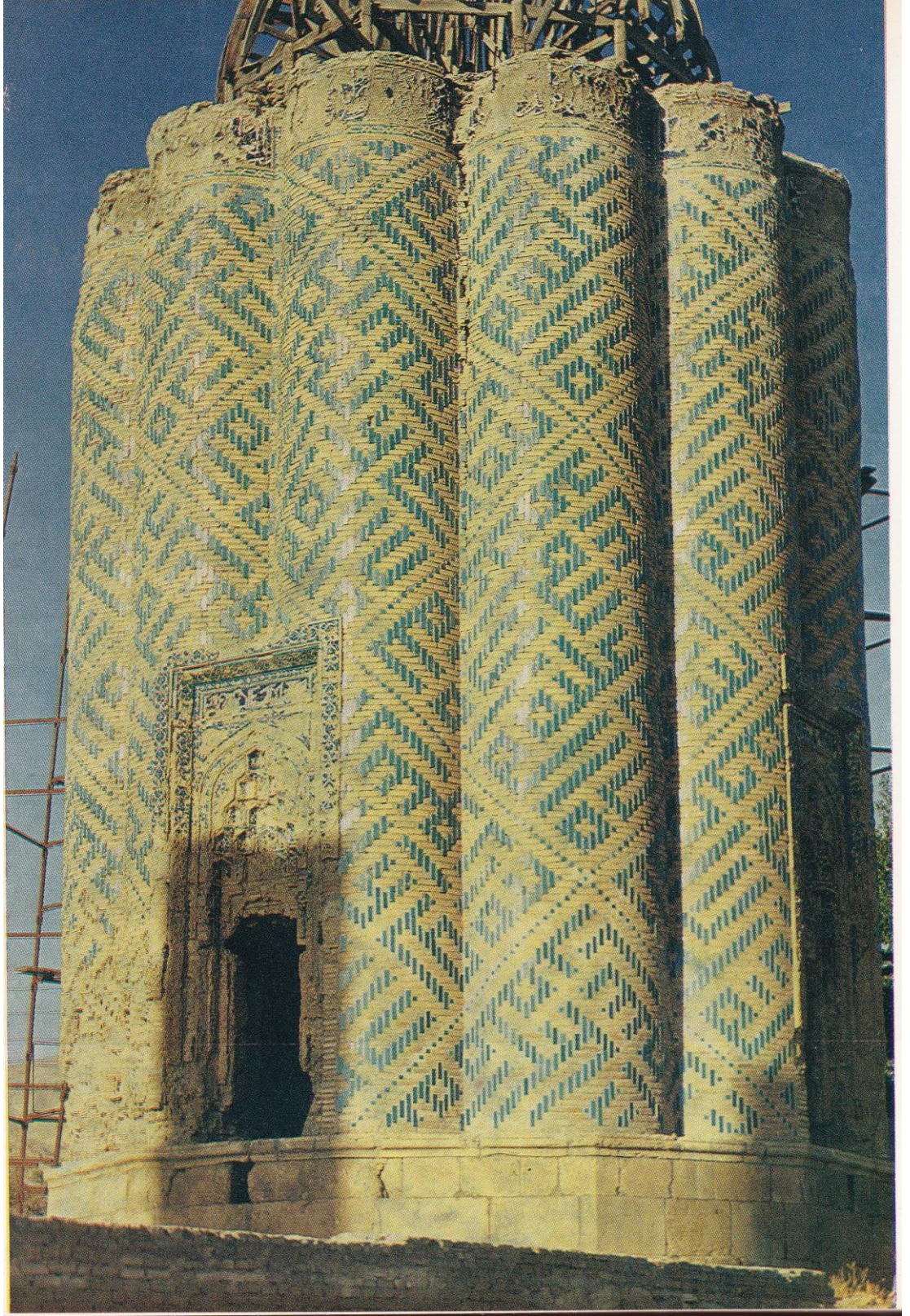
Resim: 46-Karabağlar Türbesi restore edilirken çekilmiş resmi. (A.V. Salamzade)
