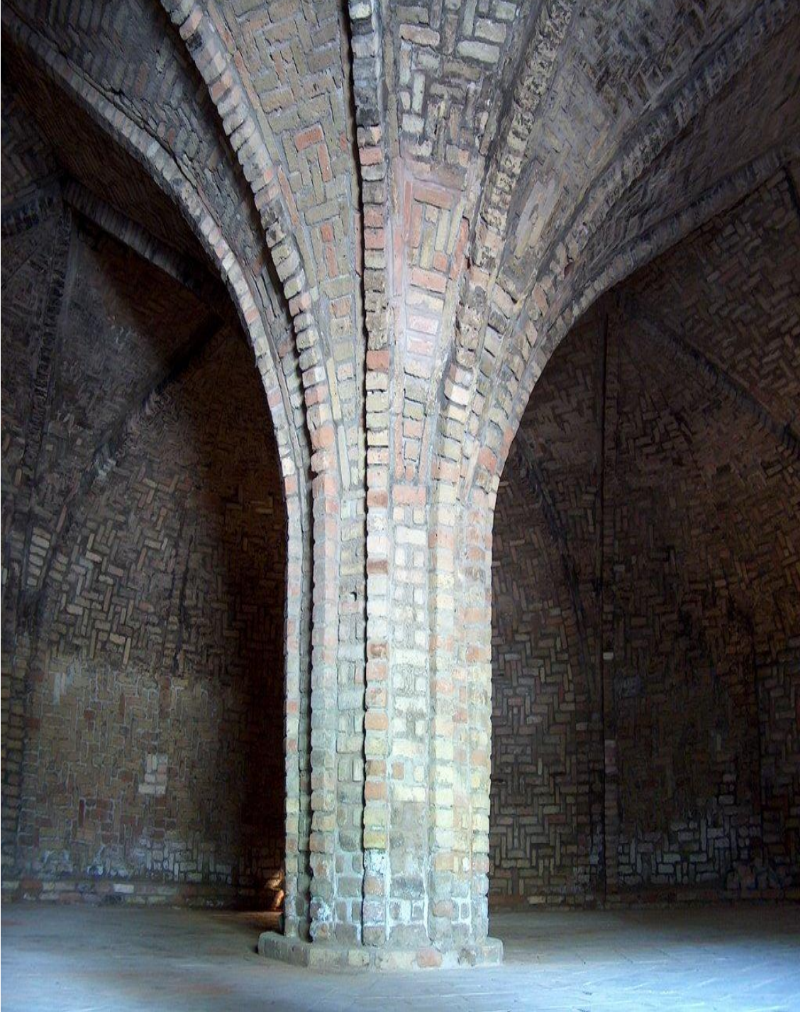
Resim: 17-Hazire kısmında taşıyıcılık rolü üstlenmiş olan sütun. (O. Aslanapa)
