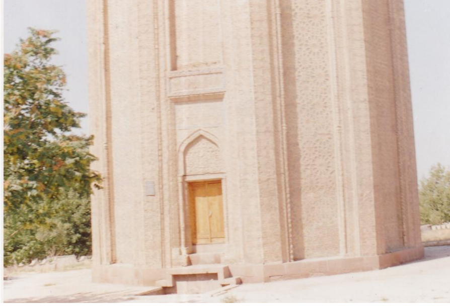
Resim: 10-Mümüne Hatun Kumbetin giriş cephesinden bir görünüm. (Y.B. Yılmaz Arşivi)
