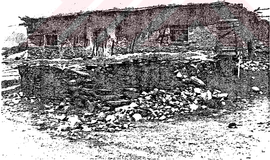
Resim No:22, Saraç köyünde taş temel üzerine kerpiçten inşa edilmiş, düz toprak damlı, bugün kullanılmayan bir mesken. Alt katın ahır olarak kullanıldığı evin merdivenleri taştan yapılmıştır.
