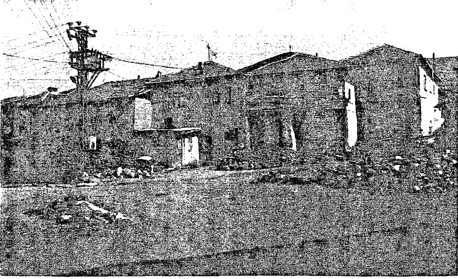
Resim No:21, Uçarı köyünde, kerpiçten, kiremit çatılı meskenler ve ailenin kalabalıklaşması ile yapılan eklentiler.
