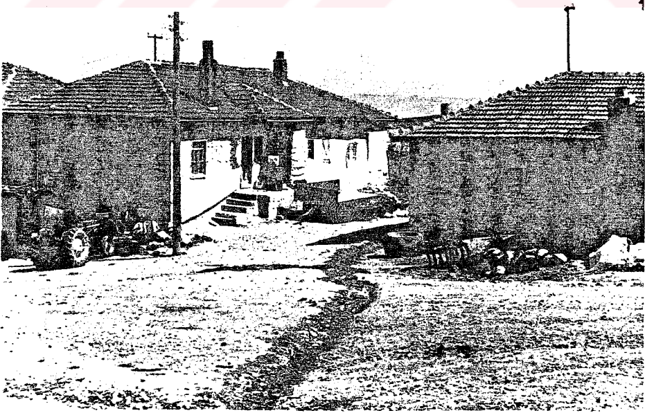
Resim No:28, Kılıçlar köyünde eski ve yeni iki konut. Eski konutta temel belli bir yüksekliğe kadar taş, üzeri kerpiçle inşa edilmiş ama yeni bina tümüyle tuğla ile yapılmıştır.
