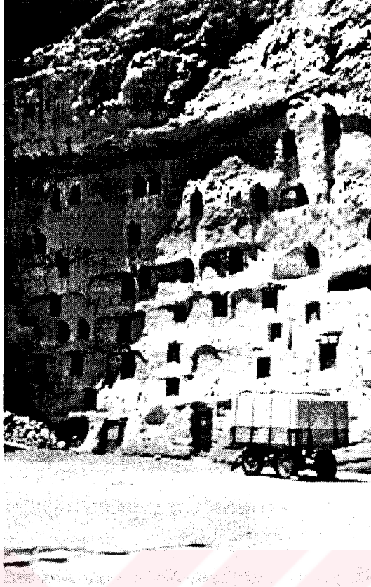
Foto 6 : Manazan mağaraları ile aynı yapıdaki arazide bulunan Taşkale, kalker bir yamaca insanlar tarafından kazılmış ve tarım ürünlerinin depolandığı odaları ile ilginç bir görüntü oluşturmaktadır. Yamacın alt seviyesinde bir camininde bulunduğu odalara, ürünler makaralar ile çıkarılmaktadır.
