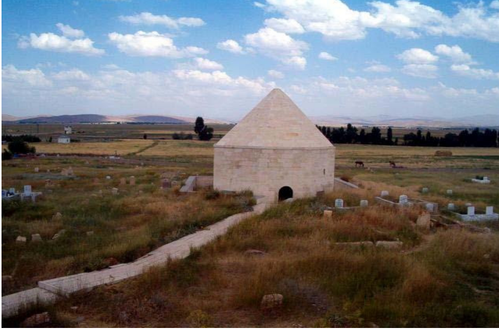
Resim 11: Sinür Köyü Kutlu Bey Türbesi (Akkoyunlular Dönemi)
