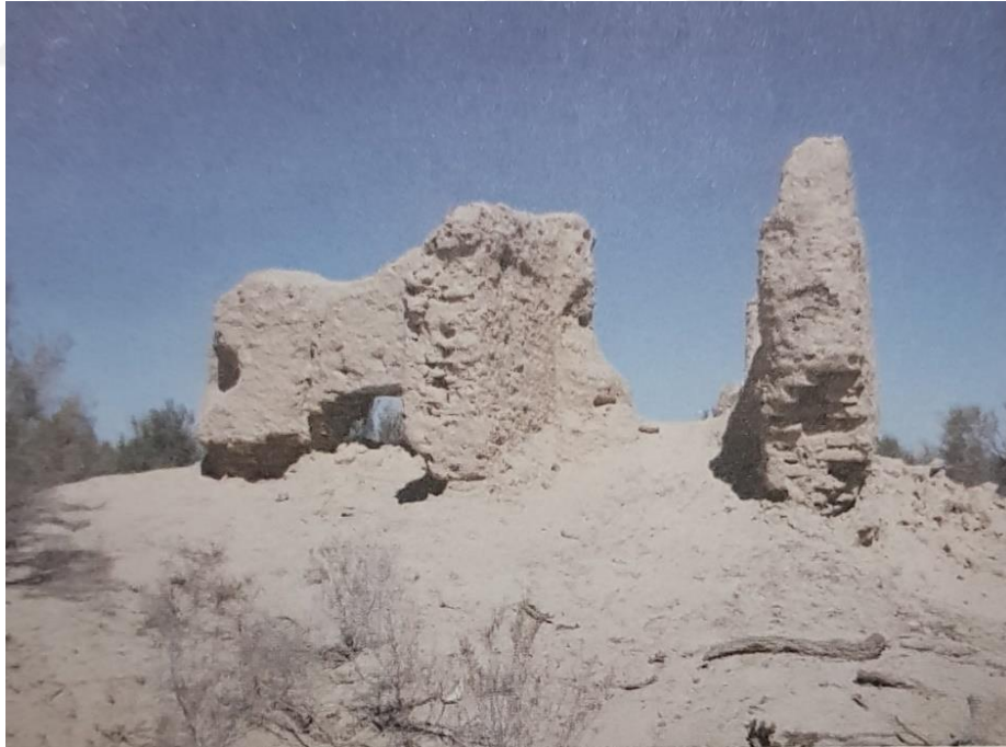
Foto. 15. Cend, dış kalede bulunan, Türbe olarak adlandırılan 2. yapının görünümü, (B. Deniz, 2004)
