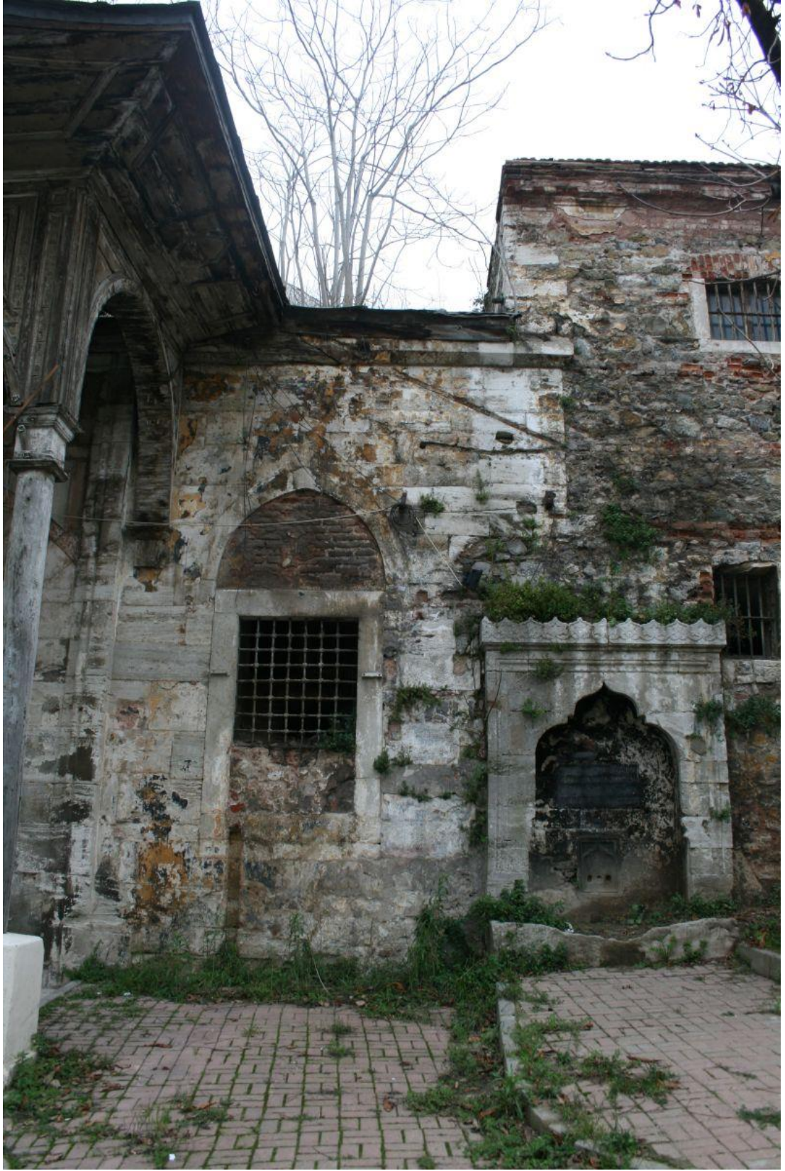
Resim 2: Vâlîde-i Atîk İmareti Kapısının Sağında Yer Alan Hasan Çavuş Çeşmesi.
