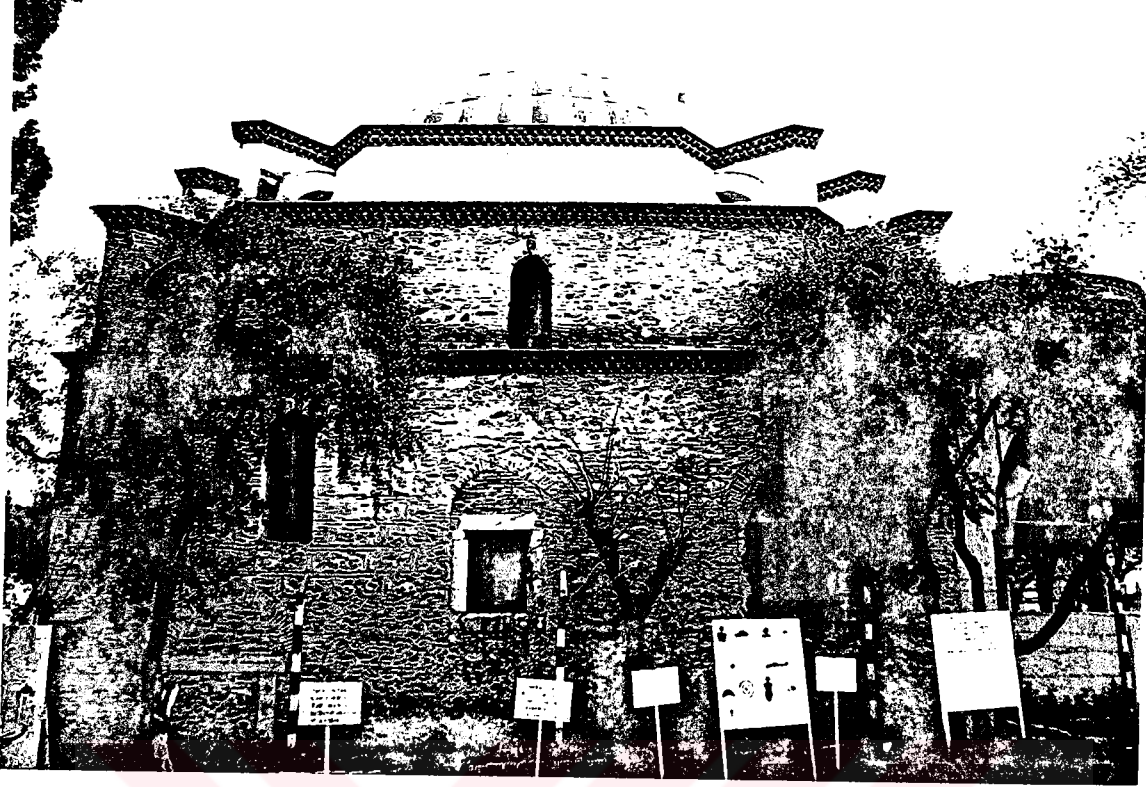
Resim 9. Derviş Ağa Camii, doğu cephe.
