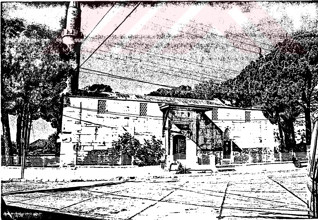
Resim 4. Ulu Cami, doğu cephe.
