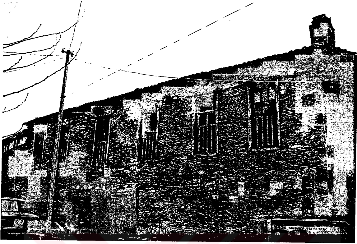
Resim 1. Kadir İşcan Evi, kuzey yöndeki giriş cephesi.
