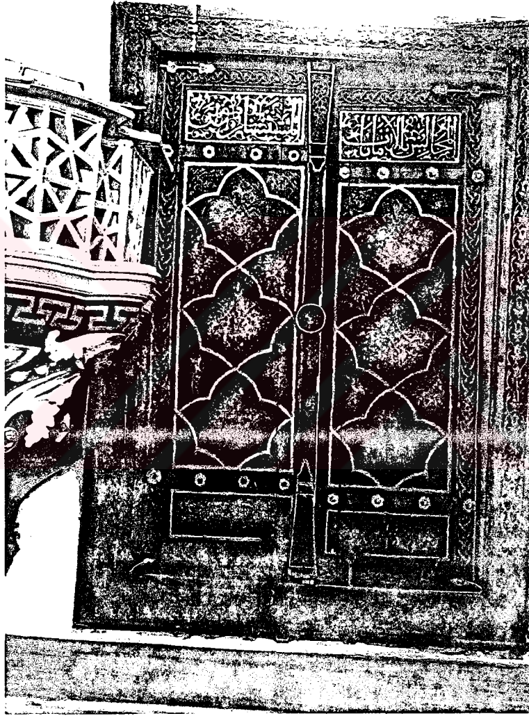
Resim 28. Ulu Cami, güney duvarın doğu köşesinde yer alan ahşap kanatlı pencere açıklığı.
