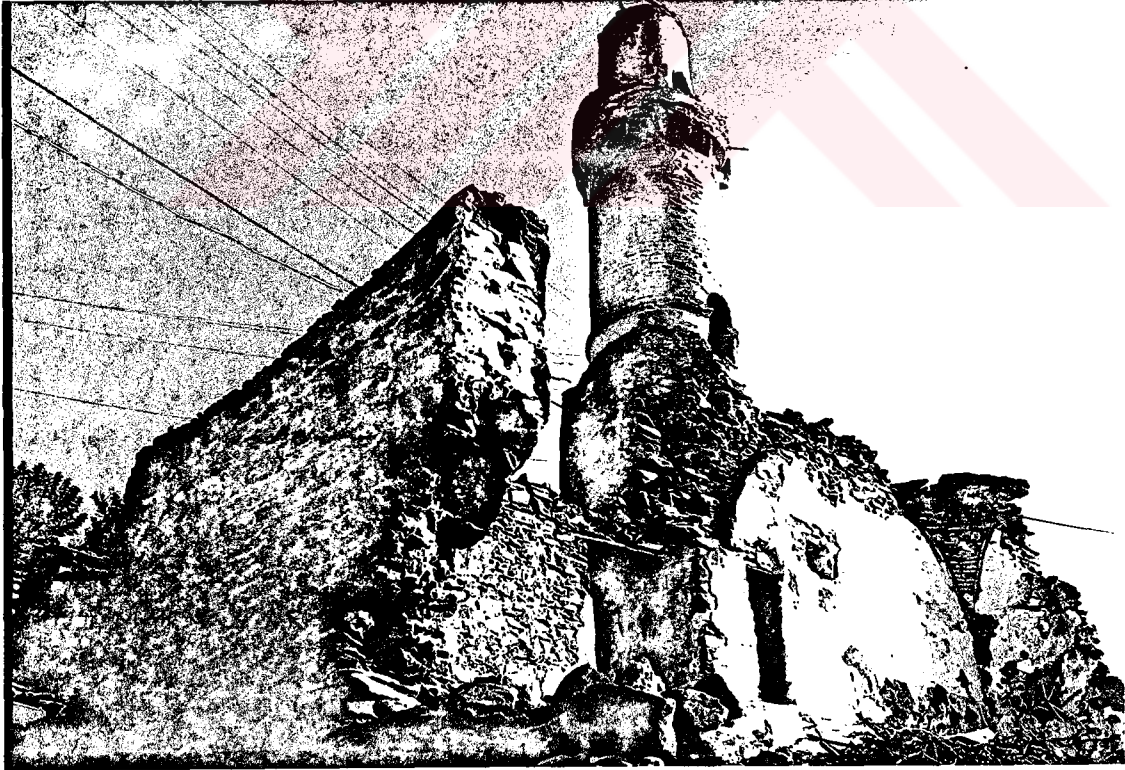
Resim 6. Gdk Minare Camii, gney-batı ynden yapının genel grnm.
