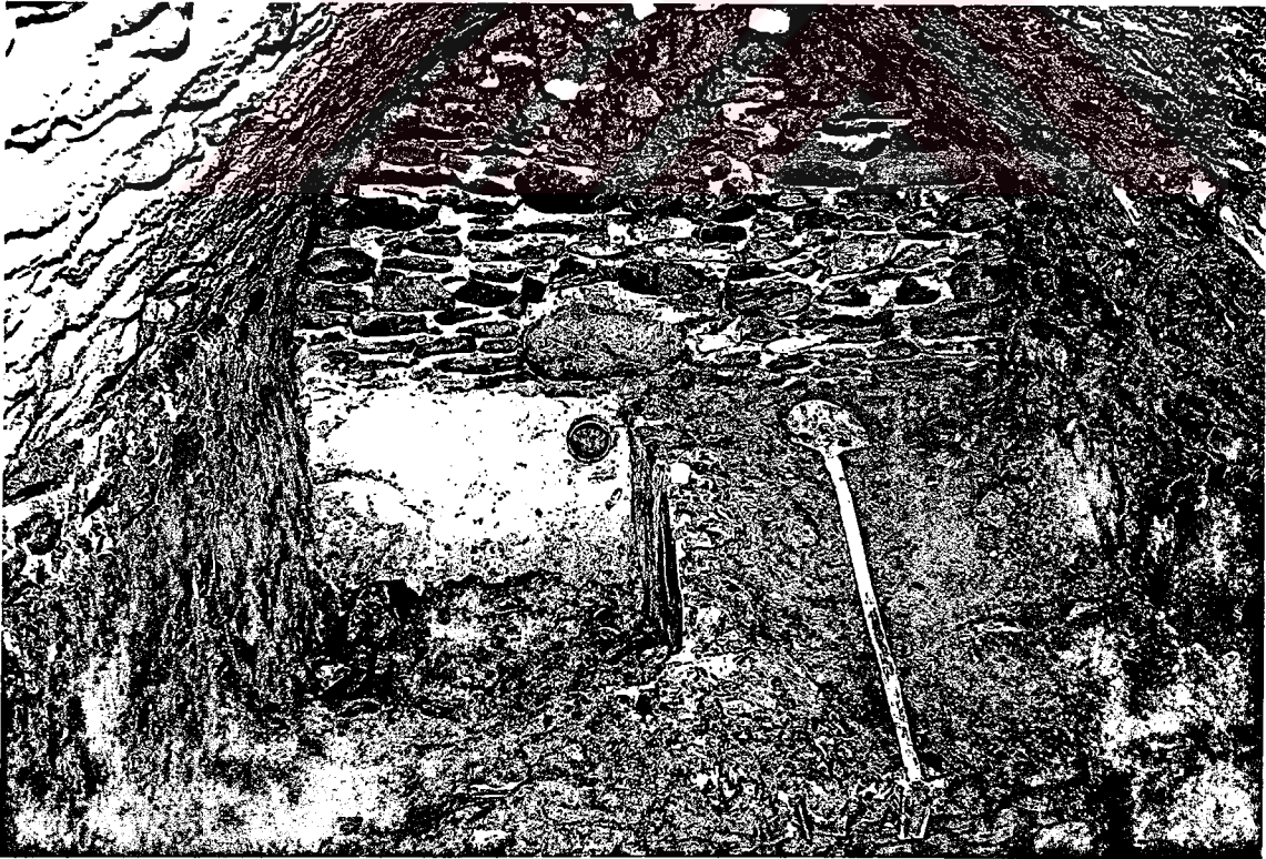
Resim 10. Aydınođlu Meydanı' ndaki Hamam, iki blm halinde dzenlenmiř olan halvetin, sivri kemerli beřik tonozla rtl blm.
