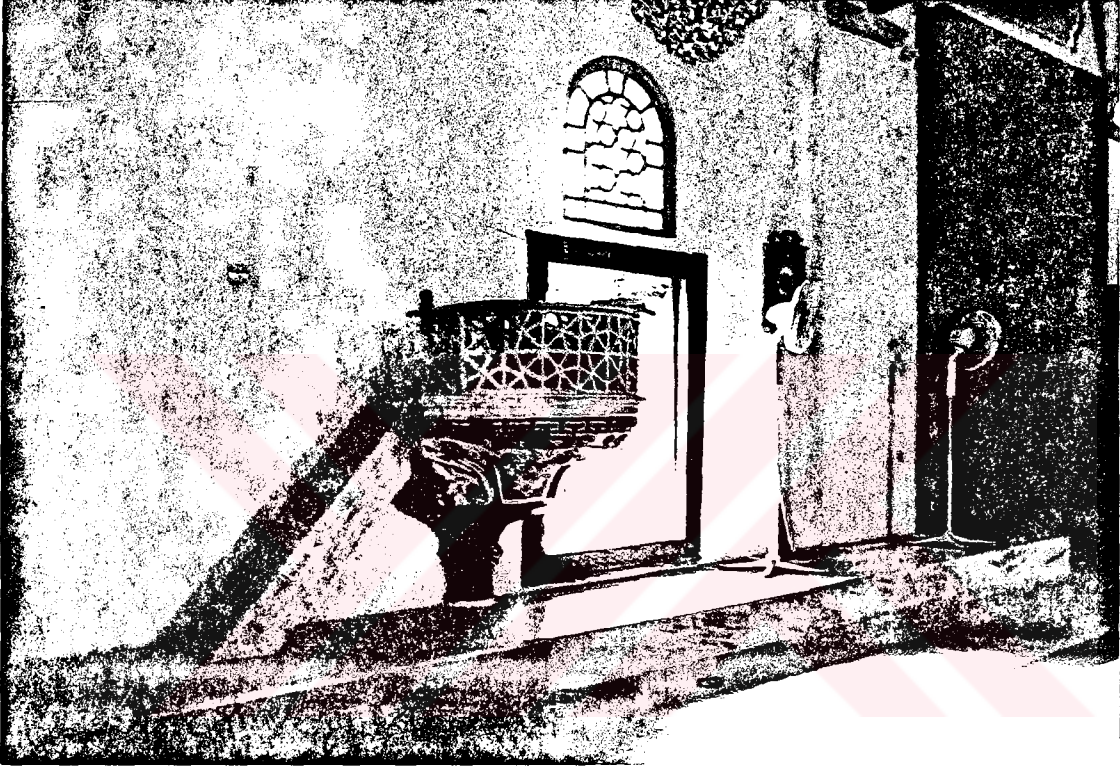
Resim 41. Ulu Cami, güney duvarı üzerindeki vaaz kürsüsü.
