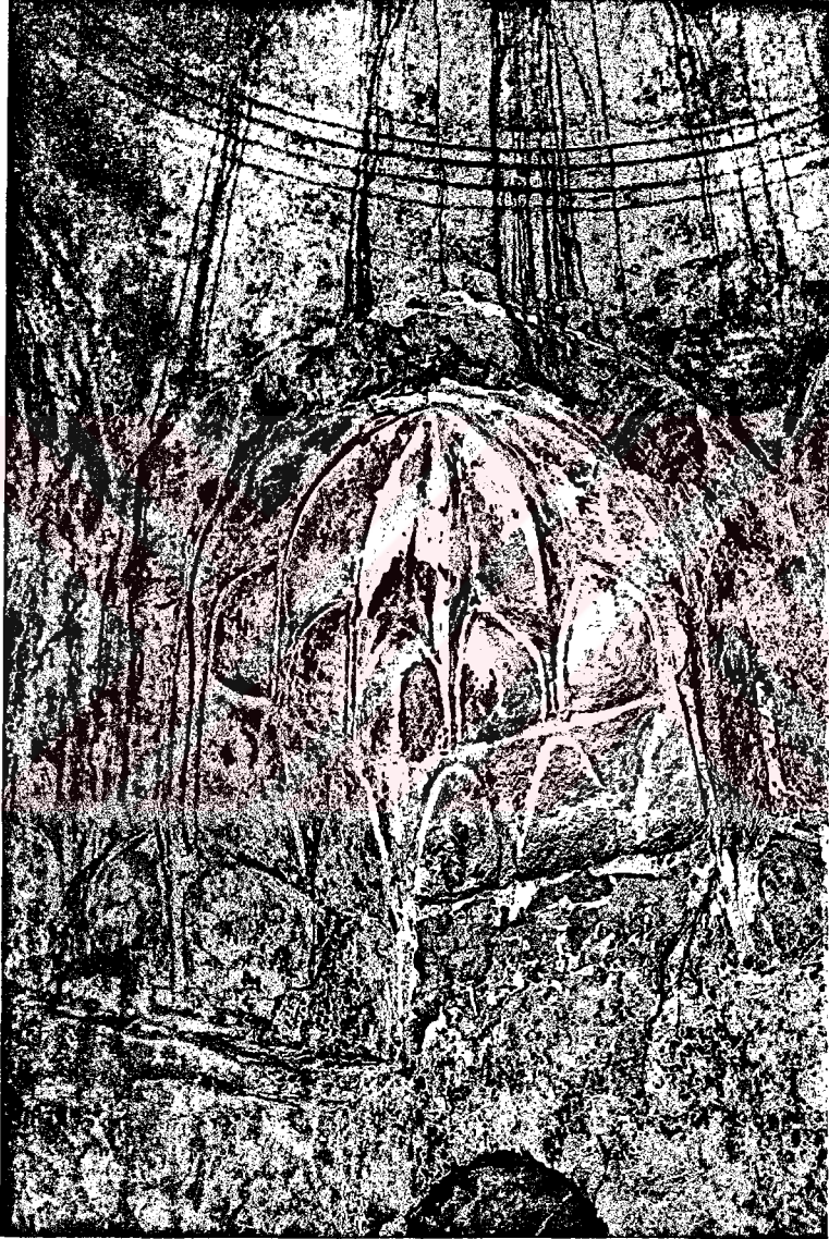
Resim 6. Derviş Ağa Hamamı, sıcaklık mekanının kubbeye geçiş elemanları.
