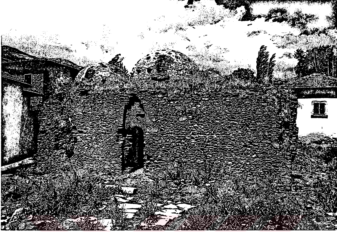
Resim 1. Derviş Ağa Hamamı, batı cephesi üzerindeki giriş ve önündeki yıkılmış olan soyunmalık kısmının kalıntıları.
