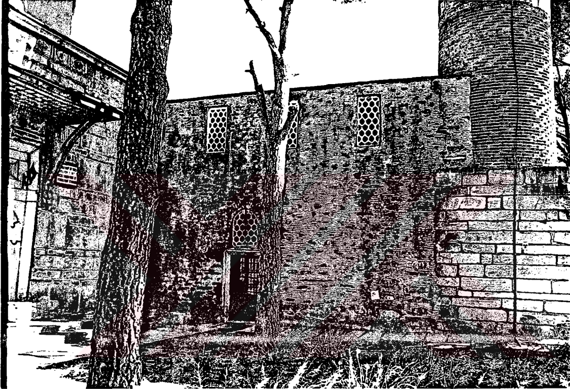
Resim 5. Ulu Cami, batı cephe ve minare kaidesi.
