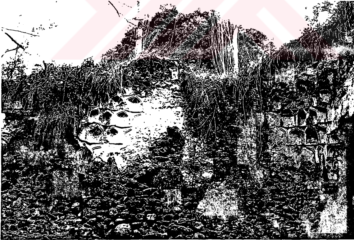
Resim 8. Çukur Yağhane, 4 No' lu mekanın, güney duvarı ve iri mukarnaslı pendentif şeklindeki kubbe geçişleri.
