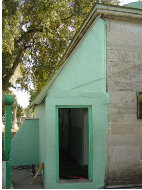
Fot. 2.48 Hasan Sezaî Türbesi önündeki ek mekan (2008)
