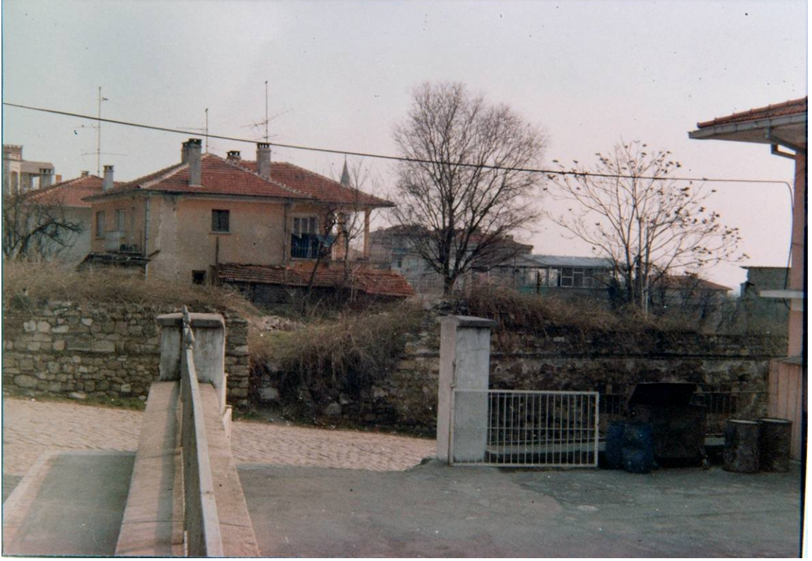
Fot. 2.108 Kadirihane Tekkesi duvar kalıntıları, kuzey cephesi (1988, EM.Arşivi)
