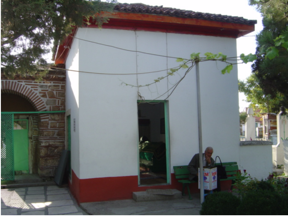
Fot. 2.55 La'li Fenai ve Aşık Efendi Türbesi, doğu cephesi (2008)
