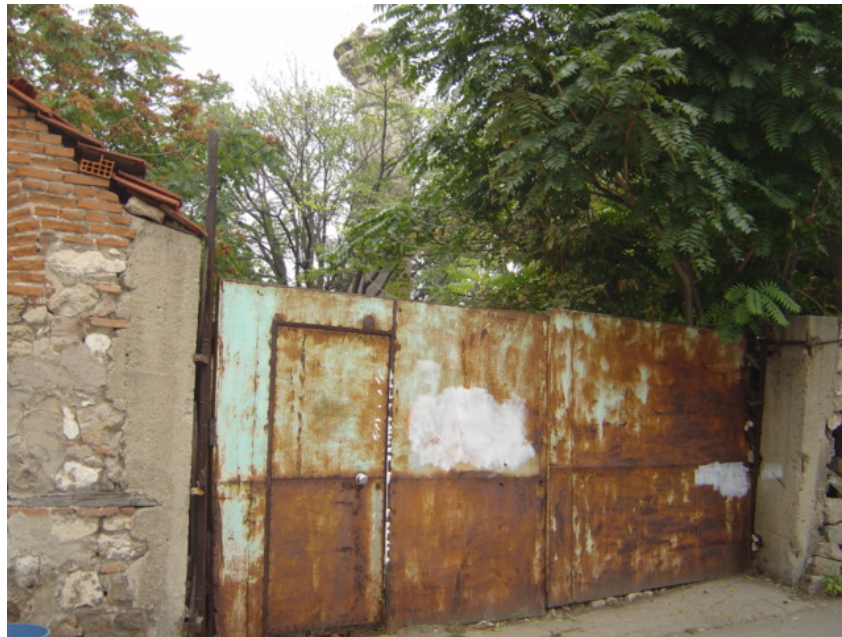
Fot. 2.78 Veli Dede Tekkesi giriş cephesi
