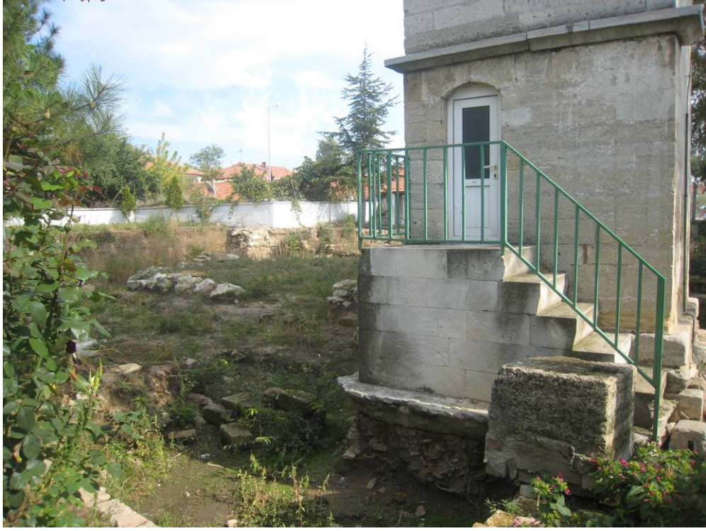
Fot. 2.41 Minare kaidesi, güneyden (2008)
