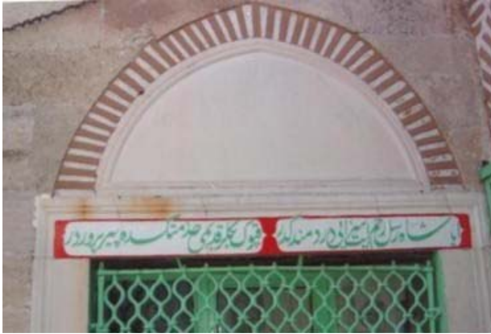
Fot. 2.44 Hasan Sezaî Türbesi, kuzey cephesi (2008)
