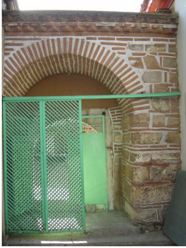
Fot. 2.37 Hasan Sezaî Tekkesi giriş kapısı, içerden (2008)
