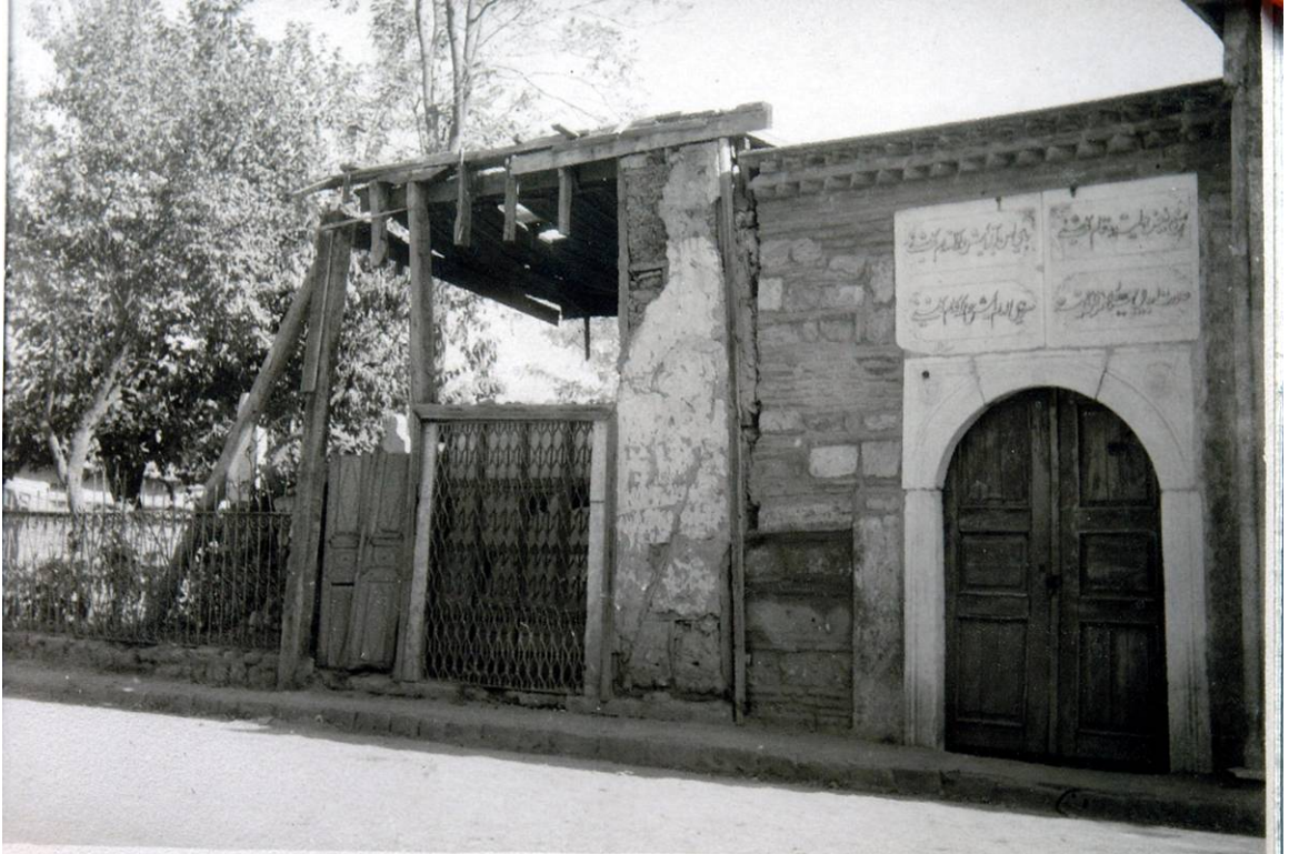
Fot. 2.54 La'li Fenai ve Aşık Efendi Türbesi, batı cephesi (1957, EVBM. Arşivi)
