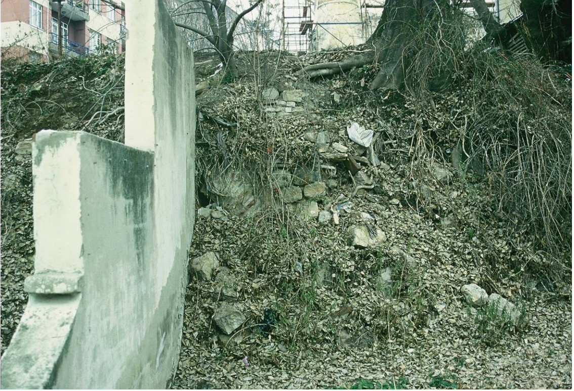
Fot. 2.111 Kemer kalıntısı, batı cephesi (2005)
