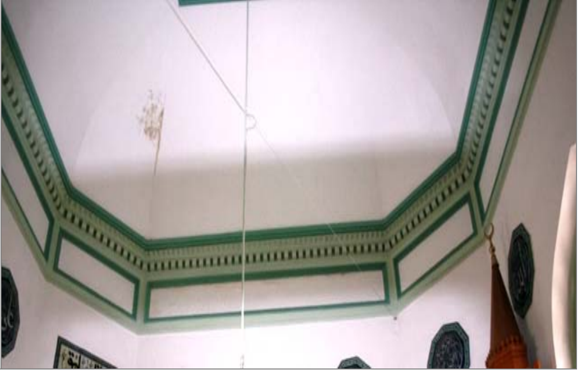
Fotoğraf 25: Saçak kornişi ve alçı süslemeden görünüş.
