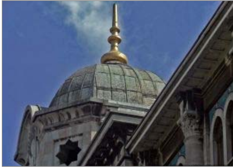
Fotoğraf 28: Postahane Binası'nın kubbesi.
