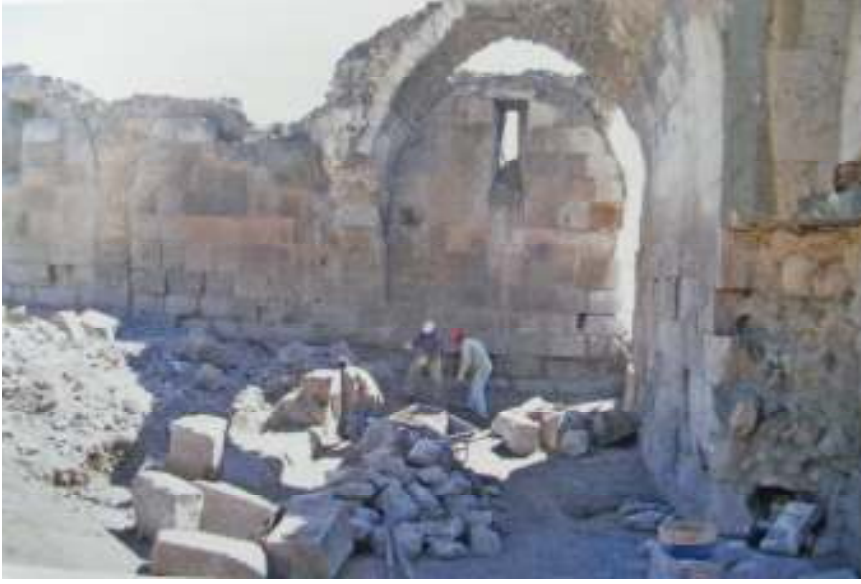
Fotoğraf 55: Güneydoğu Kesimdeki Kalıntılar (Anadolu Selçuklu Dönemi Kervansarayları, Kültür ve Turizm Bakanlığı Yayınları, Ankara 2007)
