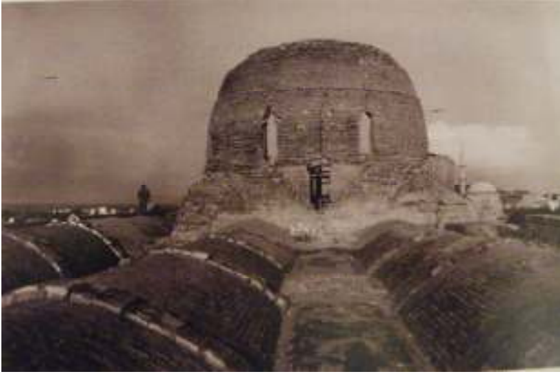
Fotoğraf 4: Dunaysır Ulu Camisi, tonozların atkı kemerleri (D.Kuban, Selçuklu Çağında Anadolu Sanatı , Yapı Kredi Yayınları, İstanbul 2002 )
