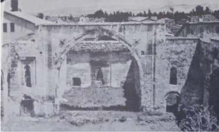
Fotoğraf 6: Sivas İzzeddin Keykavus Şifhanesi avlu eyvanı (O. Aslanapa, Türk Sanatı , Remzi Kitabevi, İstanbul 1984)
