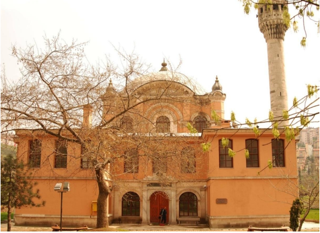
Fotoğraf 5: Haliç Sâdâbâd Camisi, Kuzey giriş cephesi.
