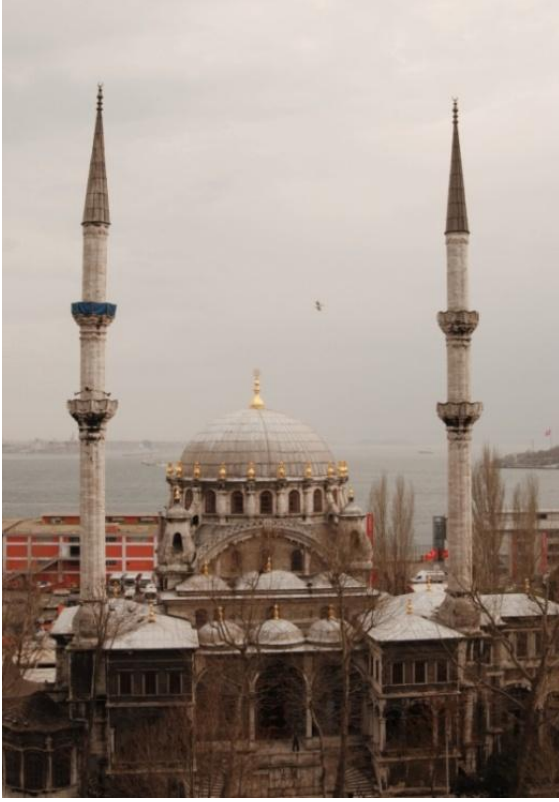
Fotoğraf 10: Nusretiye Camisi, Kuzey giriş cephesi.
