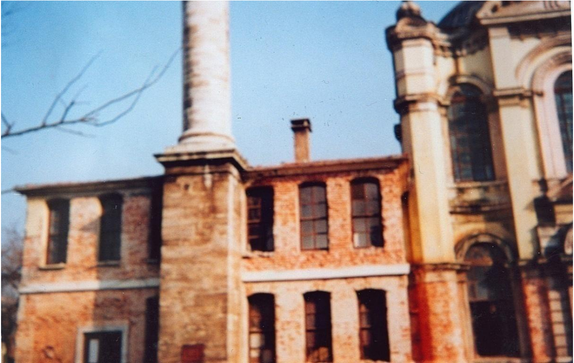
Fotoğraf 49: Haliç Sâdâbâd Camisi, 1998 yılı onarım öncesi batı cephesi. (Kaynak: Şura Kavalcı Özel Arşivi)
