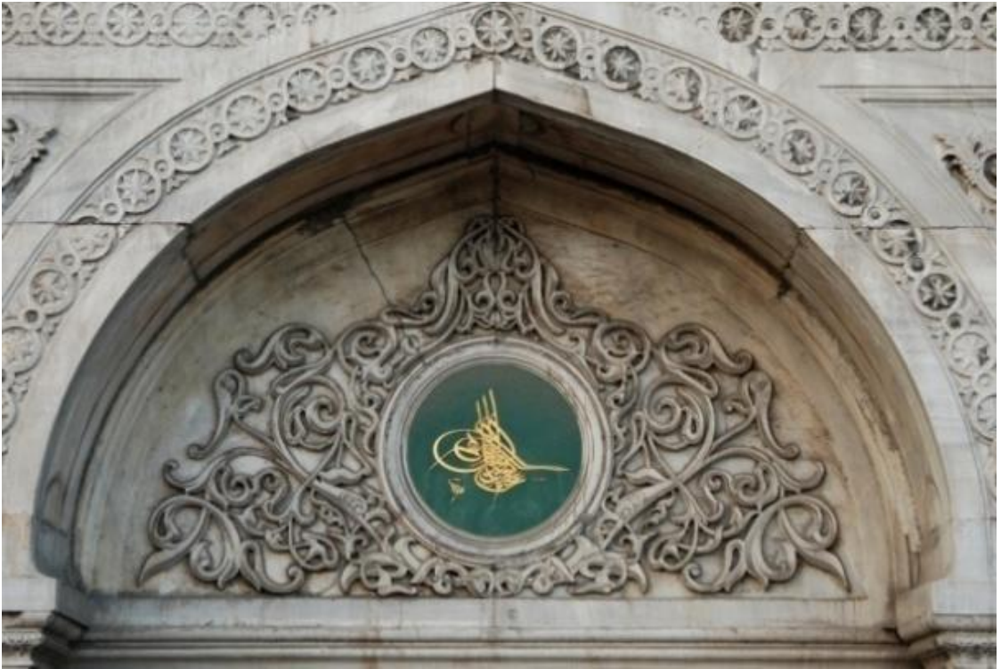
Fotoğraf 16: Aksaray Valide Camisi, Taç kapı üzerinde yer alan yapı kitabesi.
