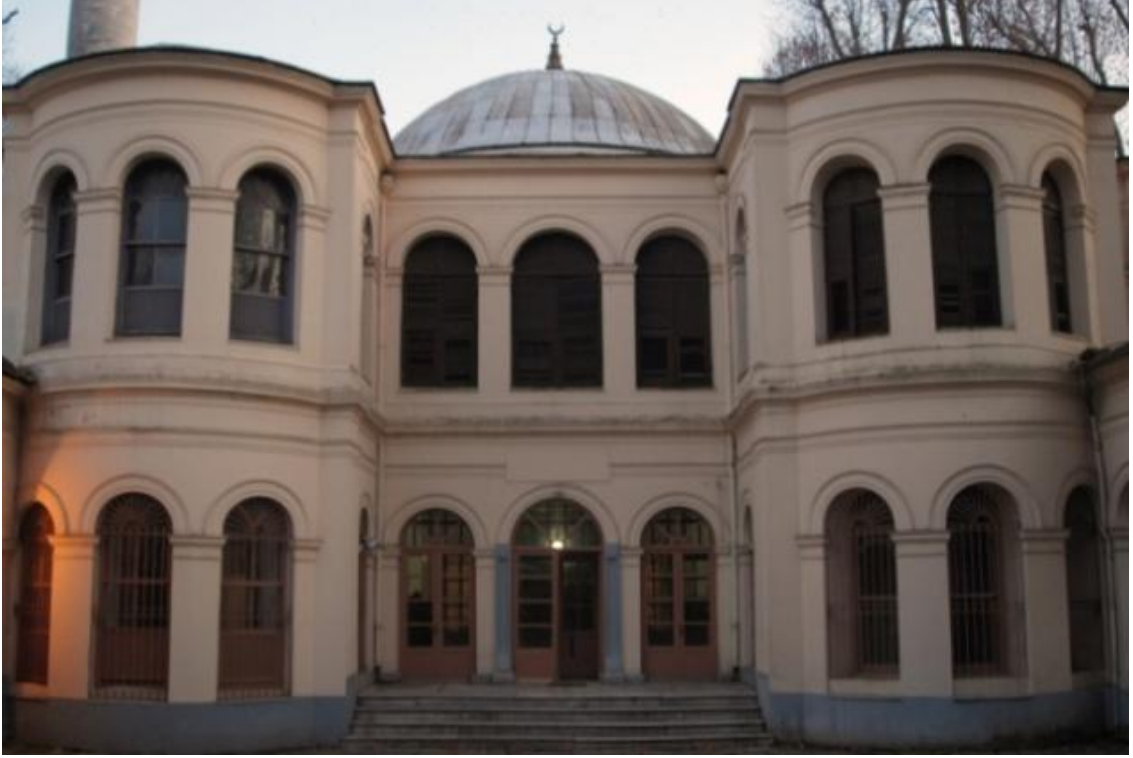
Fotoğraf 9: Küçük Mecidiye Camisi, Kuzey giriş cephesi.
