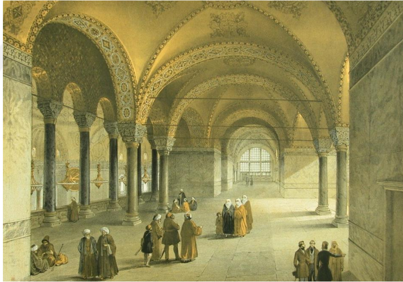
Şekil 4.21 Gaspard Fossati, 1852, Ayasofya güney galeride batıdan doğuya bakış. Fossatiler mozaikle ilgili çizimler yapmışlarsa da mozaiklerin bulunduğu tarih ve resimlerin tarihi bulunmamaktadır. 265 Onarımda galeri katının tamamı sıvanarak kalemişi ile bezenmiştir. Ana mekâna bakan sütunların taşıdığı duvar yüzeyindeki bezemlere ise dokunulmamış aynen sergilenmiştir. (Gaspard Fossati, Aya Sofia Constantinople as recently Restored by... Levha 13)
