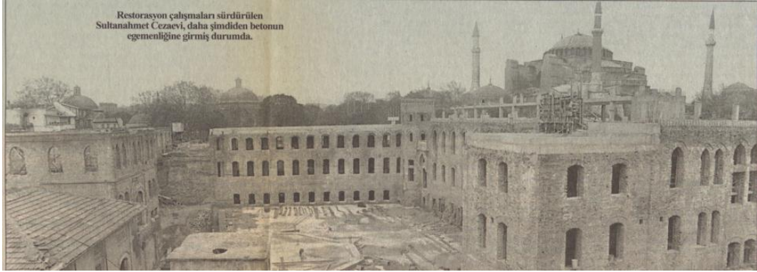
Fotoğraf 4.77 Mehmet Demirkaya 1995,Sultanahmet Cezaevi binası restorasyon sırasında cezaevi binası. ( http://earsiv.sehir.edu.tr 547 )
