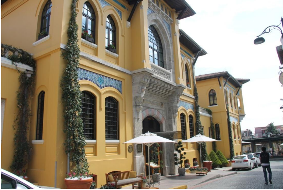
Fotoğraf 4.78 Esengül Yıldız Altunbaş, 2016, Sultanahmet Tevkifhanesi (Four Seasons Oteli) giriş cephesi mevcut durumu.
