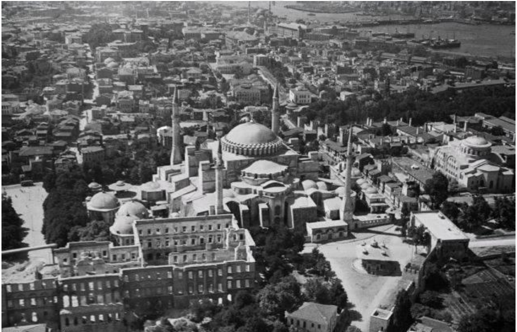
Fotoğraf 4.69 1933 yılı çıkan yangından sonra Darülfünun binasının durumu ( https://www.tarihtarih.com/?Syf=4&Fa=2&Id=231556 05.03.2016)
