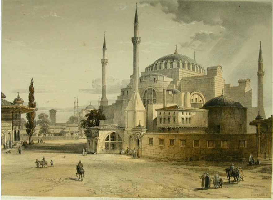
Şekil 4.14 Gaspare Fossati, 1852, Bab-ı Hümayun'dan Ayasofya kuzeydoğu cephesine bakılmaktadır. Mahfil kapısının cephesi değişmiş, kapı ortaya alınarak iki yanına pencere yerleştirilmiştir. Kapı üstünde hünkara ait tuğra ve kitabe yerleştirilmiştir.(Gaspard Fossati, Aya Sofia Constantinople as recently Restored by ... Levha 17)
