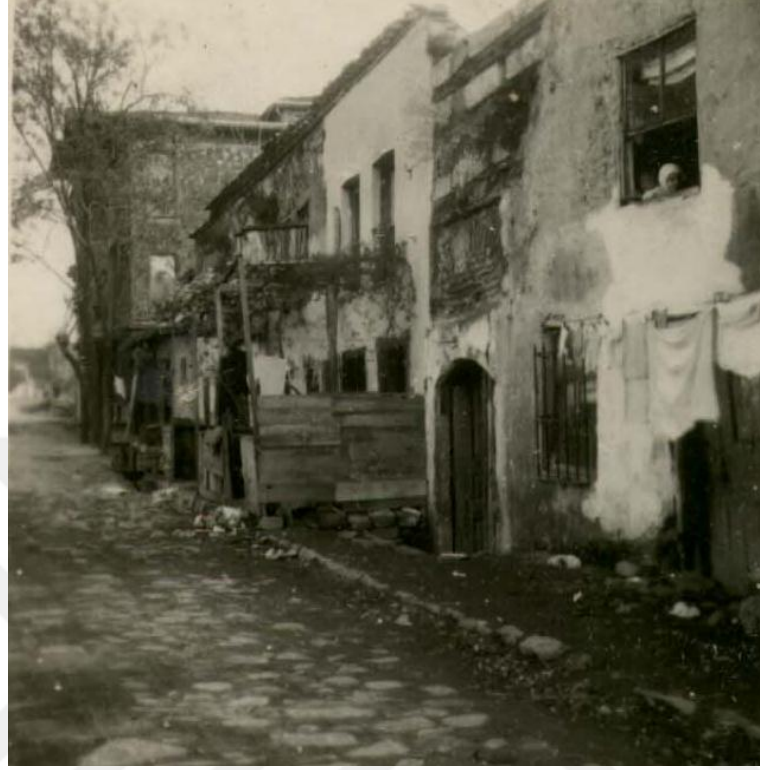
Fotoğraf 4.65 Encümen Arşivi, 1930'lı yıllar, Medrese giriş cephesi
