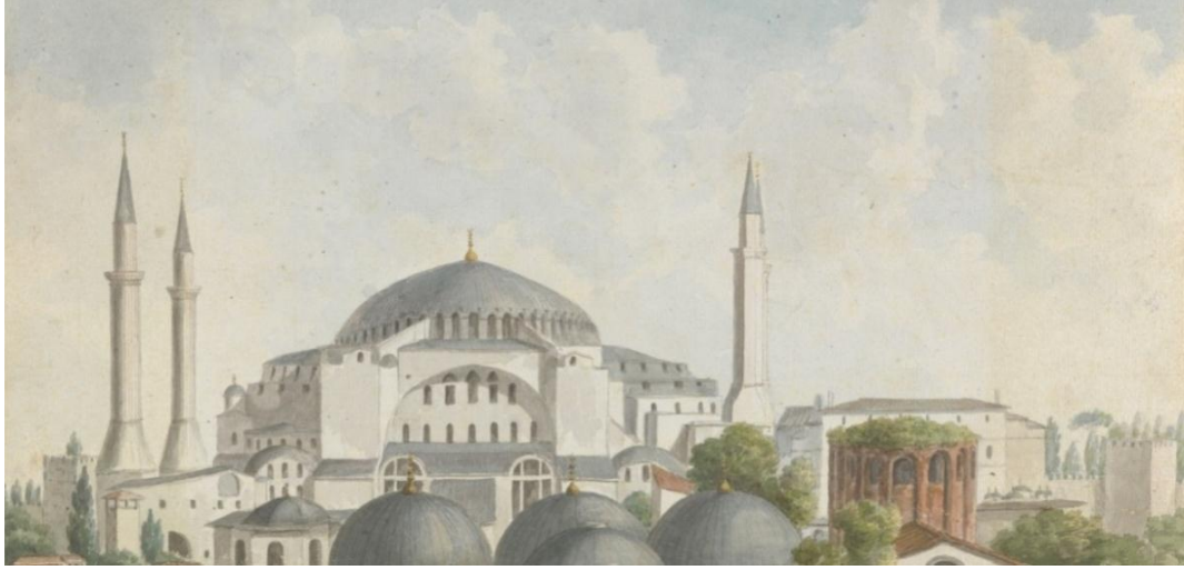
Şekil 4.2 Willey Reveley, 1785, Fossati onarımlarından önce Ayasofya güney yönünün görünümü. ( http://discover.odai.yale.edu/ydc/Record/3634481 2.1.2016)
