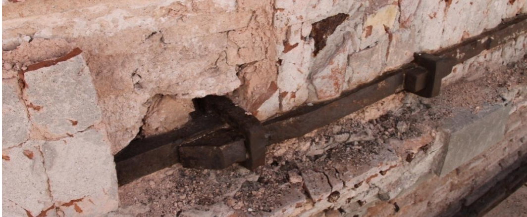
Fotoğraf 4.1 Esengül Yıldız Altunbaş, 2014, Kuzeybatı yönünde kasnağında tespit edilen gergi çemberi.
