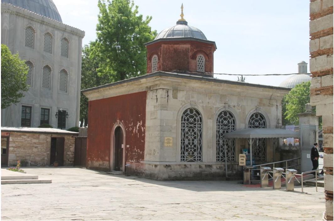
Fotoğraf 4.26 Esengül Yıldız Altunbaş, 2016, Muvakkithane binası mevcut durum.
