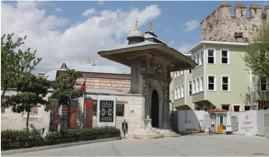
Fotoğraf 4.84 Esengül Yıldız Altunbaş, 2016, Tekke binası mevcut durumu.
