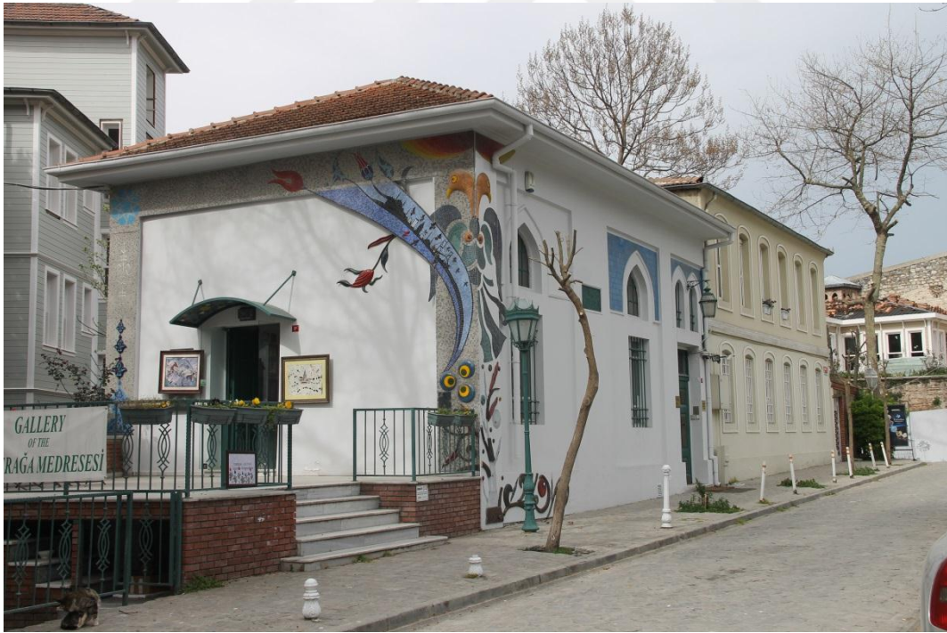
Fotoğraf 4.88 Esengül Yıldız Altunbaş, 2016, Tekke binası mevcut durumu.
