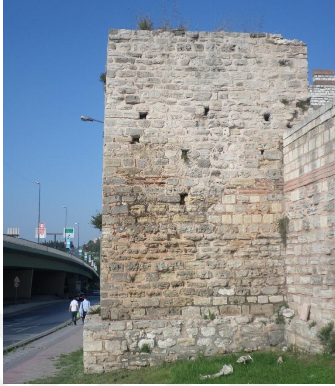
Fotoğraf 159: Topkapı ile Vatan Caddesi Arasındaki Ön Sur Duvarı Üzerinde Yer Alan Kare Burcun Sağ Cephesi
