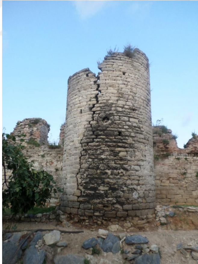
Fotoğraf 106: Silivrikapı ile Mevlevihanekapı Arasındaki Ön Sur Duvarında Yer Alan Silindirik Formlu Burcun Ön Cephesi
