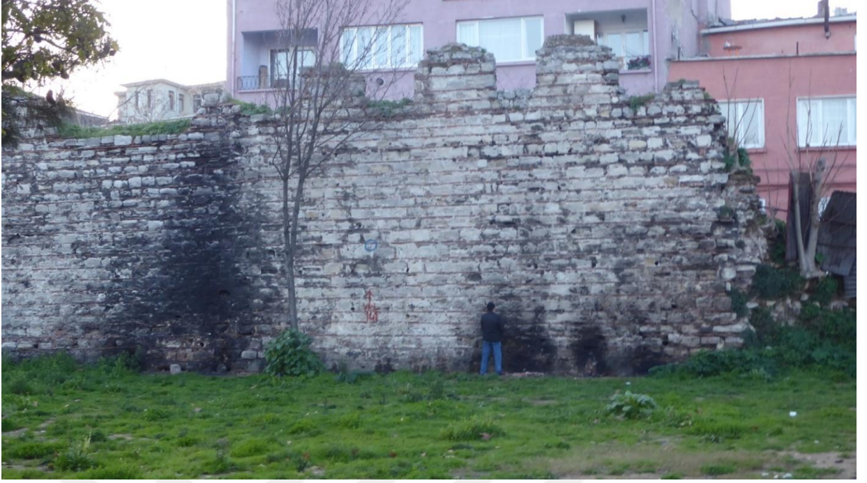
Fotoğraf 409: Marmara Sur Hattı
