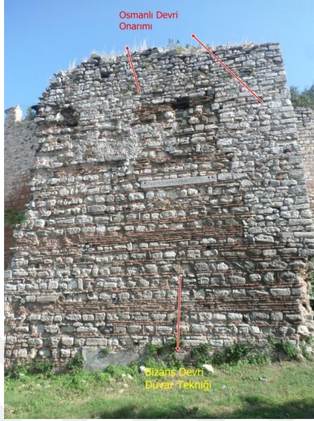
Fotoğraf 255: Eğrikapı ile Ayvansaray Arasındaki Sur Hattında Yer Alan Kare Burcun Ön Cephesi
