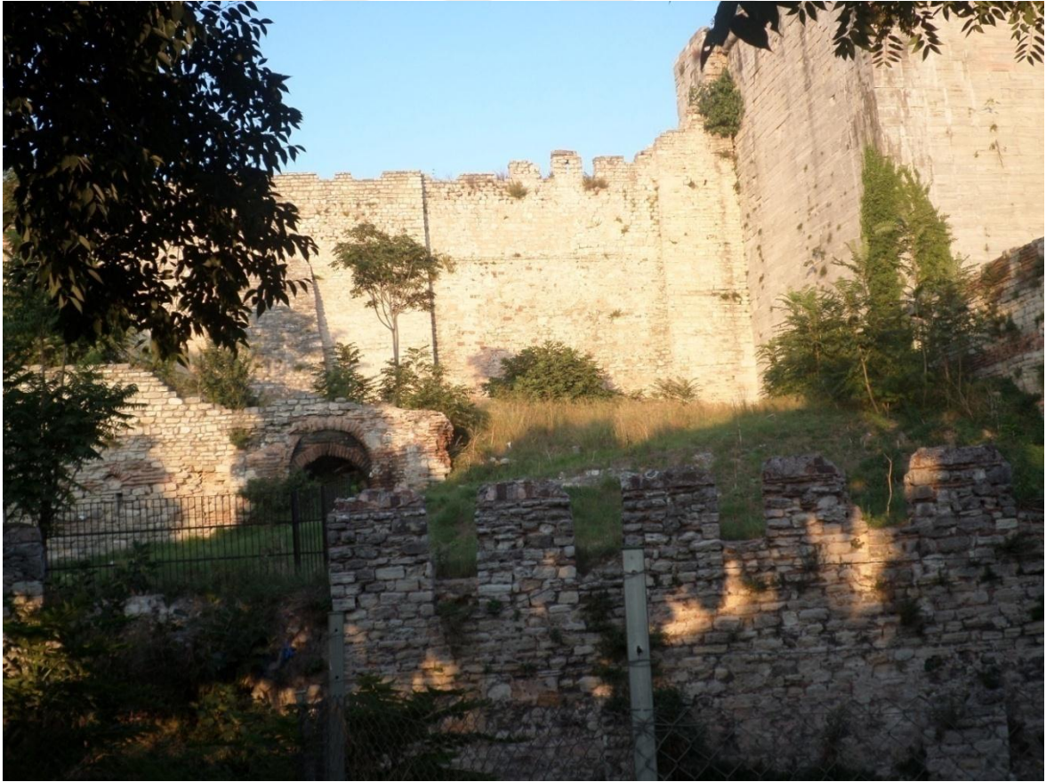
Fotoğraf 28: Küçük Altın Kapı ile Yedikule Kapı Arasındaki Yedikule Hisarına Ait Beden Duvarları
