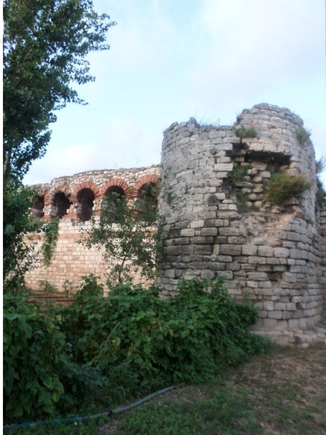
Fotoğraf 112: Silivrikapı ile Mevlevihanekapı Arasındaki Ön Sur Duvarında Yer Alan Silindirik Formlu Burç
