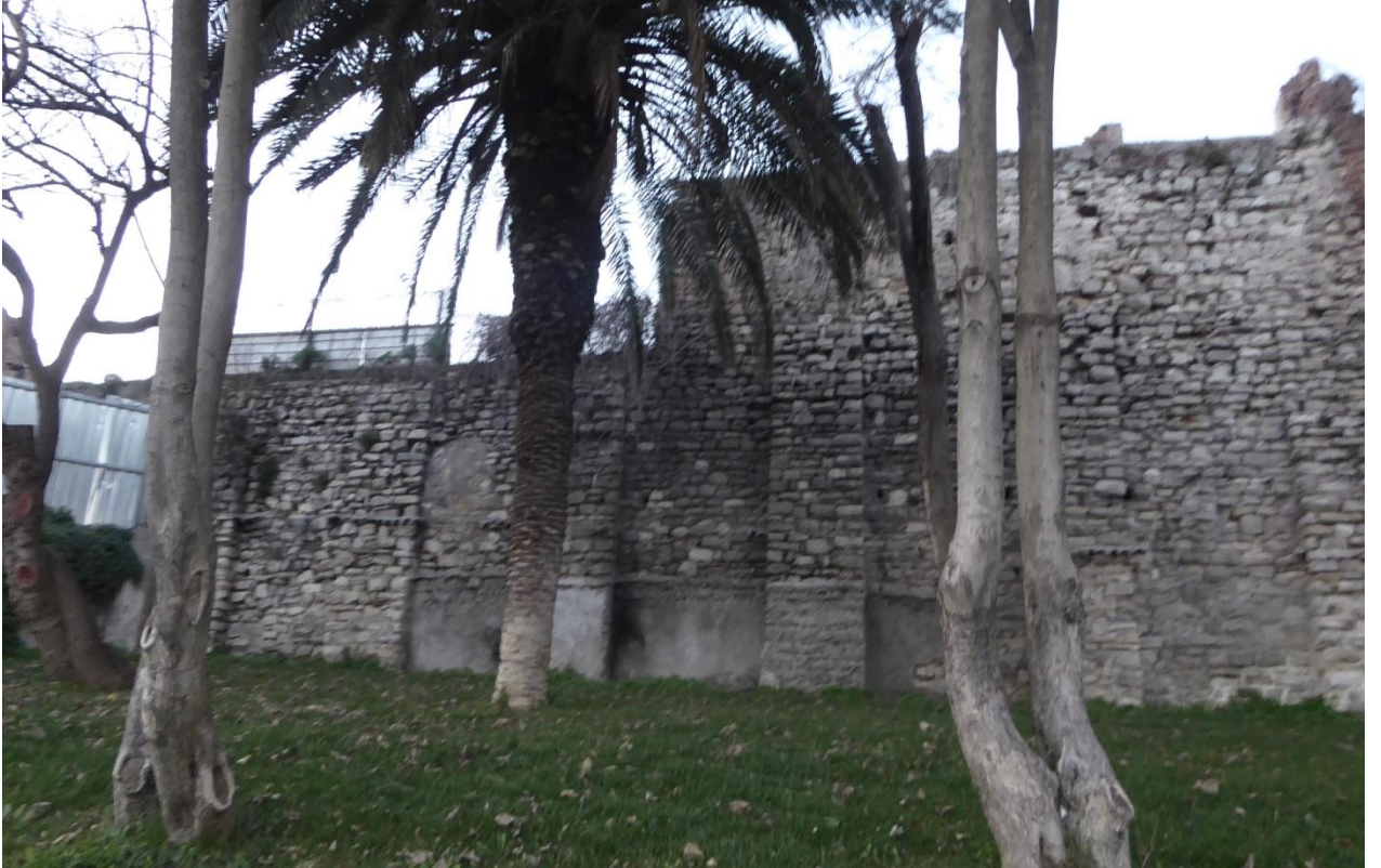
Fotoğraf 424: Narlıkapı ile Mermer Kule Arasındaki Marmara Sur Hattı
