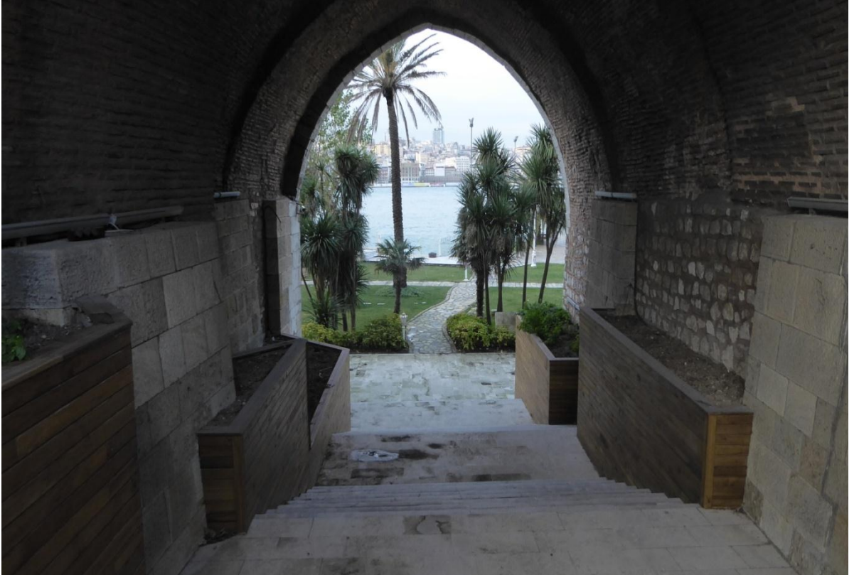
Fotoğraf 330: Sepetçiler Kasrı Tonozla Örtülü Platform Altından Deniz Cehesine Geçiş
