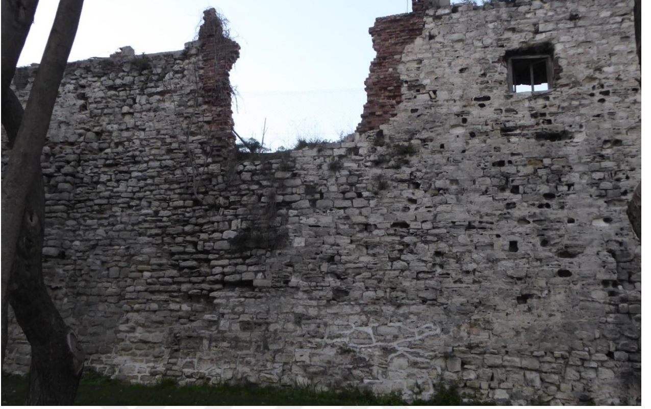
Fotoğraf 423: Narlıkapı ile Mermer Kule Arasındaki Marmara Sur Hattı
