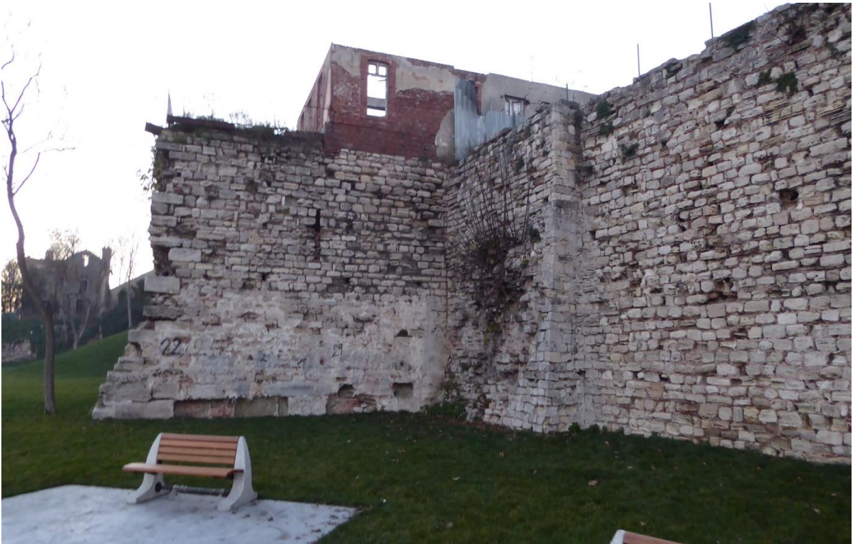
Fotoğraf 430: Narlıkapı ile Mermer Kule Arasındaki Marmara Sur Hattı
