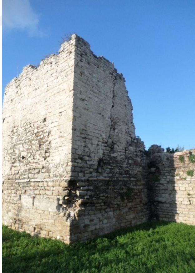
Fotoğraf 62: Yedikule Kapı ile Belgrad Kapı Arasında Yer Alan Ön Sur Duvarındaki Kare Burcun Sağ Cephesi
