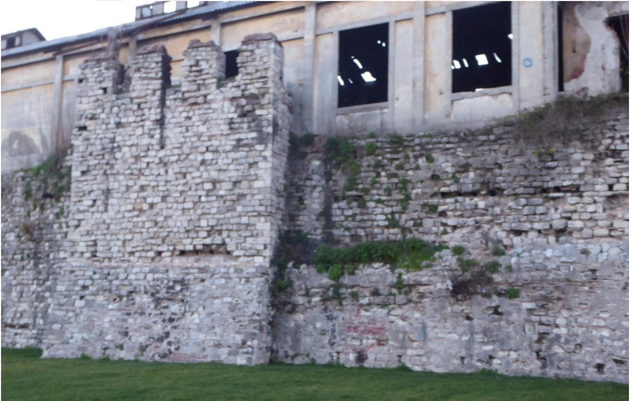
Fotoğraf 428: Narlıkapı ile Mermer Kule Arasındaki Marmara Sur Hattı
