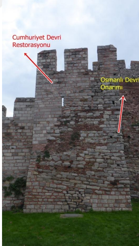
Fotoğraf 272: Ayvansaray Sur Hattı Üzerinde Yer Alan Burcun Ön Cephesi
