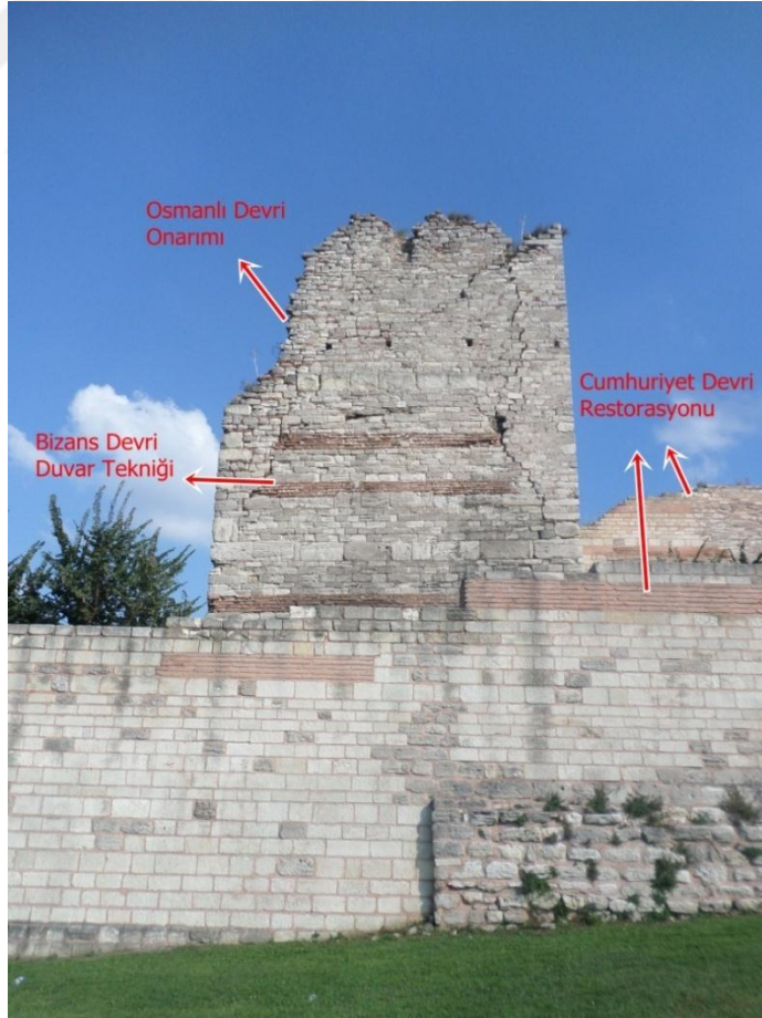
Fotoğraf 156: Topkapı ile Vatan Caddesi Arasındaki Ana Sur Üzerinde Yer Alan Burcun Ön Cephesi
