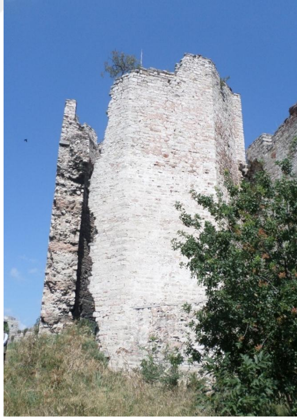
Fotoğraf 12: Kara Surları Başlangıcından Yedikule Hisarına Doğru Ana Sur Duvarı Üzerinde Yer Alan Çokgen Planlı Burcun Cephesi
