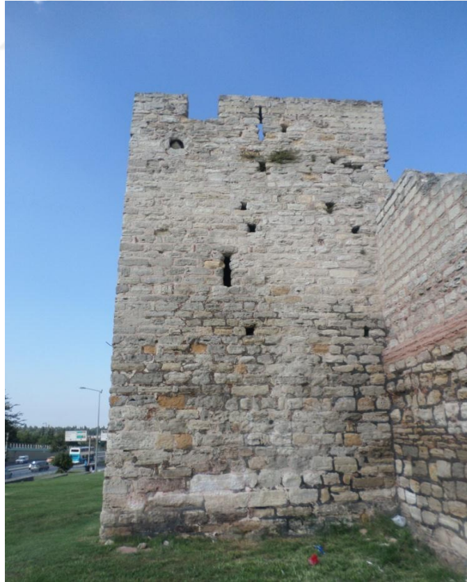
Fotoğraf 152: Topkapı ile Vatan Caddesi Arasındaki Ön Sur Duvarında Yer Alan Kare Burcun Sağ Cephesi
