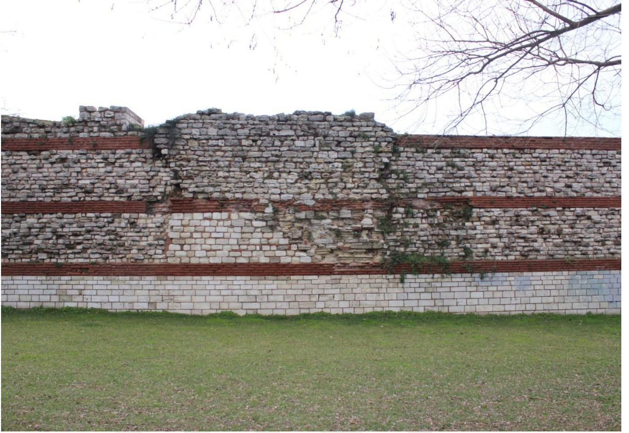
Fotoğraf 175: Vatan Caddesi ile Sulukule Kapı Arasındaki Ana Sur Duvarı
