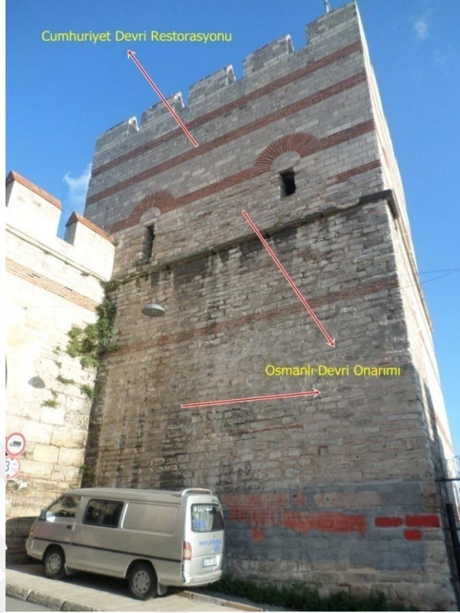
Fotoğraf 65: Belgrad Kapı Sınırlandırıcı Sağ Bölümdeki Burcun Cephe Görüntüsü
