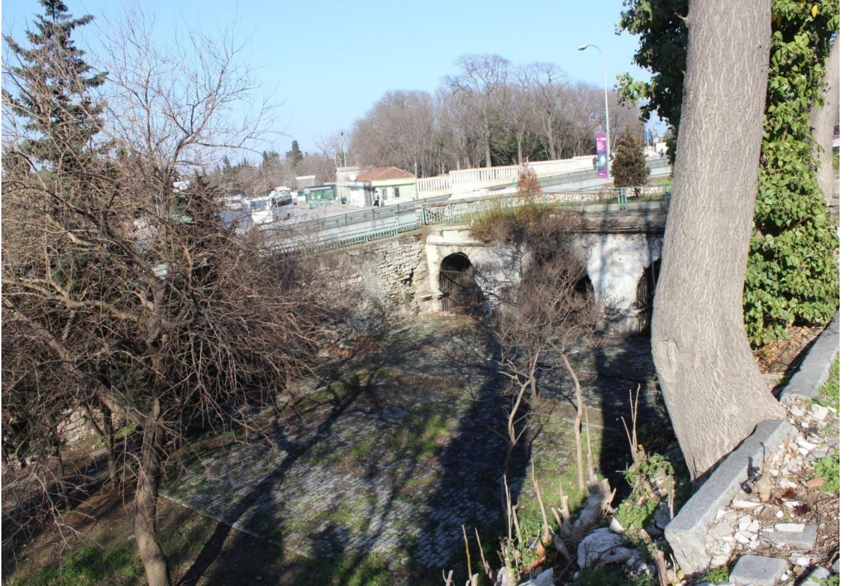
Fotoğraf 202: Edirnekapı Hendek Köprüsü'nün Sur Zemininden Görünümü
