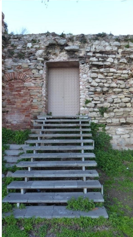
Fotoğraf 374: Marmara Sur Hattında Sonradan Açılmış Bir Kapının Günümüzdeki Kullanımı
