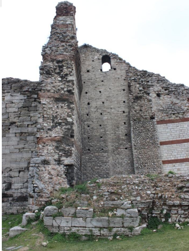
Fotoğraf 178: Sulukule Kapısı'nı Sınırlandıran Burç Kalıntısının Ön Cephesi
