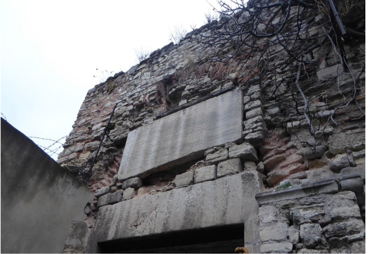
Fotoğraf 420: Narlıkapı ve Üzerinde Yer Alan Kitabe Panosu(Kitabe Metni Ahırkapı'da Bulunan Kitabe Metni ile Aynı)
