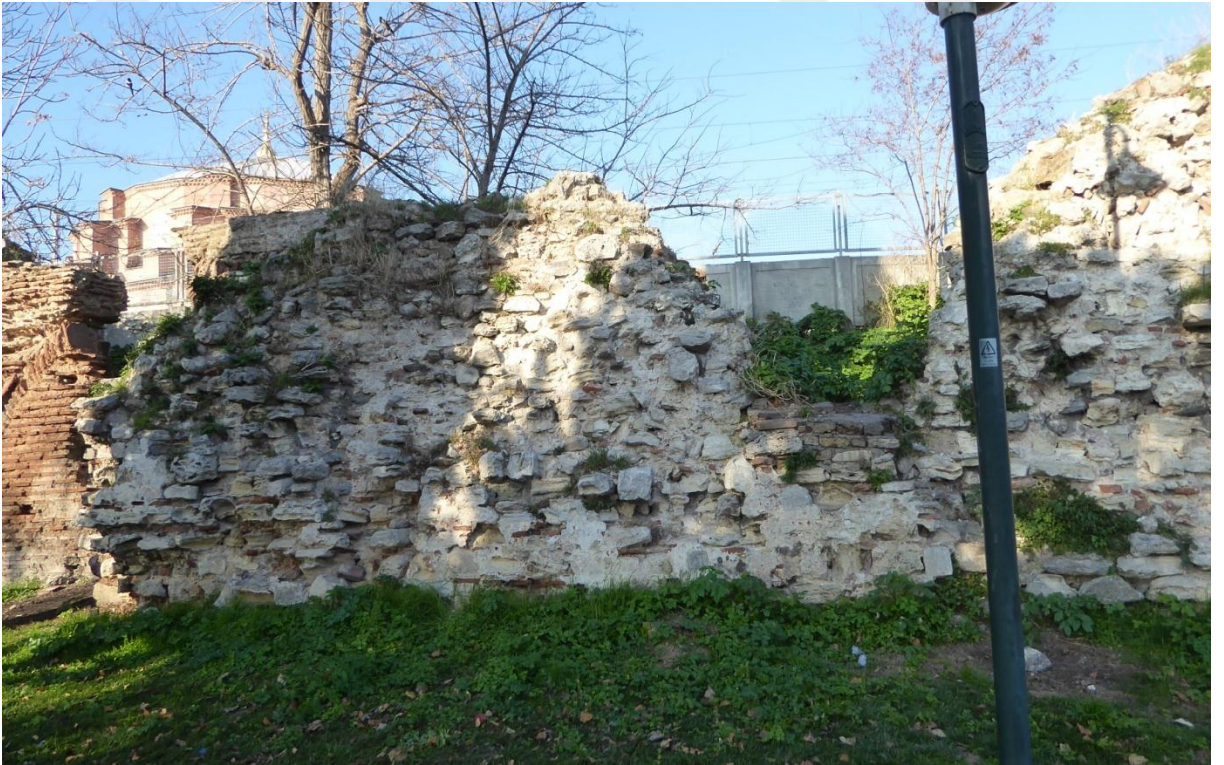
Fotoğraf 390: Marmara Sur Hattı
