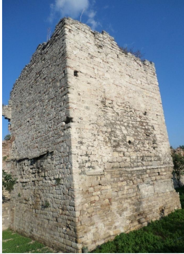
Fotoğraf 63: Yedikule Kapı ile Belgrad Kapı Arasında Yer Alan Ön Sur Duvarındaki Kare Burcun Ön ve Sol Cephesi
