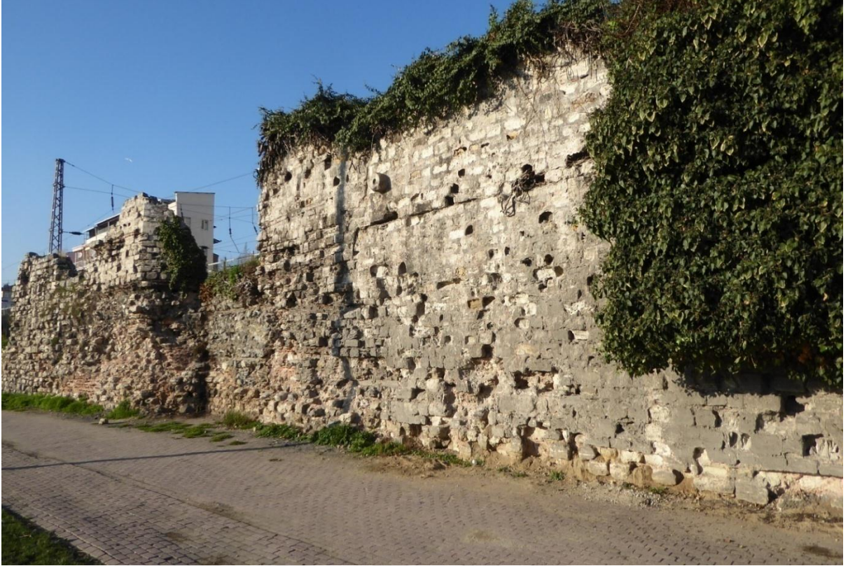
Fotoğraf 397: Marmara Sur Hattı
