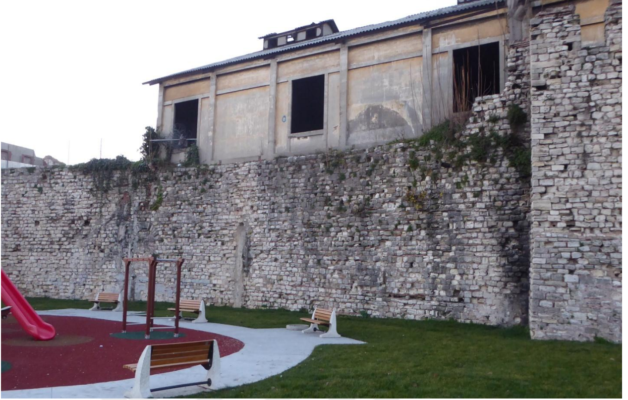
Fotoğraf 429: Narlıkapı ile Mermer Kule Arasındaki Marmara Sur Hattı
