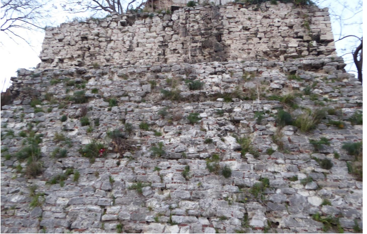
Fotoğraf 425: Narlıkapı ile Mermer Kule Arasındaki Marmara Sur Hattı
