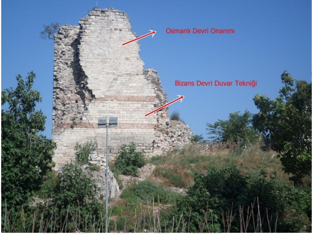
Fotoğraf 99: Silivrikapı ile Mevlevihanekapı Arasındaki Ana Sur Duvarında Yer Alan Burcun Ön Cephesi
