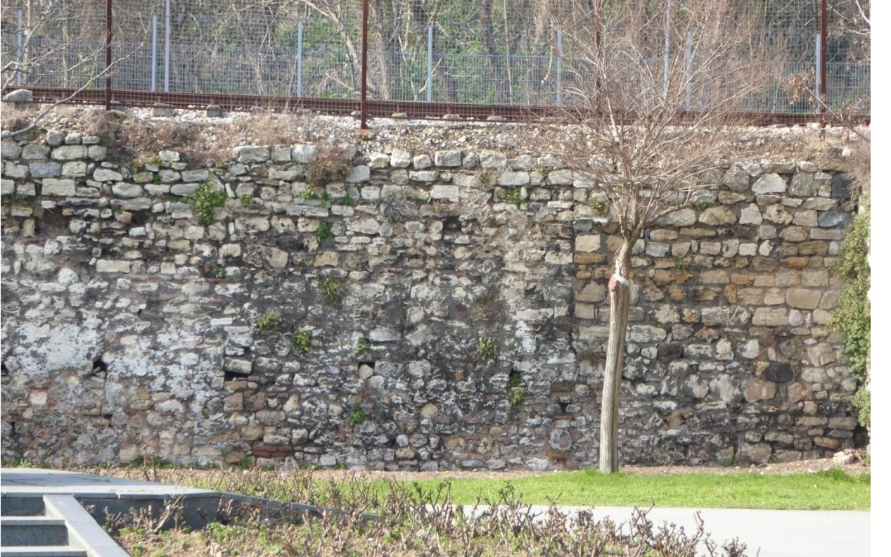
Fotoğraf 338: Marmara Sur Hattı
