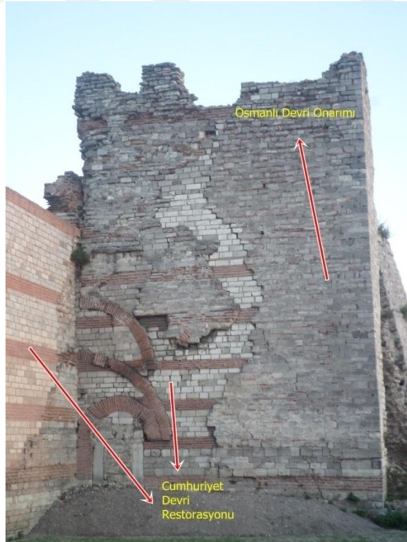
Fotoğraf 72: Belgrad Kapı ile Silivrikapı Arasındaki Ana Sur Duvarındaki Burcun Sol Cephesi
