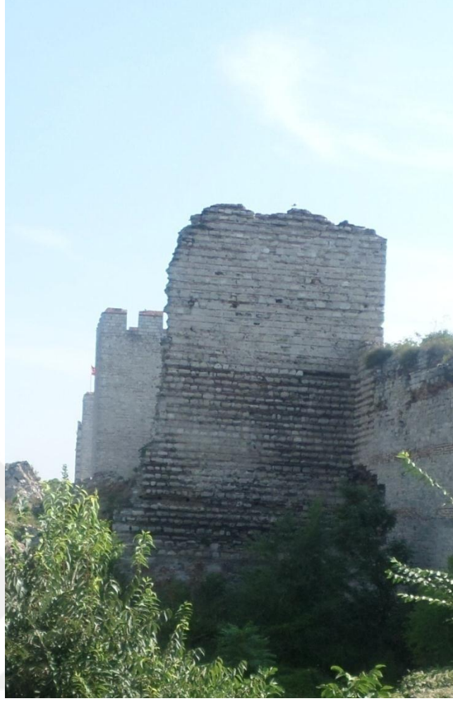
Fotoğraf 131: Mevlevihanekapı ile Millet Caddesi Arasındaki Ana Sur Duvarında Yer Alan Burcun Sağ Cephesi
