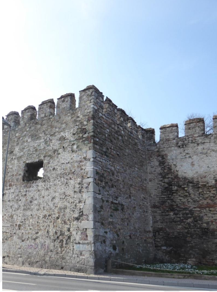
Fotoğraf 333: Tamamen Osmanlı Devrinde İnşa Edilmiş Burç
