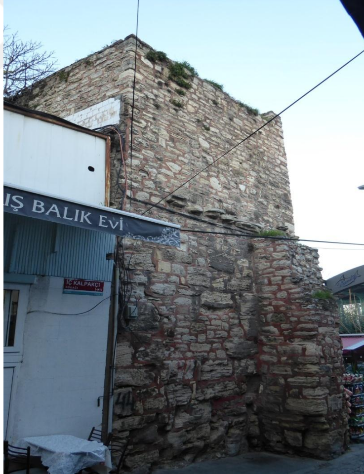
Fotoğraf 408: Samatya Kapısındaki Sur Duvarı
