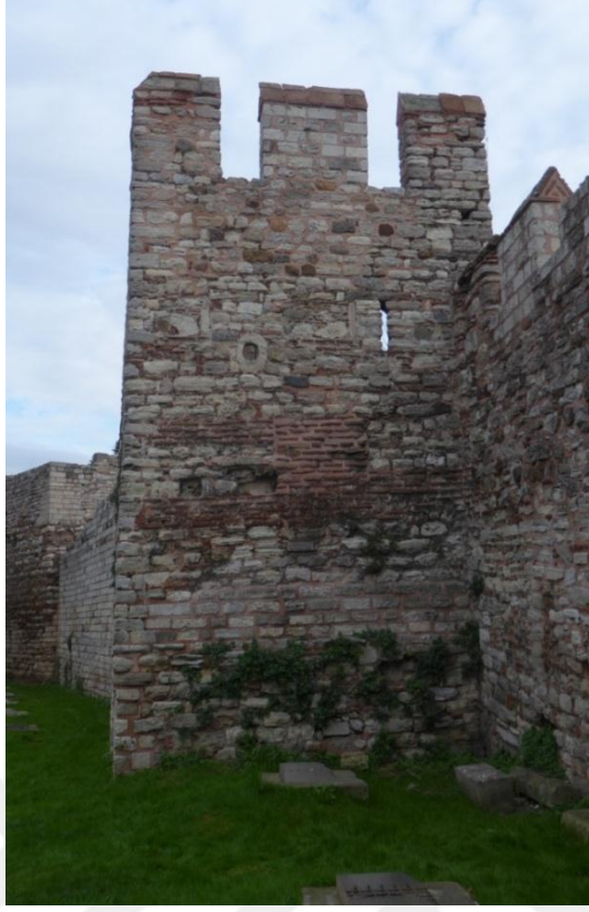
Fotoğraf 271: Ayvansaray Sur Hattı Üzerinde Yer Alan Burcun Sağ Cephesi
