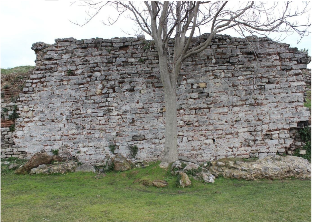
Fotoğraf 186: Sulkule Kapı ile Edirnekapı Arasındaki Ana Sur Duvarının Görünümü
