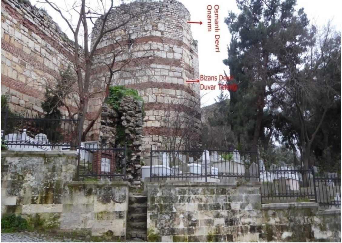
Fotoğraf 243: Fevzi Paşa Caddesi ile Eğrikapı Arasındaki Sur Hattında Yer Alan Burç ve Önünde Yer Alan Hazire
