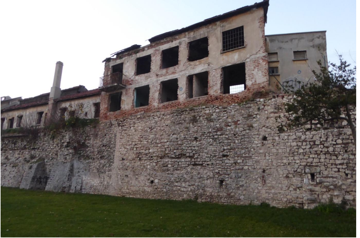
Fotoğraf 427: Narlıkapı ile Mermer Kule Arasındaki Marmara Sur Hattı
