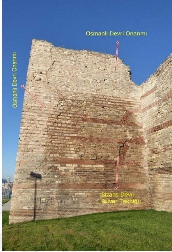
Fotoğraf 227: Fevzi Paşa Caddesi ile Eğrikapı Arasındaki Sur Hattında Yer Alan Burcun Sağ Cephesi
