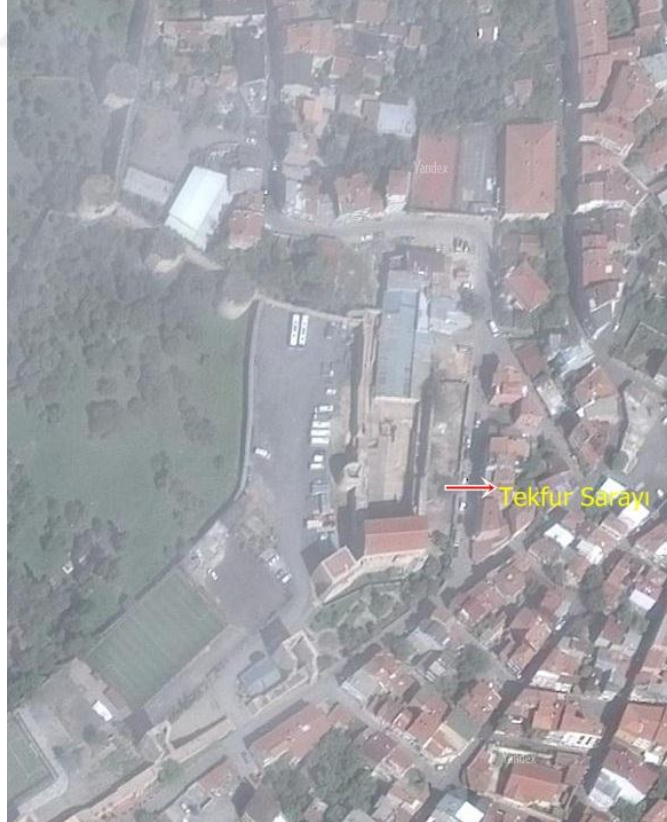
Harita 34 (Uydu Fotoğrafi 19): Edirnekapı ile Eğrikapı Arasındaki Sur Dizisi ve Çevresinin Devamına Ait Uydu Fotoğrafi
