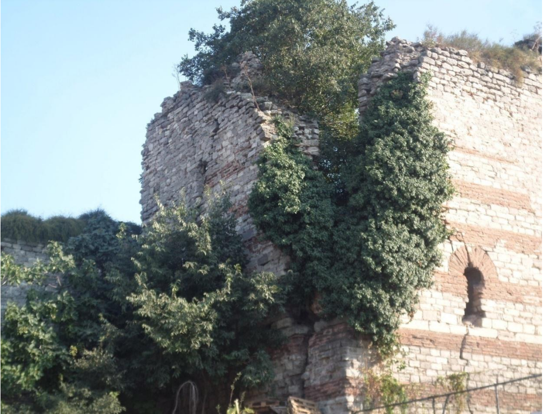
Fotoğraf 168: Topkapı ile Vatan Caddesi Arasındaki Ana Sur Duvarı Üzerinde Yer Alan Burcun Sol Cephesi
