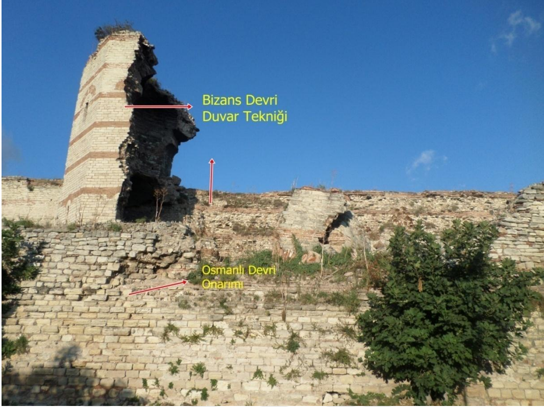
Fotođraf 55: Yedikule Kapı ile Belgrad Kapı Arasında Yer Alan Ana Sur Duvarındaki Burç ve Ön Sur Duvarı
