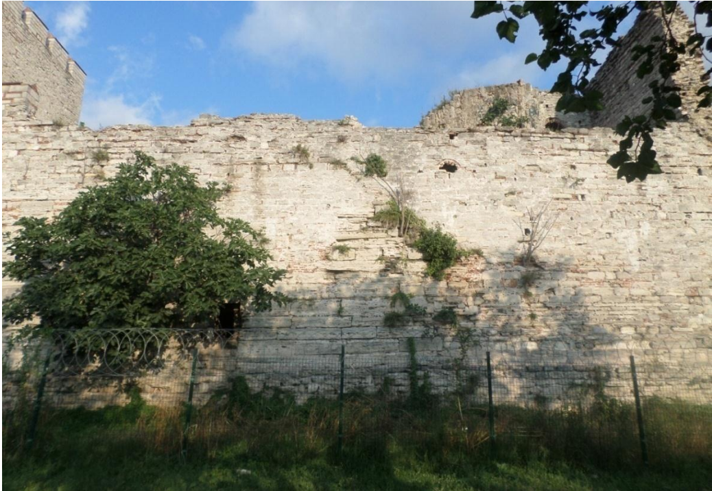
Fotoğraf 132: Mevlevihanekapı ile Millet Caddesi Arasındaki Ön Sur Duvarı
