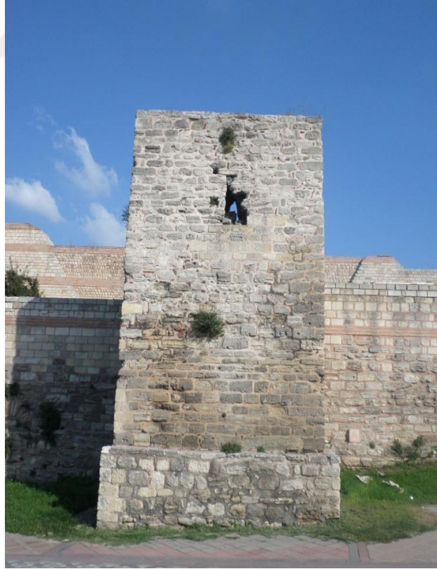
Fotoğraf 160: Topkapı ile Vatan Caddesi Arasındaki Ön Sur Duvarı Üzerinde Yer Alan Kare Burcun Ön Cephesi
