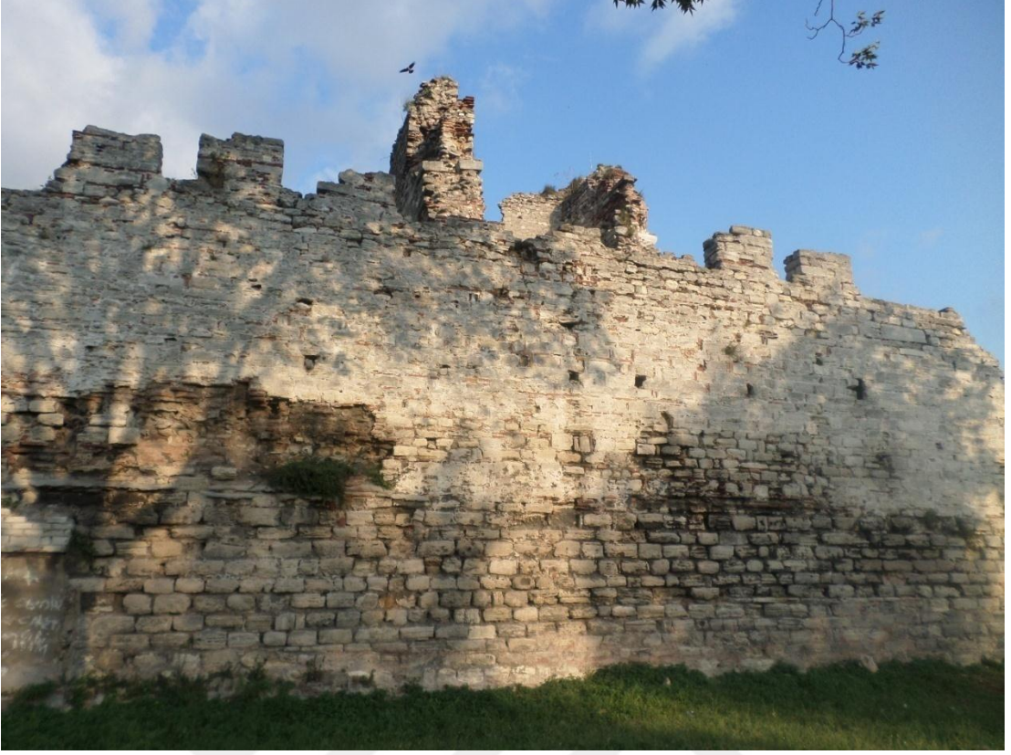
Fotoğraf 129: Mevlevihanekapı ile Millet Caddesi Arasındaki Ön Sur Duvarı
