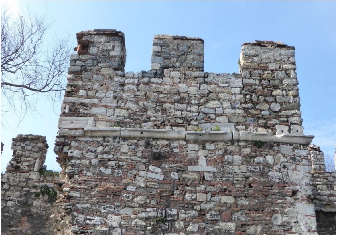
Fotoğraf 342: Marmara Sur Hattında Yer Alan Burcun Ön Cephesi
