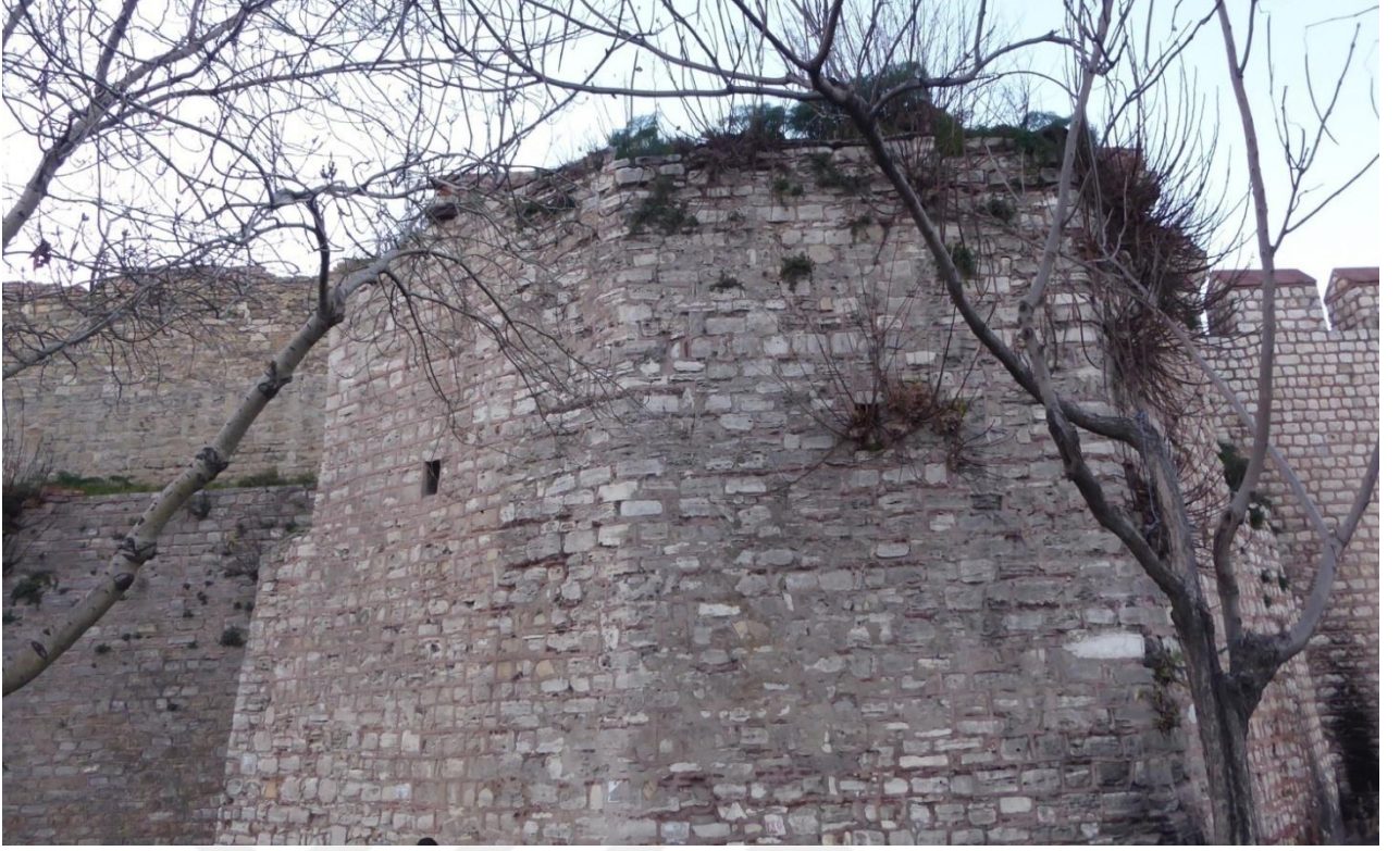
Fotoğraf 421: Narlıkapı ile Mermer Kule Arasındaki Marmara Sur Hattı
