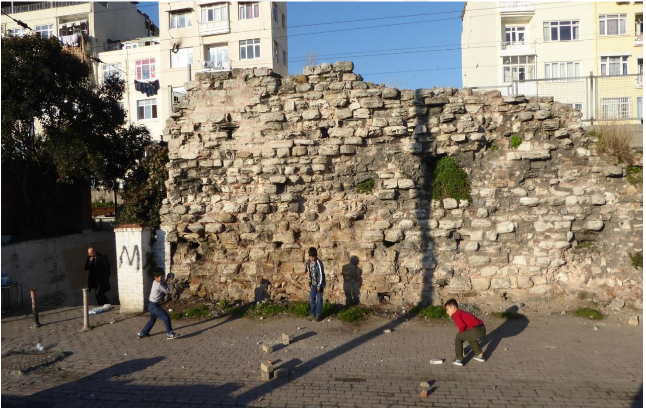
Fotoğraf 400: Marmara Sur Hattı
