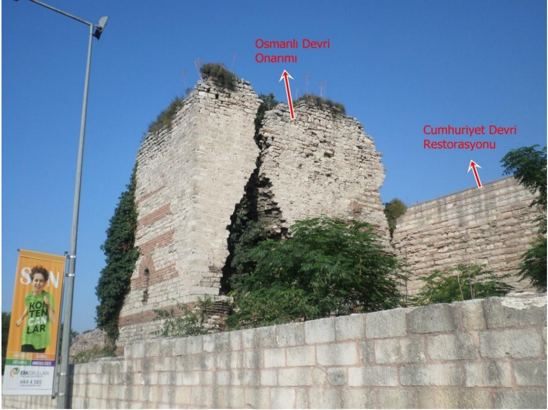
Fotoğraf 165: Topkapı ile Vatan Caddesi Arasındaki Ana Sur Duvarı Üzerinde Yer Alan Burcun Sağ Cephesi ve Ön Sur Duvarı
