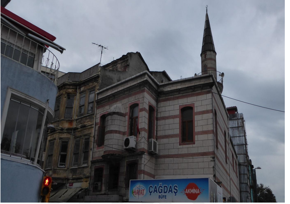
Fotoğraf 291: Ali Yazıcı Camii Güney Cepheden Görünüm
