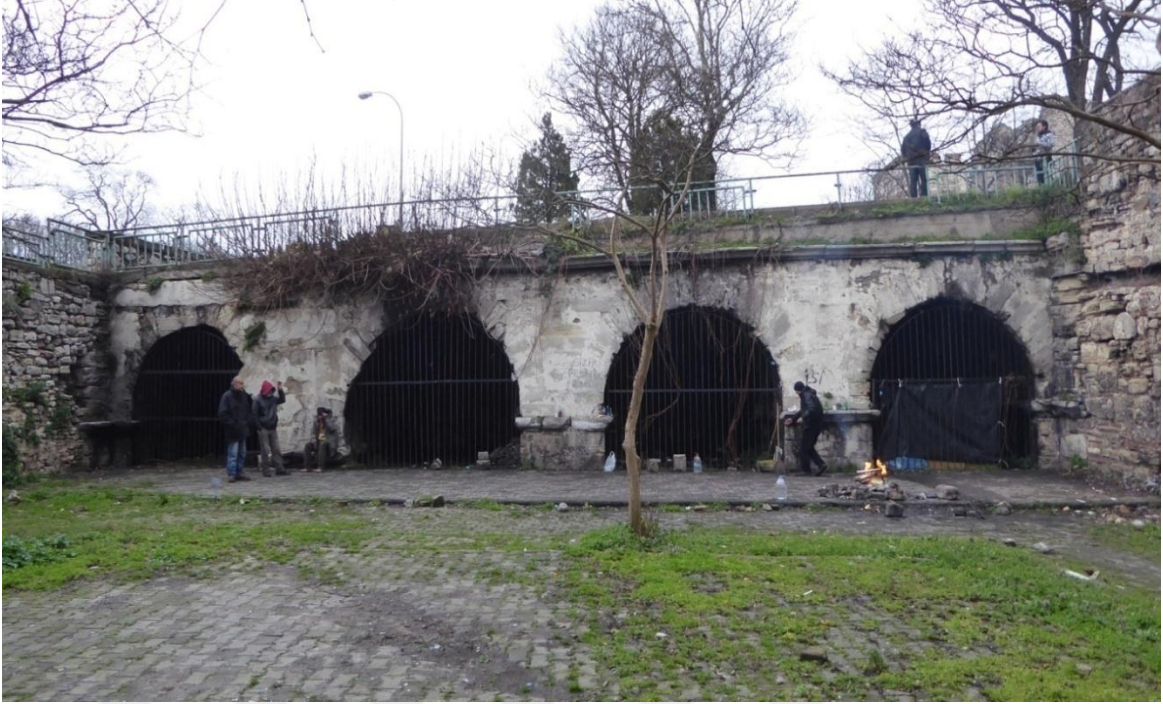
Fotoğraf 203: Edirnekapı Hendek Köprüsü
