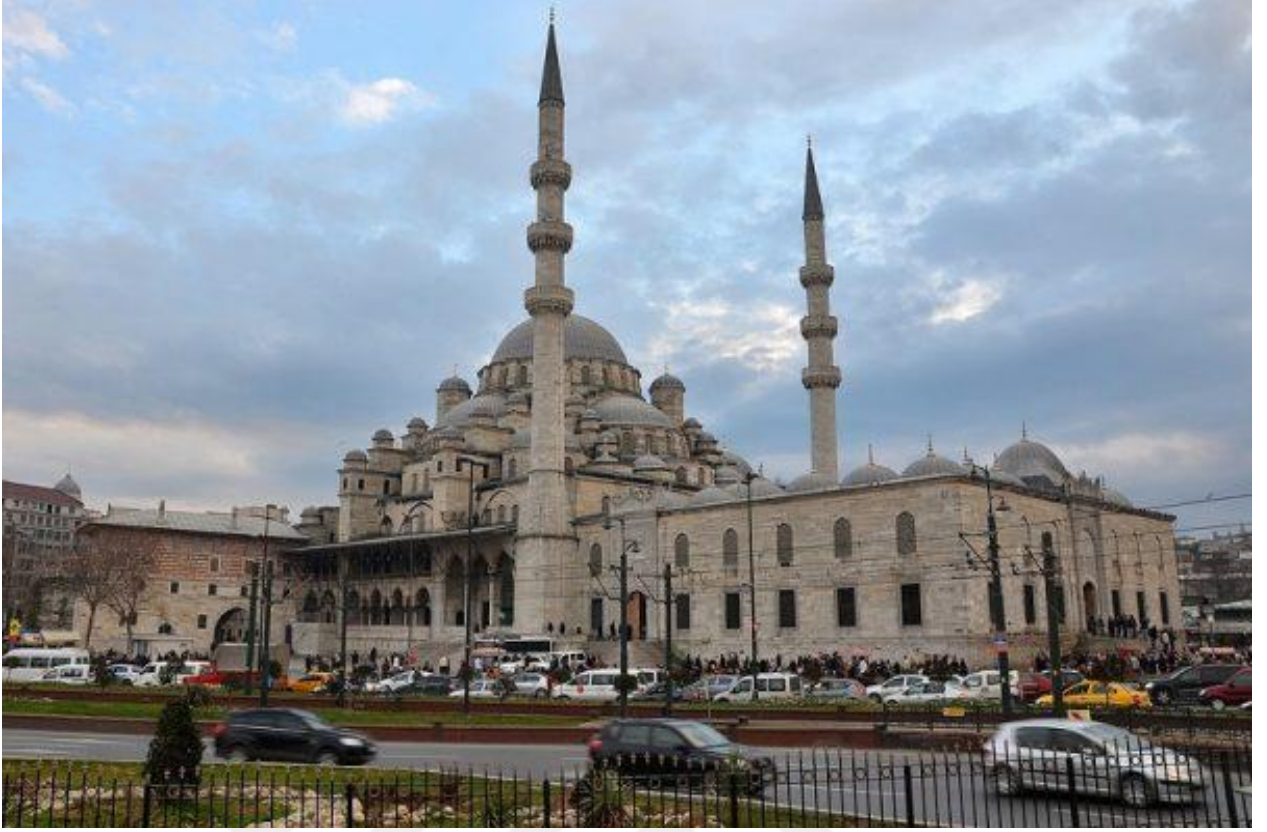
Fotoğraf 325: Eminönü Yeni Camii ve Hünkar Kasrı'nın Genel Görünümü ( http://bit.ly/2JYvN0E )
