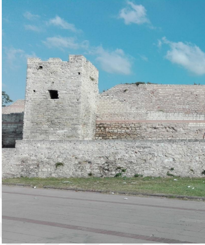
Fotoğraf 151: Topkapı ile Vatan Caddesi Arasındaki Ön Sur Duvarı ve Kare Burç
