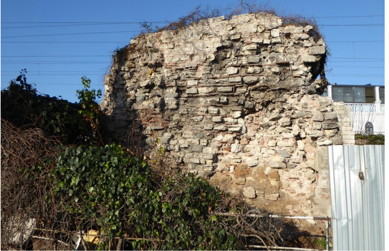
Fotoğraf 395: Marmara Sur Hattı
