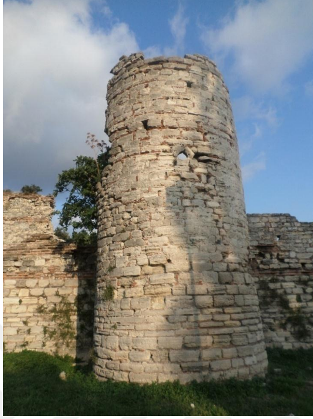
Fotoğraf 127: Mevlavihanekapı ile Millet Caddesi Arasındaki Ön Sur Duvarında Yer Alan Silindirik Formlu Burcun Ön Cephesi
