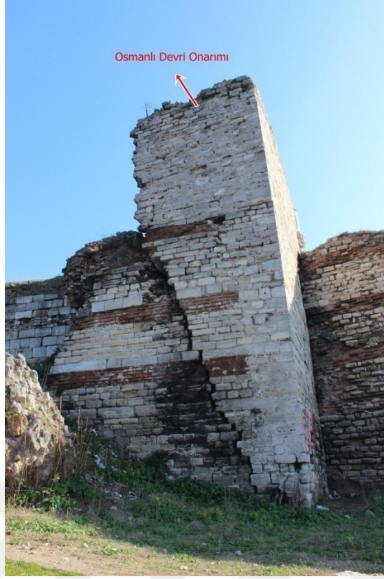
Fotoğraf 201: Sulukule Kapı ile Edirnekapı Arasındaki Ana Sur Duvarında Yer Alan Burcun Ön Cephesi
