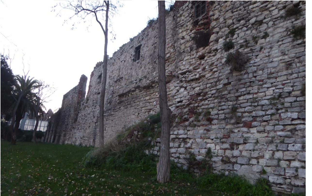
Fotoğraf 422: Narlıkapı ile Mermer Kule Arasındaki Marmara Sur Hattı
