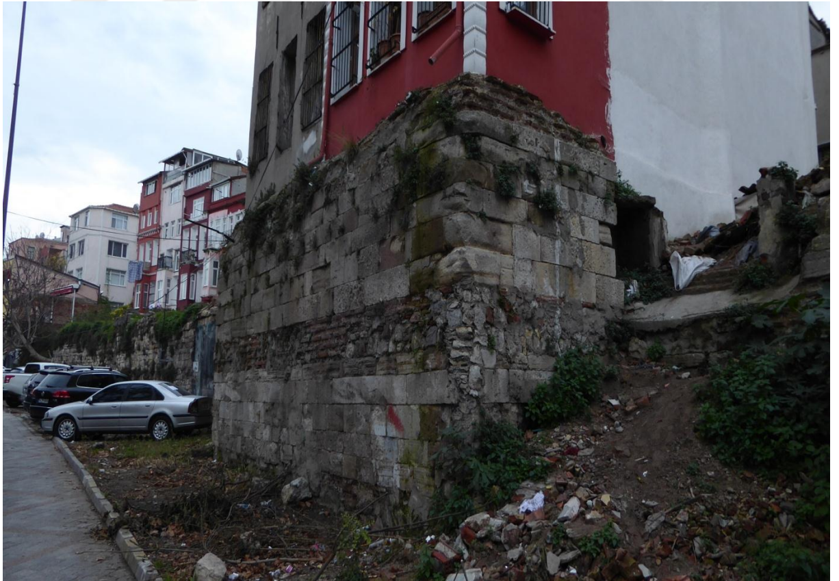
Fotoğraf 286: Üzerinde Bina Yükselen Sur Duvarı
