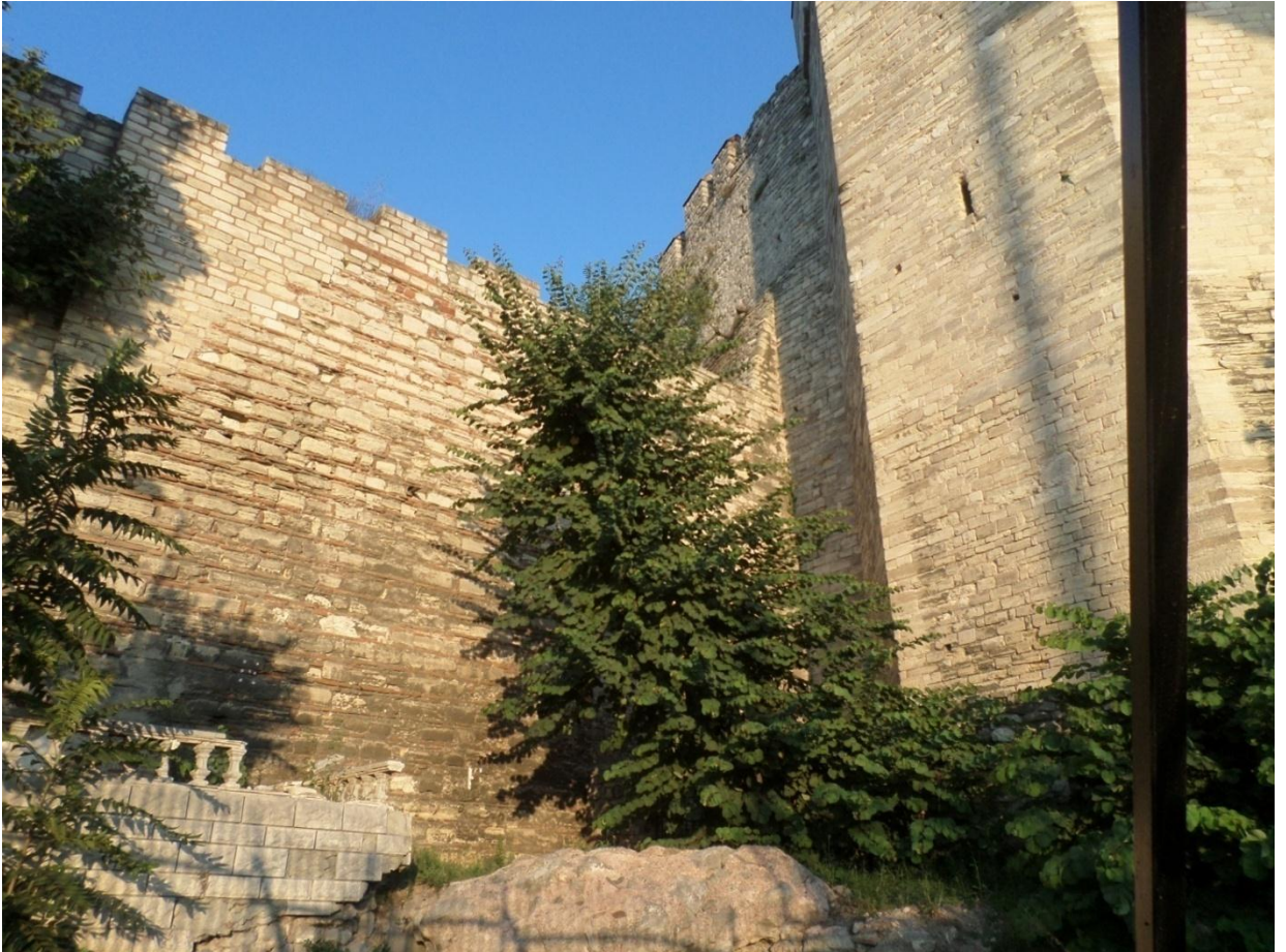
Fotoğraf 32: Yedikule Hisarı Sultan III. Ahmed Devrinde Yenilenen Çokgen Burcun Sur Duvarıyla Birleşmesi
