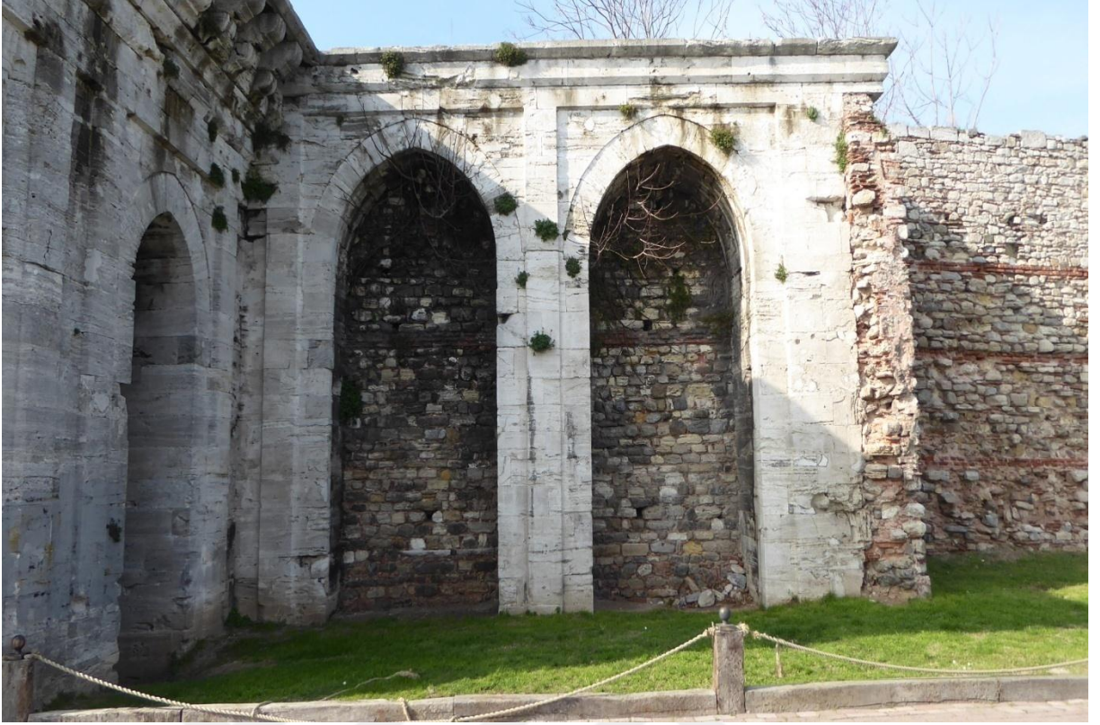
Fotoğraf 355: Sinan Paşa Köşkü'ne Ait platformun Sağ Bölümü
