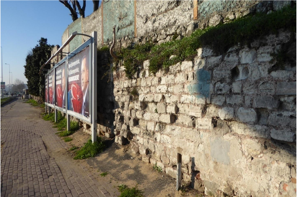
Fotoğraf 396: Marmara Sur Hattı
