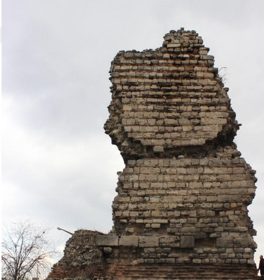
Fotoğraf 170: Vatan Caddesi ile Sulukule Kapı Arasındaki Ana Sur Duvarı Üzerinde Yer Alan Burç Kalıntısı
