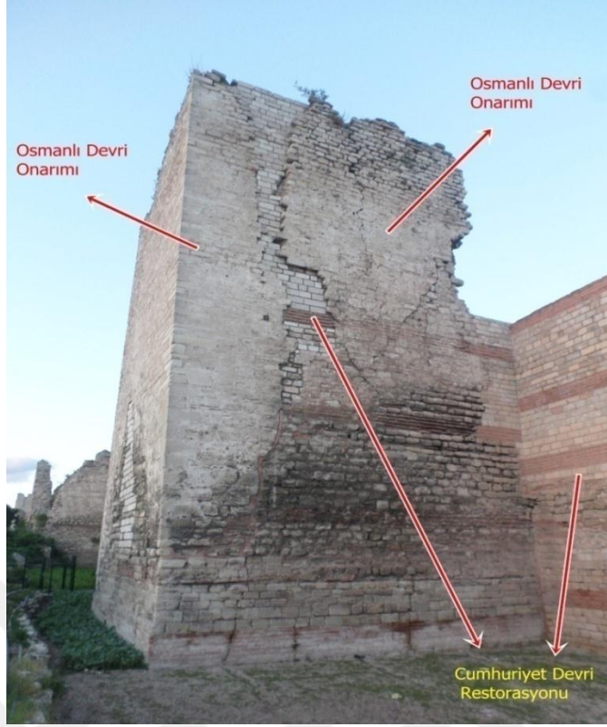
Fotoğraf 73: Belgrad Kapı ile Silivrikapı Arasındaki Ana Sur Duvarındaki Burcun Sağ Cephesi
