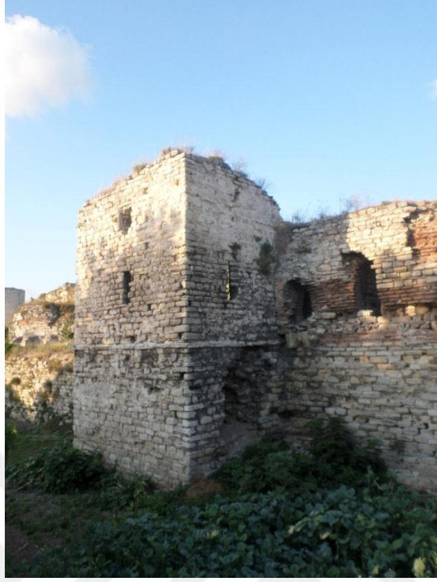
Fotoğraf 41: Yedikule Kapı ile Belgrad Kapı Arasında Yer Alan Ön Sur Duvarı Üzerindeki Kare Burcun Sağ Cephesi
