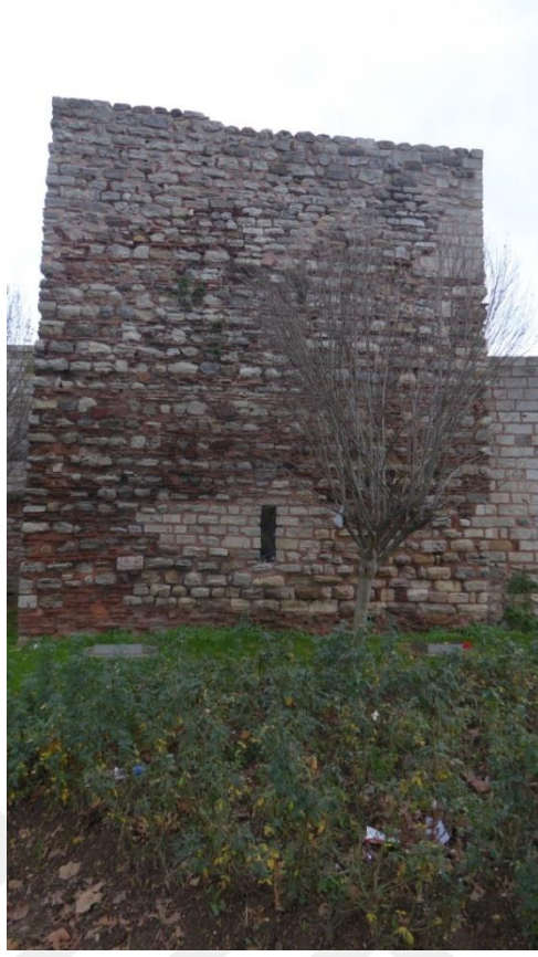
Fotoğraf 273: Ayvansaray Sur Hattı Üzerinde Yer Alan Burcun Sağ Cephesi
