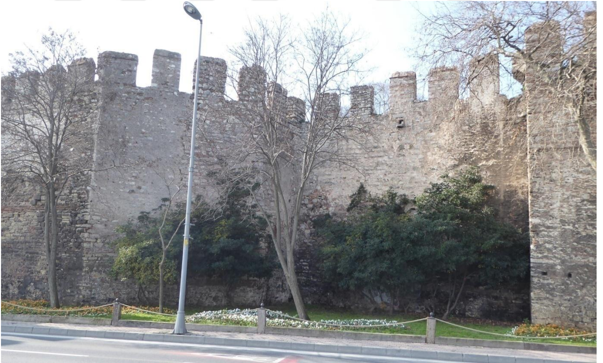
Fotoğraf 332: Marmara Sur Hattı
