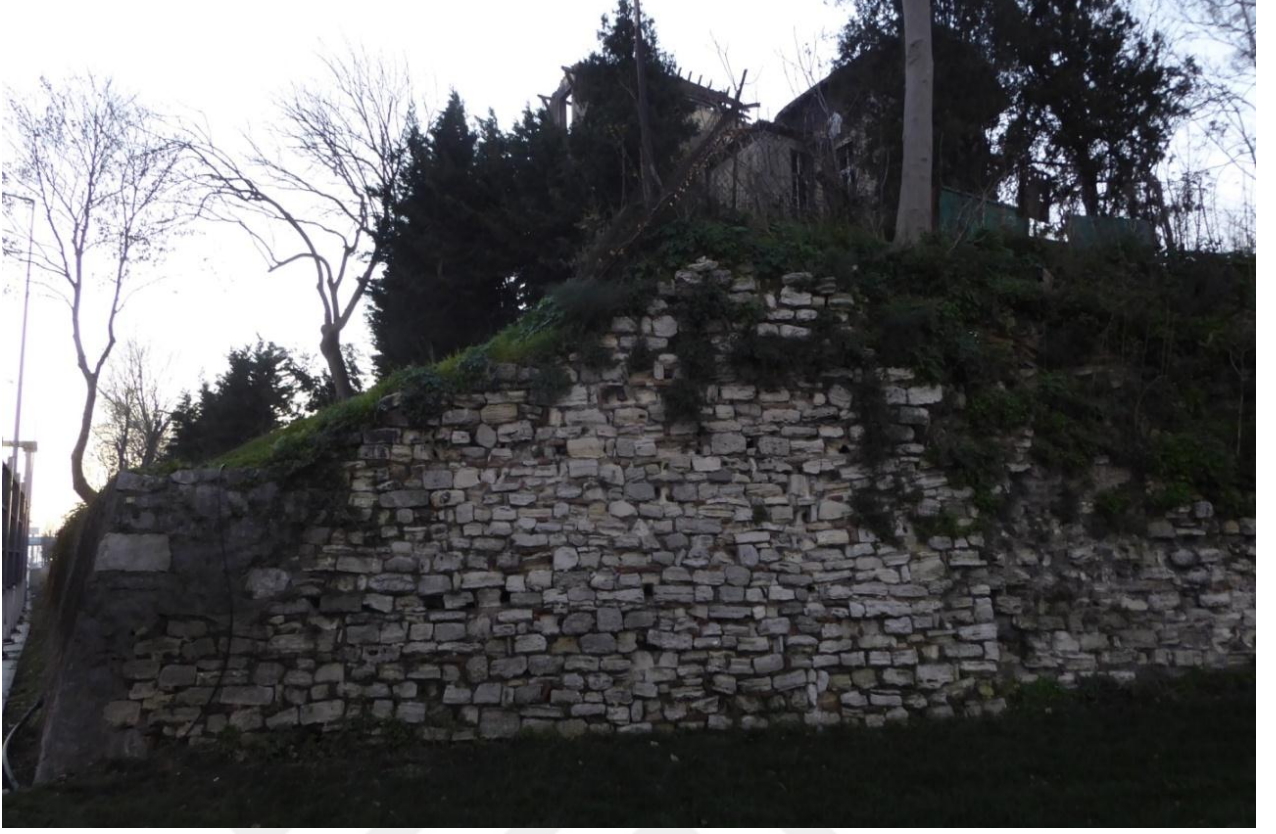
Fotoğraf 431: Narlıkapı ile Mermer Kule Arasındaki Marmara Sur Hattı
