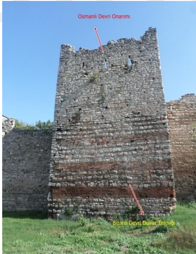
Fotoğraf 254: Eğrikapı ile Ayvansaray Arasındaki Sur Hattında Yer Alan Kare Burcun Ön Cehesi
