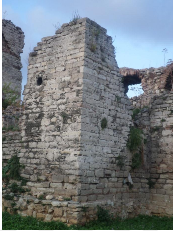
Fotođraf 107: Silivrikapı ile Mevlevihanekapı Arasındaki Ön Sur Duvarında Yer Alan Kare Burcun Sađ Cephesi
