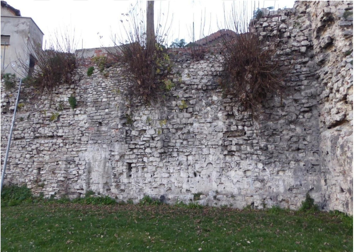
Fotoğraf 426: Narlıkapı ile Mermer Kule Arasındaki Marmara Sur Hattı
