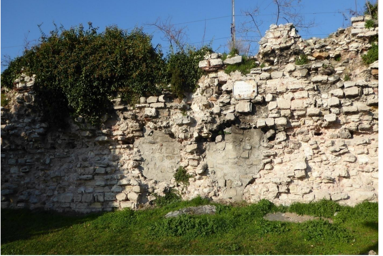
Fotoğraf 389: Marmara Sur Hattı
