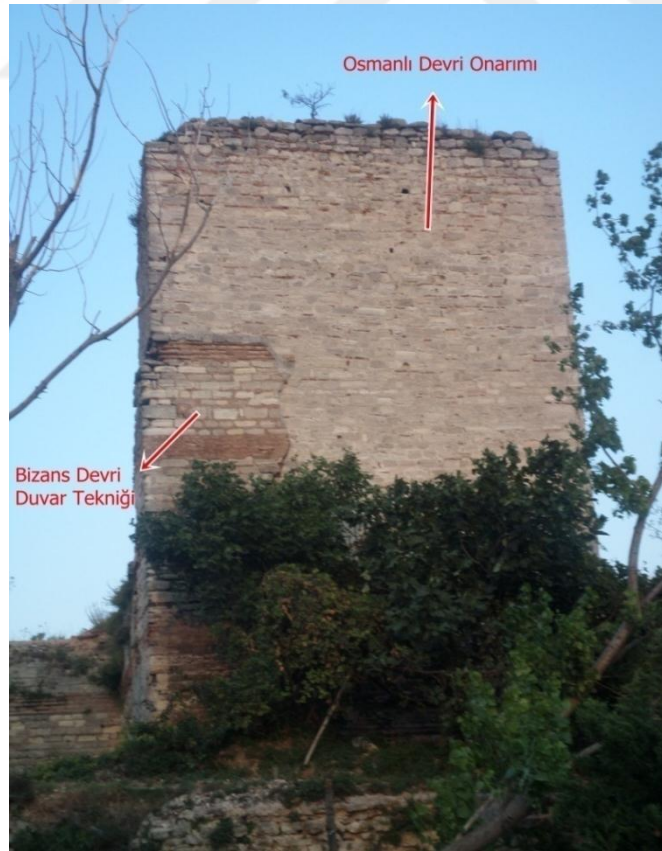
Fotoğraf 104: Silivrikapı ile Mevlevihanekapı Arasındaki Ana Sur Duvarında Yer Alan Burcun Ön Cephesi
