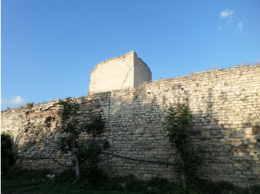
Fotoğraf 47: Yedikule Kapı ile Belgrad Kapı Arasında Yer Alan Ana Sur Duvarı Üzerindeki Burcun Ön Cephesi ve Ön Sur Duvarı
