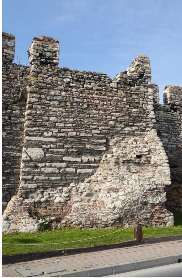
Fotoğraf 347: Marmara Sur Hattında Yer Alan Burcun Ön Cephesi
