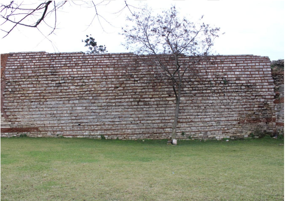
Fotoğraf 176: Vatan Caddesi ile Sulukule Kapı Arasındaki Ana Sur Duvarı
