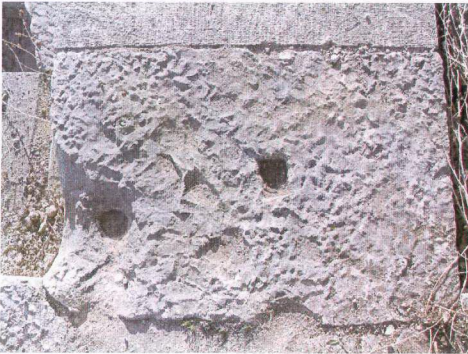
3. Üst döşeme 3 no.lu blok
