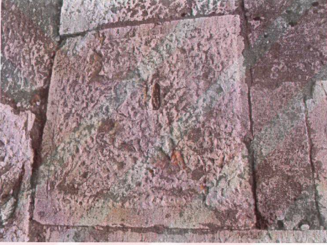
2. Üst döşeme 5 no.lu blok
