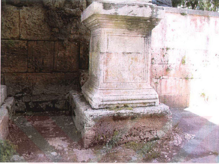
1. Kuzeydoğu köşe yarı yüksekliğe kadar orijinal postament
