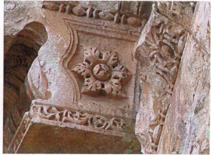
6. Arka cephe konsolu güney yan yüz
