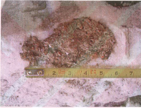
2. Kırılmış seramik ve tuğla parçalı pembe harç kalıntısı (K12)
