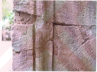
3. Kuzeydoğu köşe postamenti profilli iç ve yan yüzleri
