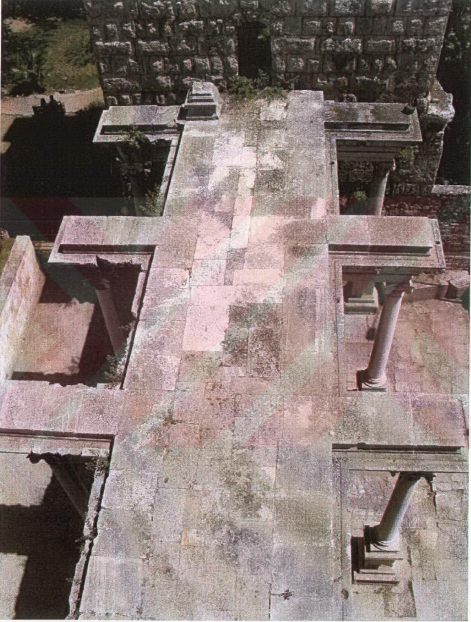
Tak üst yüzey kuzey kuleden görünüş.
