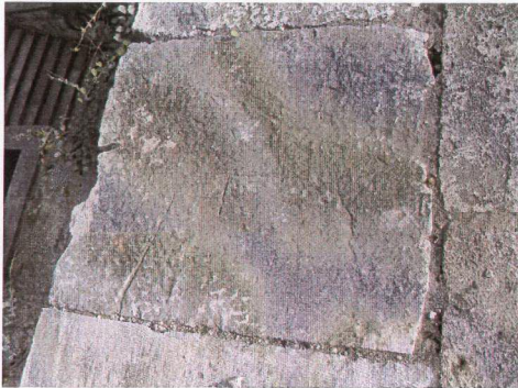
3. Üst döşeme 9 no.lu blok
