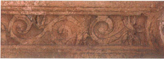
2. Kuzey arkhitrav soffiti ve detayı
