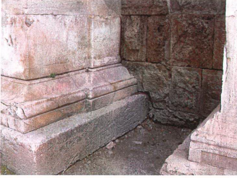
1. Güney altlık batı köşesi
