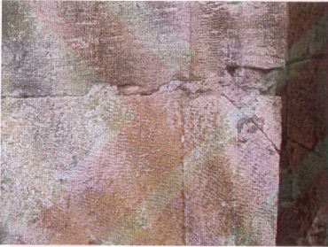
2. Kuzeydoğu köşe postamenti doğu yüzü
