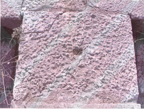
2. Üst döşeme 2 no.lu blok
