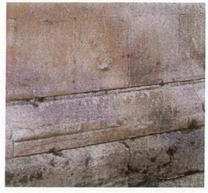
7. III. tonozun merkeze bakan ayakta daire kesitli çıkıntılar
