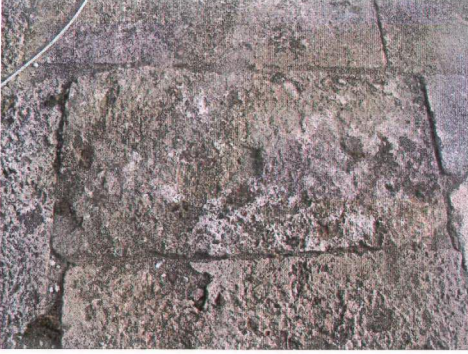
1. Üst döşeme 7 no.lu blok
