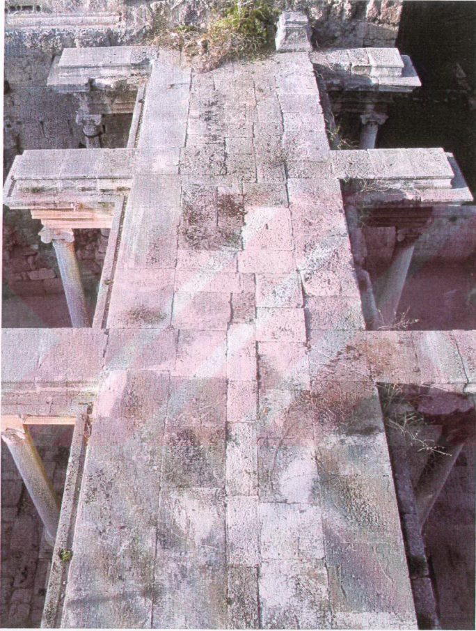
Tak üst yüzey güney kuleden görünüş.
