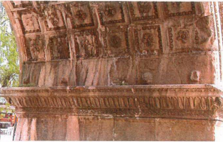
6. III. tonoz üzengi bloklarında daire kesitli çıkıntılar
