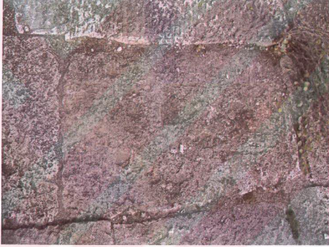
2. Üst döşeme 8 no.lu blok
