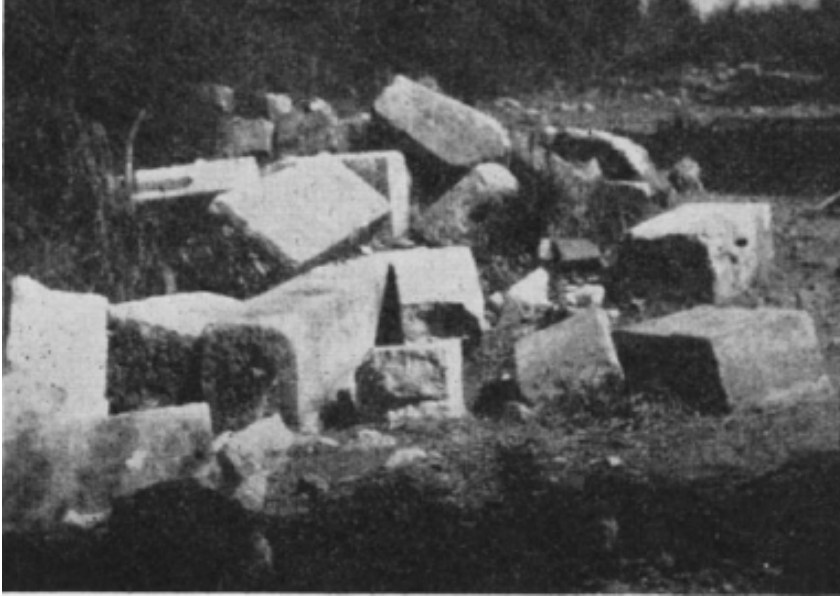
Res. 13: Kaunos Çeşme Binası'nın Restorasyon Öncesi Durumu [Bean, Caunus II, s. 96 Fig. 47'den].
