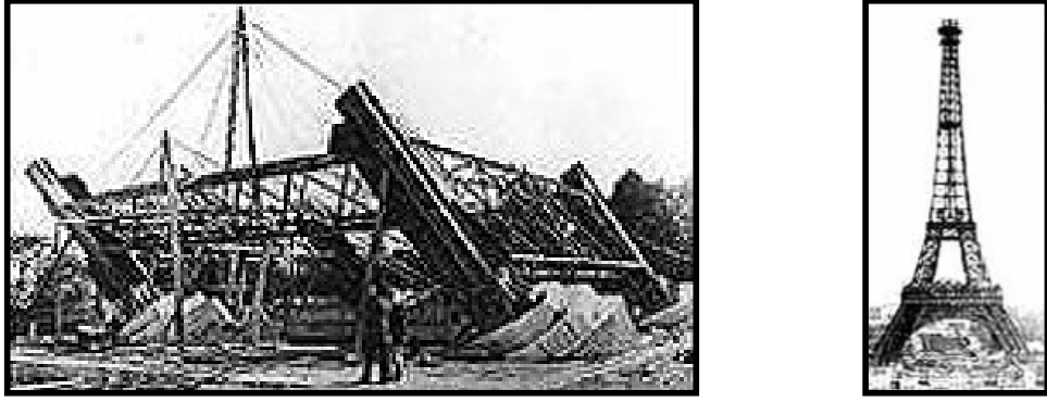
Resim 3.14 Eiffel Kulesi Yapım Aşaması, Eiffel Kulesi
