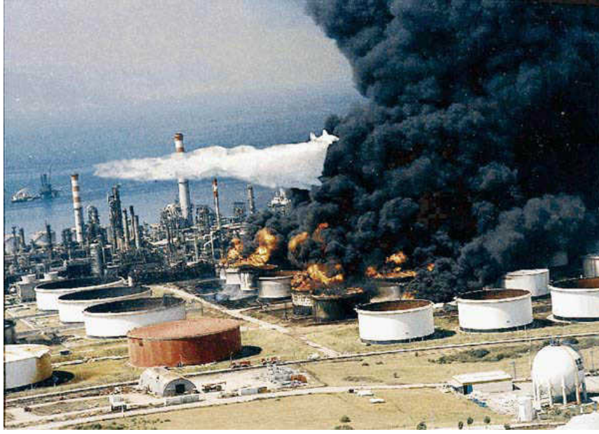
Şekil 4.10 Marmara Depremi sonrası Tüpraş yangını (Hürriyet)
