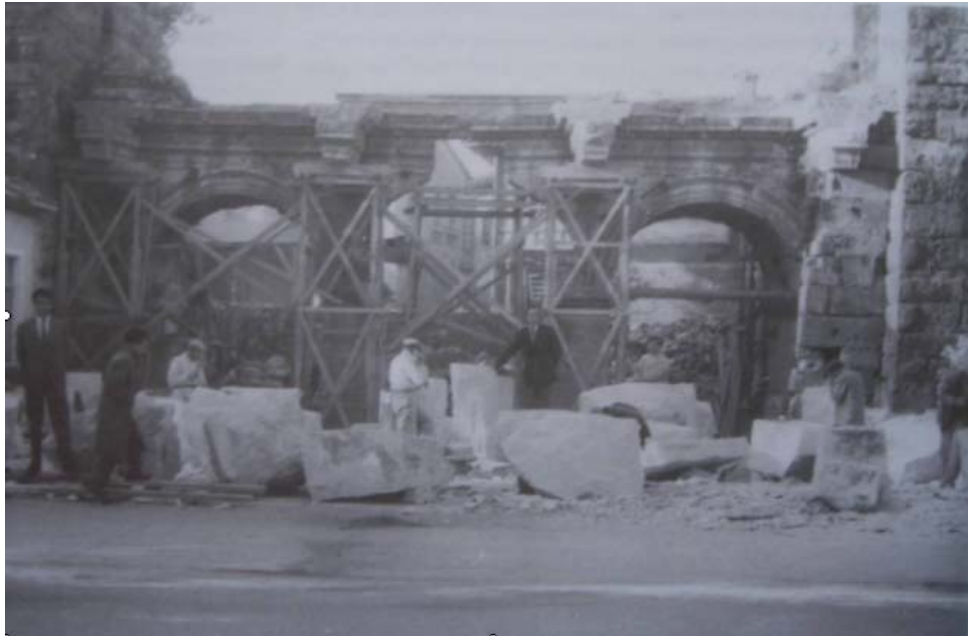
Res. 6 Hadrian Takı'nın restorasyon çalışmaları sırasındaki hali. (Fot. Okatan)
