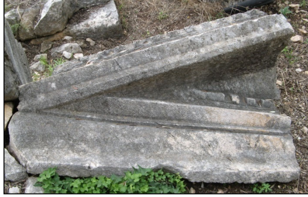
b. Çatı görünüş.
