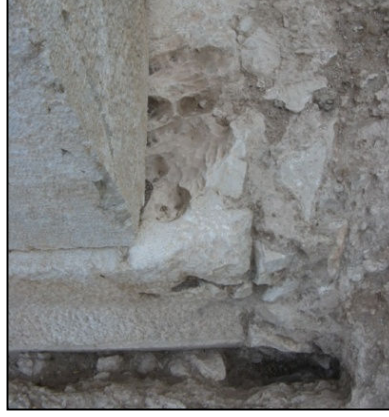
a. Podyum güneydoğu köşe ayrıntı görünüş.
