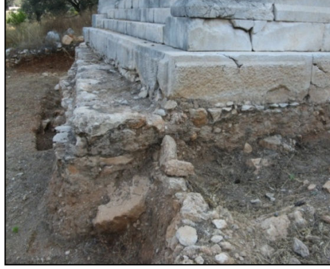
a. Temel ve podyum, güneybatı köşe.
