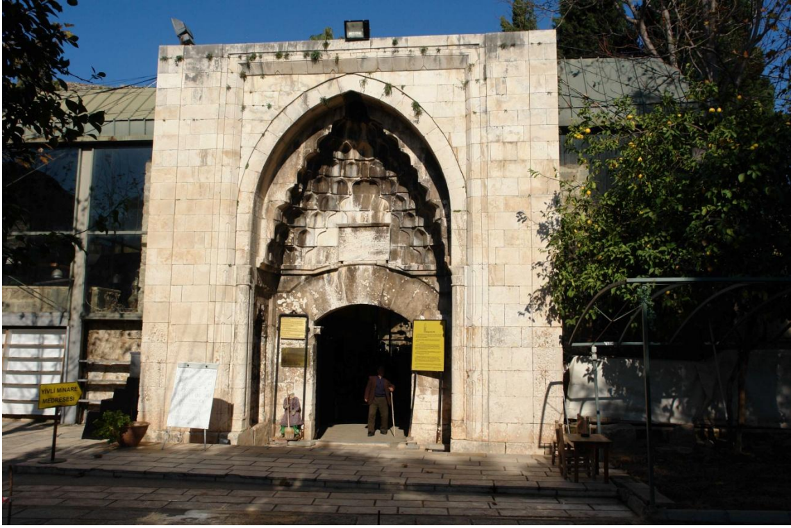
Resim 19a: Yivli Minare Medresesi, Giriş Kapısı Görüntüsü.
