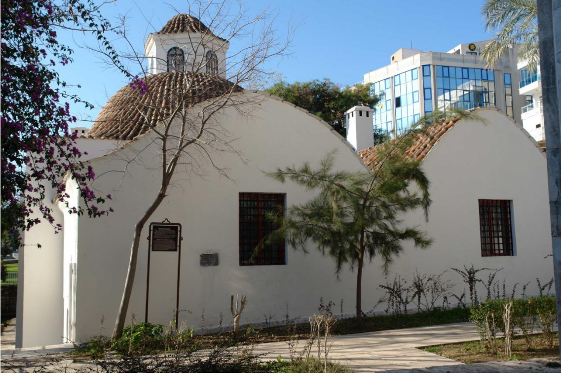
Resim 20a: Yivli Minare, Mevlevihane, Devlet Güzel Sanatlar Galerisi Dış Görünüşü.
