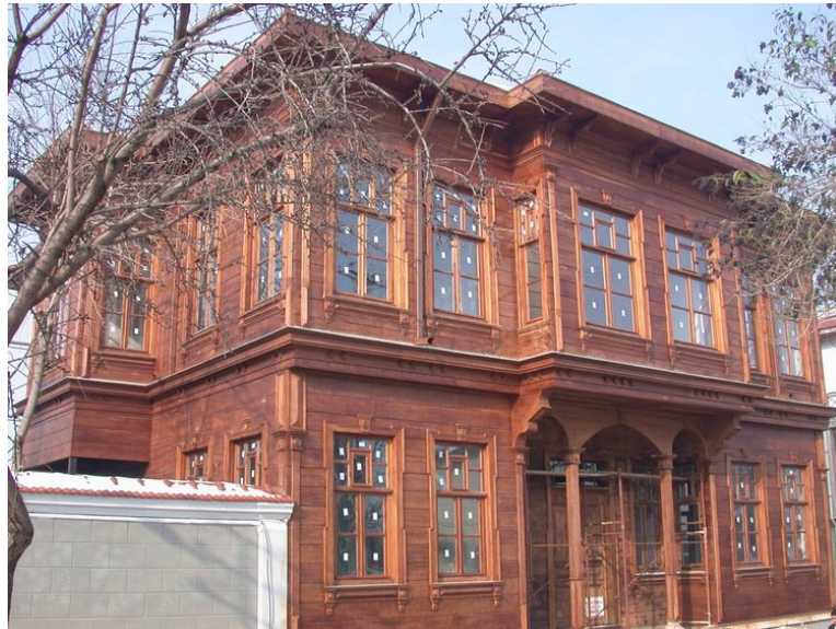
Resim 22: Hafız ağa Konağı cephe görünüşü
