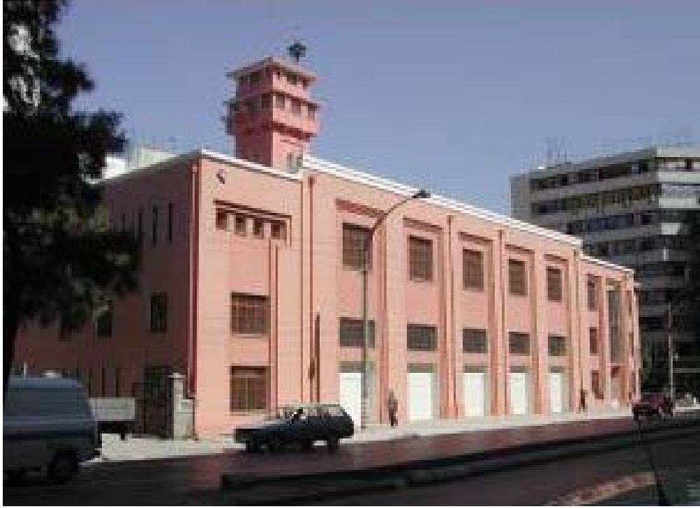
Resim 13: Müze binası olarak restore edilmiş hali
