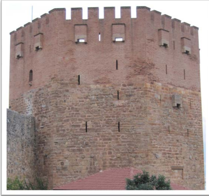
Levha 68. Dış Cephelerde Tuğla Malzeme Üzerinde Görülen Bozulmalar (Foto Derya Pekgözlü Karakuş).
