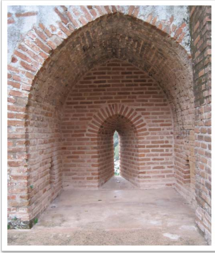
Levha 69. İkinci Kat Eyvanlarının Tuğla İle Örtülü Tonzlarında Görülen Bozulmalar (Foto Derya Pekgözlü Karakuş).
