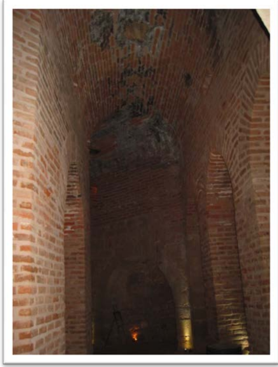
Levha 28. Birinci Katta Üzeri Tonozla Örtülü İki Adet Koridor (Foto Derya Pekgözlü Karakuş).
