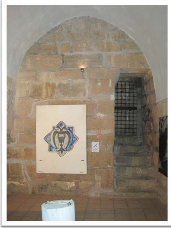
Levha 22. Üzeri Sivri Kemerli Tonozla Örtülü Giriş Holü Niteliğindeki Eyvan (Foto Derya Pekgözlü Karakuş).
