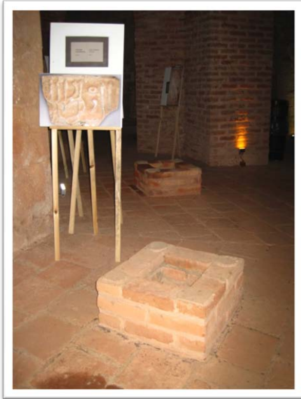
Levha 29. Birinci Kattaki Havalandırma Bacaları (Foto Derya Pekgözlü Karakuş).
