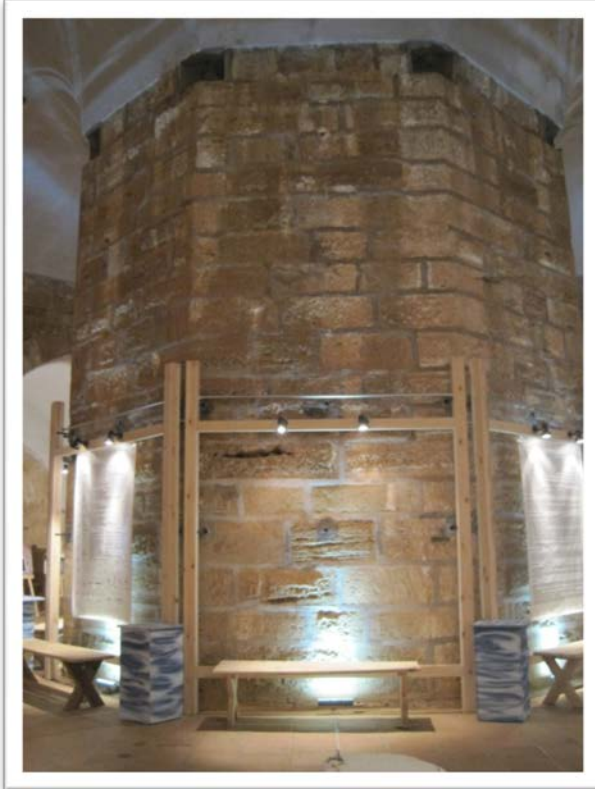
Levha 21. Zemin Katın Tam Merkezindeki Sekizgen Şekilli Fil Ayağı (Foto İlhami Yetkin).
