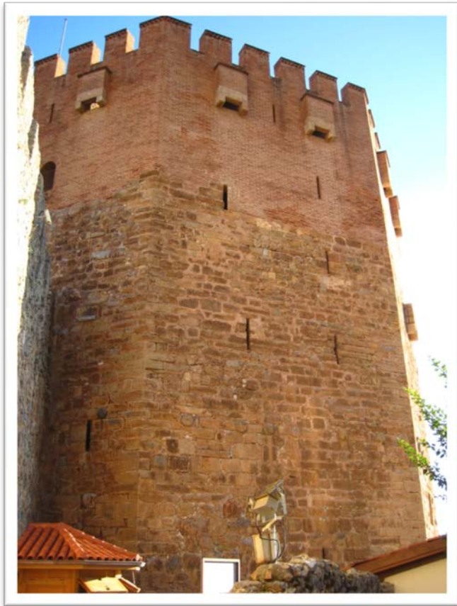
Levha 47. Kızıl Kule'nin Güneybatı Cephesi (Foto Derya Pekgözlü Karakuş).
